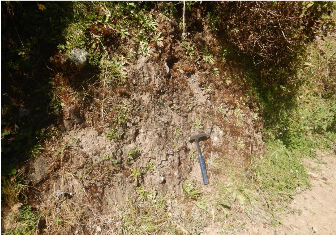
Fotografía 2 . Vista de un depósito coluvio-deluvial, conformado por bloques, hasta de 1 m, gravas, arenas, limos y arcillas.
