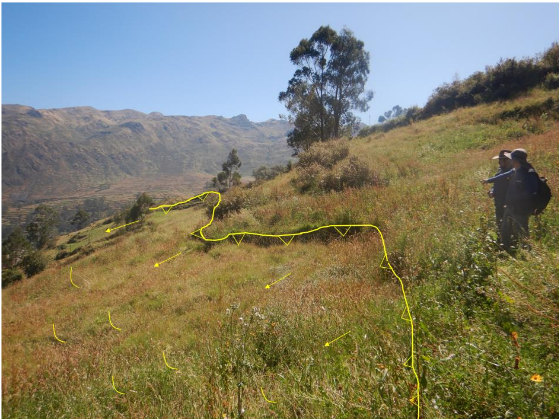
Figura 11. Corona del de deslizamiento reactivado, con un salto visible de 60 cm
