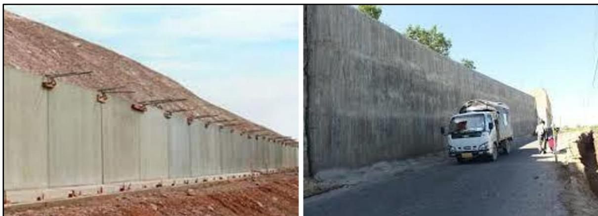
Figura 15. Ejemplo de muros de contención para los derrumbes y sujeción de la avalancha de detritos.
