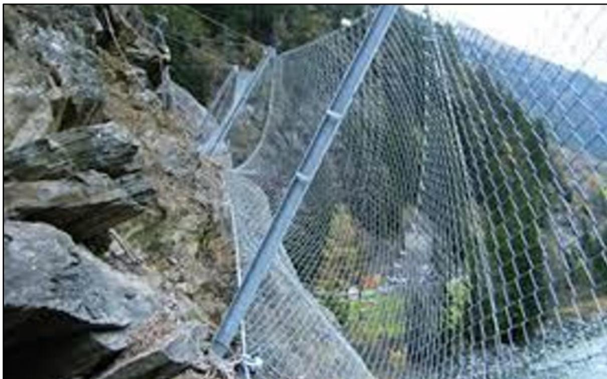
Figura 14. Ejemplo de barreras dinámicas de protección frente a la caída de rocas.
