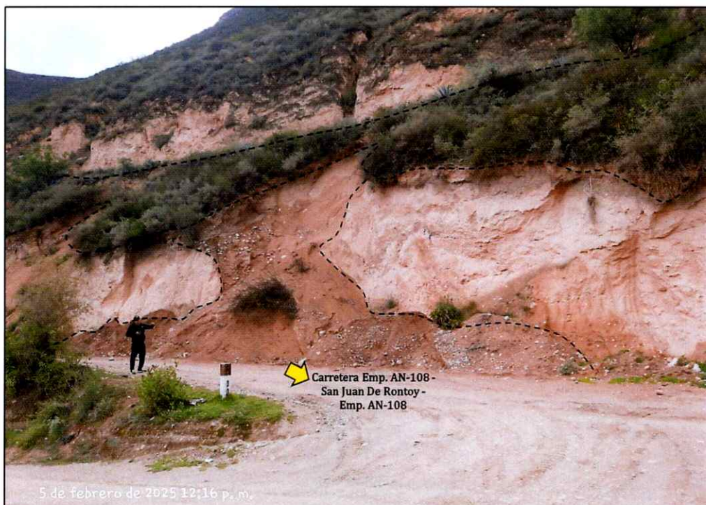
Ilustración 29. Deslizamiento y flujo de lodos del talud en el cruce Patarin.
