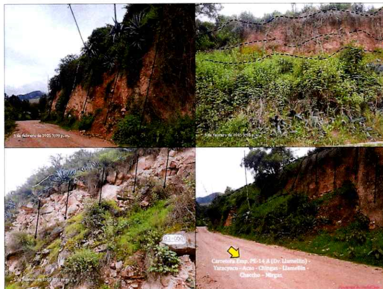
Ilustración 16. Deslizamiento, derrumbes y caída de rocas en la carretera Emp. PE-14 A (Dv. Llamellín) - Yaracyacu - Aczo - Chingas - Llamellín - Chaccho - Mirgas.
