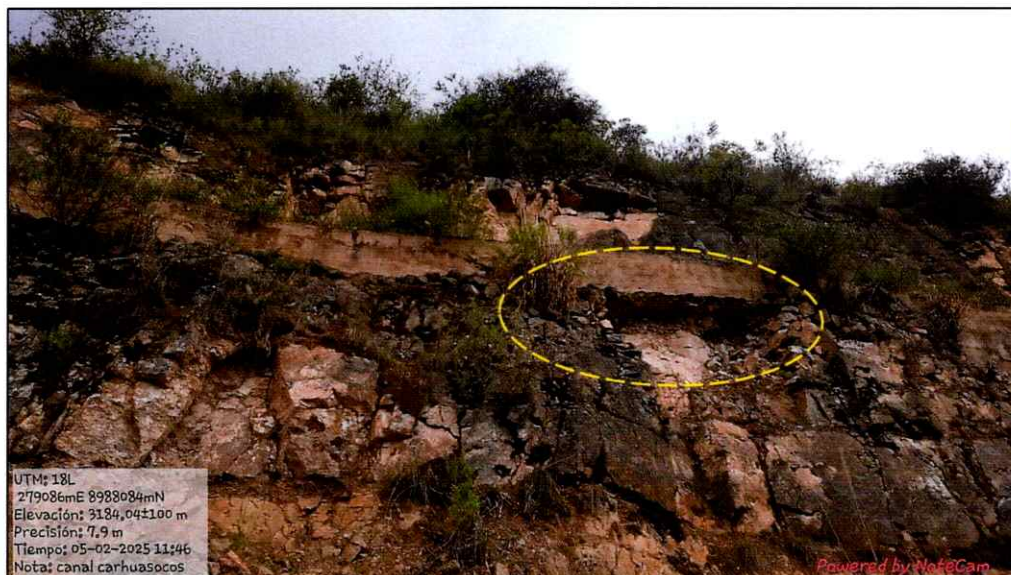
Ilustración 25. Base del canal debilitado por la caída de rocas y derrumbes del talud.
