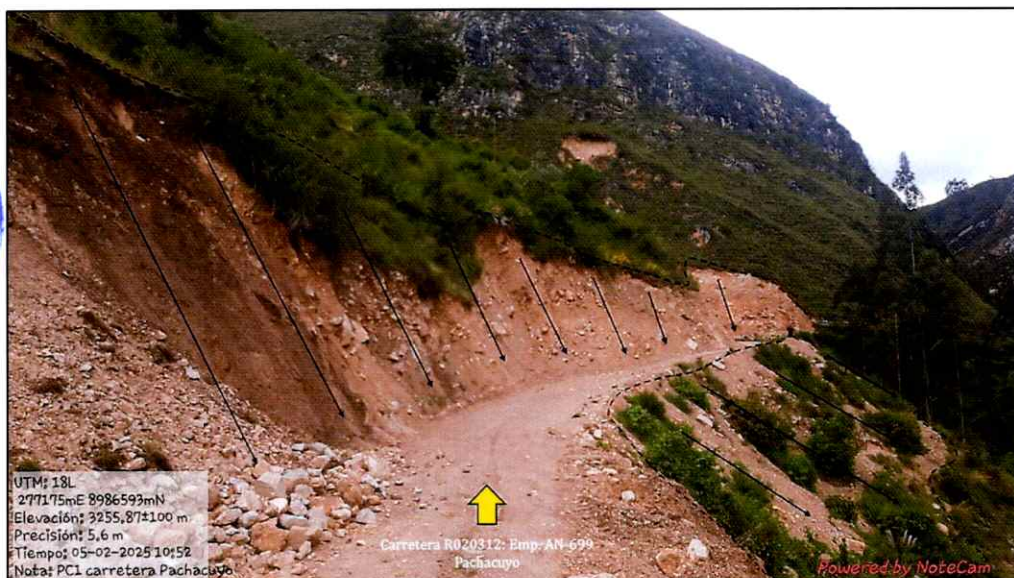
Ilustración 18. Zona de deslizamiento y derrumbe sobre la carretera R020312: Emp. AN-699 Pachacuyo.
