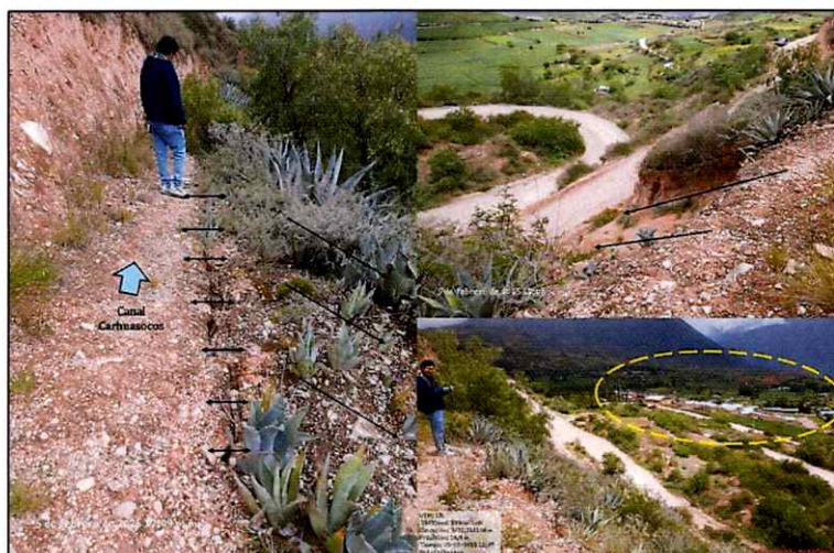
Ilustración 30. Formación de grietas e inicio de deslizamiento del talud sobre el que se asienta el canal.
