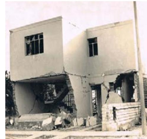
F-4.11a. Vivienda de albañilería, Chimbote Sur. 31.May.1970. Defectos: no tiene columnas de concreto armado de refuerzo. Poca rigidez (muy flexible) y escasa resistencia en la dirección paralela a las fachadas. Las fachadas principal y posterior colapsaron. La escalera que es rígida, perforó el muro lateral izquierda
