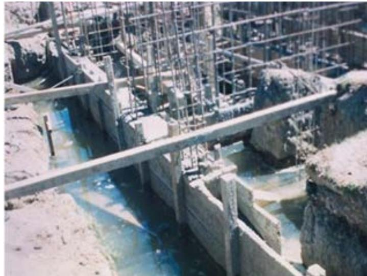
**F-3.03 e.** Vivienda nueva en reconstrucción, 1973, con mayor refuerzo de la estructura resistente por construir en un sector con peligro natural alto. Note como el agua ha inundado la zanja de la cimentación.
