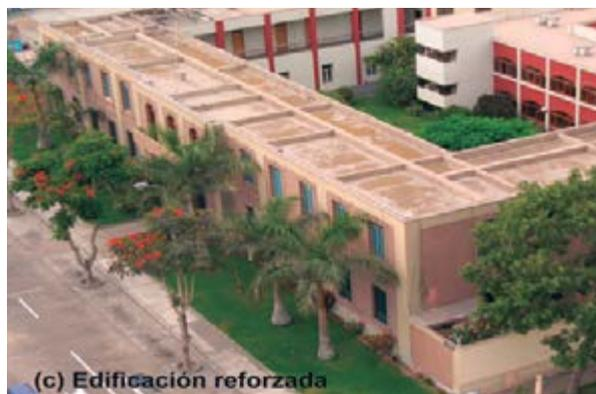
F-4.15. Note que las columnas de la fachada principal e interiores y las vigas invertidas sobre el techo, forman un sistema espacial firmemente conectados entre sí, y con las nuevas columnas.
