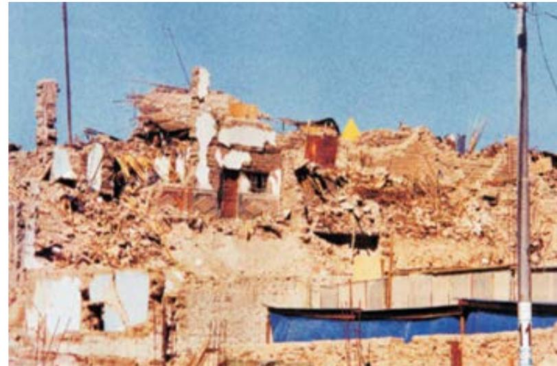
**F-3.05 b)** Casa dañada por el asentamiento del suelo, causado por licuación de suelos hacia el oeste de la ciudad de Arequipa, donde un cerro represa el agua subterránea del río Chili, elevando el nivel freático.
