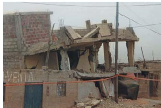
**F-3.07.** Edificaciones de concreto armado y de albañilería de bloques de concreto sufrieron daños severos. Suelos no consolidados, rellenados recientemente. Cono Norte de Tacna. Sismo de 2001.
