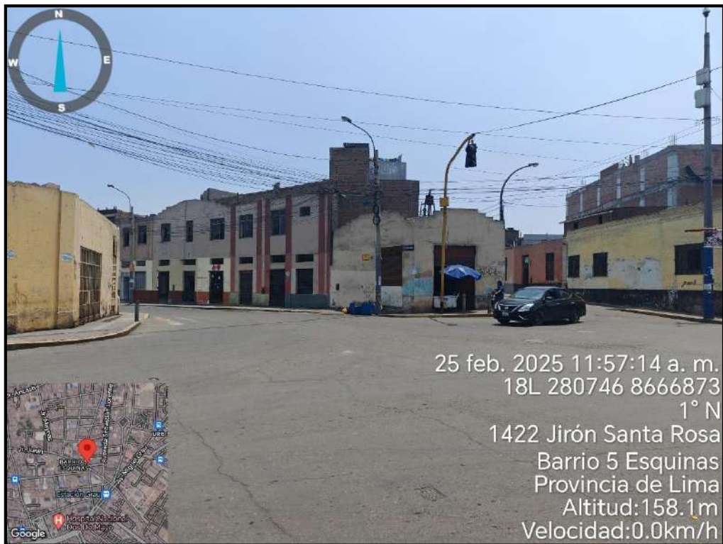
Figura 25. Verificación In Situ de Puntos Críticos en Cercado de Lima
