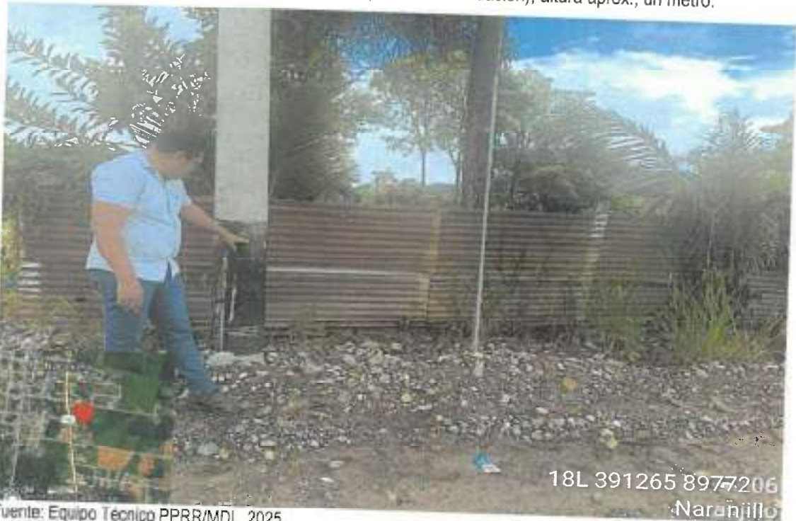
Foto N°3. Identificación de la marca de agua (altura de inundación), altura aprox., un metro.
