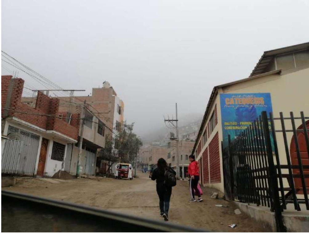
Se observan viviendas de dos a más niveles en el AAHH VALLE DEL MANTARO DEL PERÚ I ETAPA
