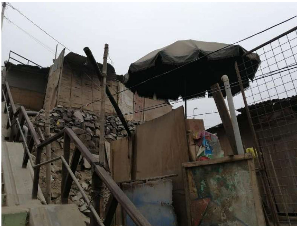
Punto de acopio de residuos en el SEGUNDO MERCADO LOPEZ.
