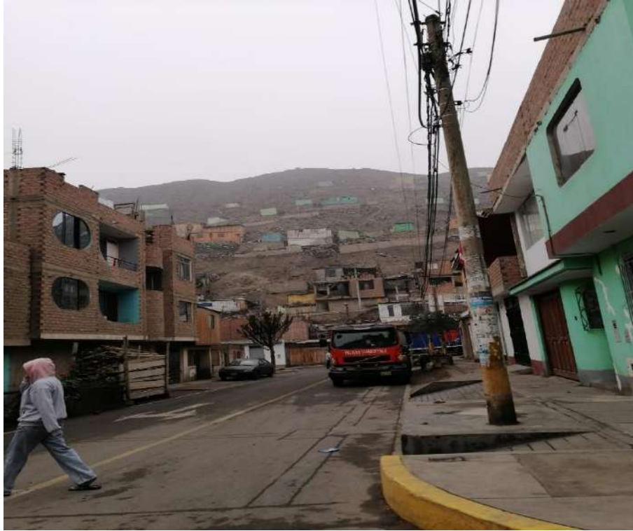
Viviendas con paredes de ladrillo y techos de losa y calamina en el AAHH EL MIRADOR DE ATE.
