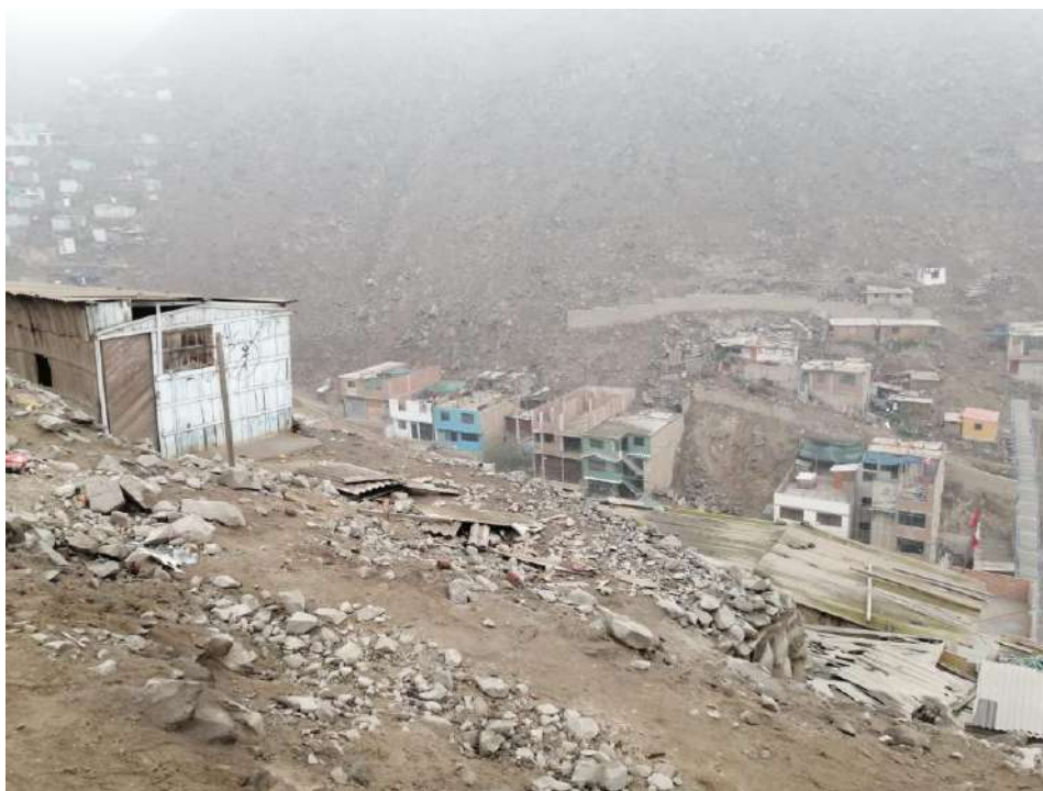
Vivienda construida con paredes de madera y techo de lamina en AAHH JARDINES DE SANTA CLARA.
