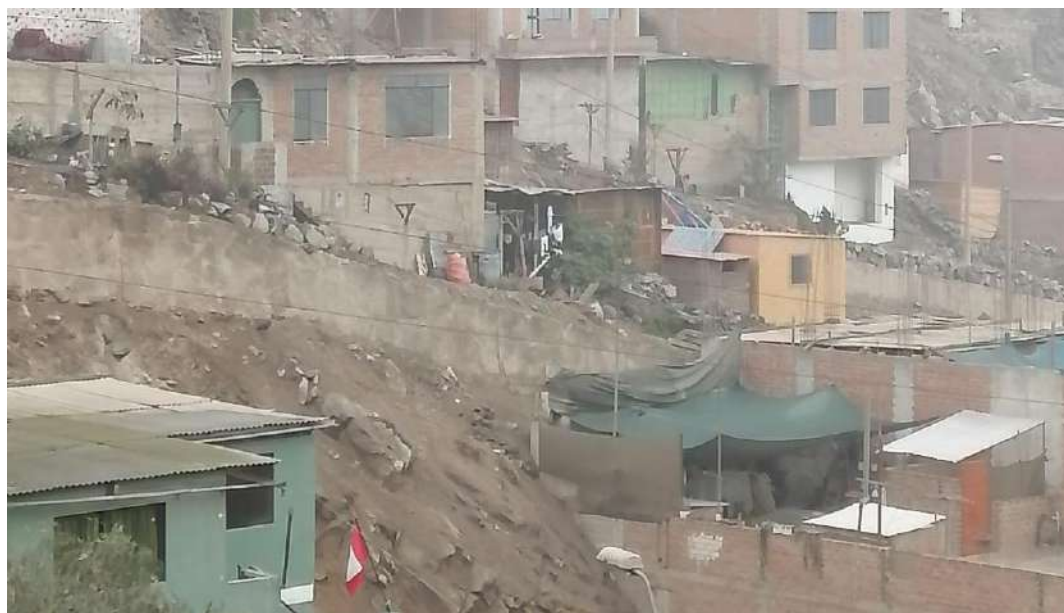
Vista de viviendas fabricadas con paredes de ladrillo en el AAHH ANDRES AVELINO CACERES.
