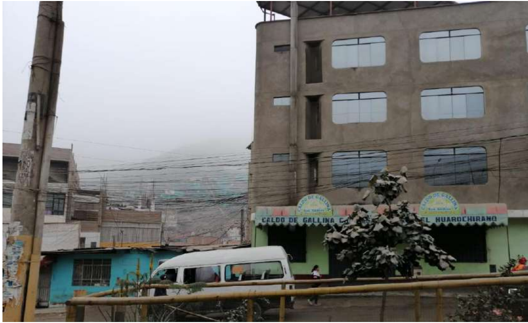
Vivienda de cuatro niveles con el primero destinado al comercio en el AAHH VALLE DEL MANTARO DEL PERÚ II ETAPA
