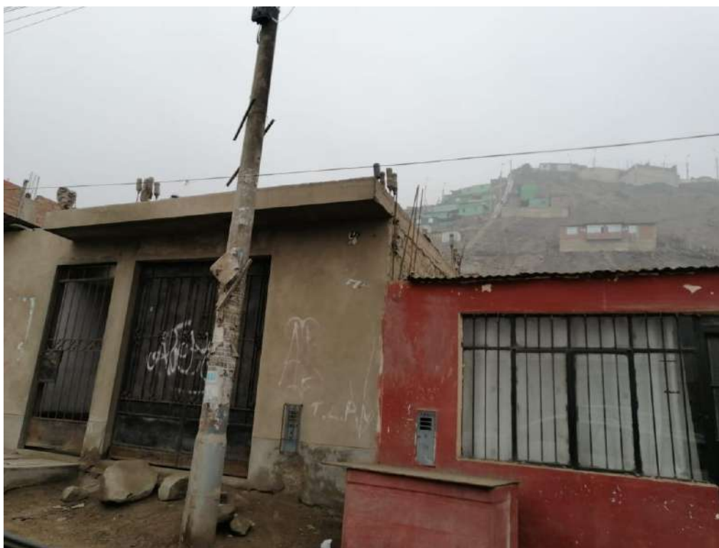
Viviendas con paredes de ladrillo y techos de losa y calamina en el AAHH SEÑOR DE MURUHUAY SECTOR A.
