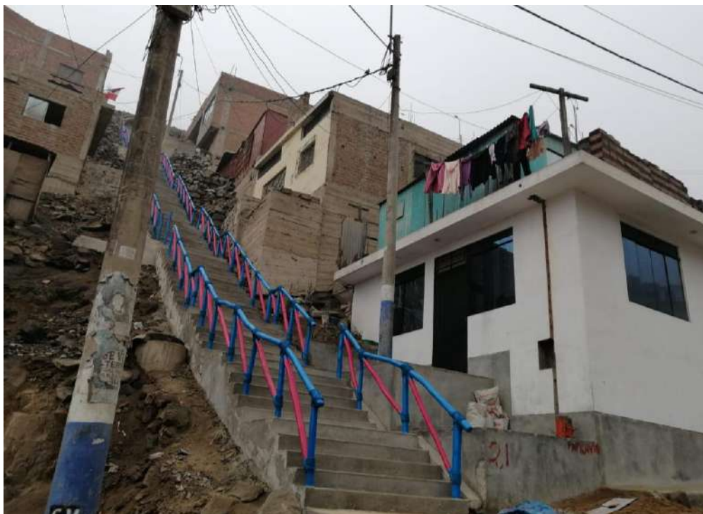
Se observan viviendas con paredes de ladrillo y escaleras con ambas barandas en el AAHH ANDRES AVELINO CACERES.
