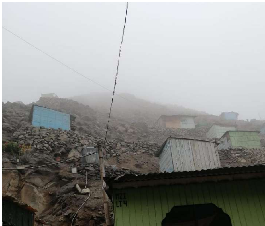
Viviendas construidas con paredes de madera y techo de calamina en la parte alta del AAHH ANDRES AVELINO CACERES-PARCELA 5.
