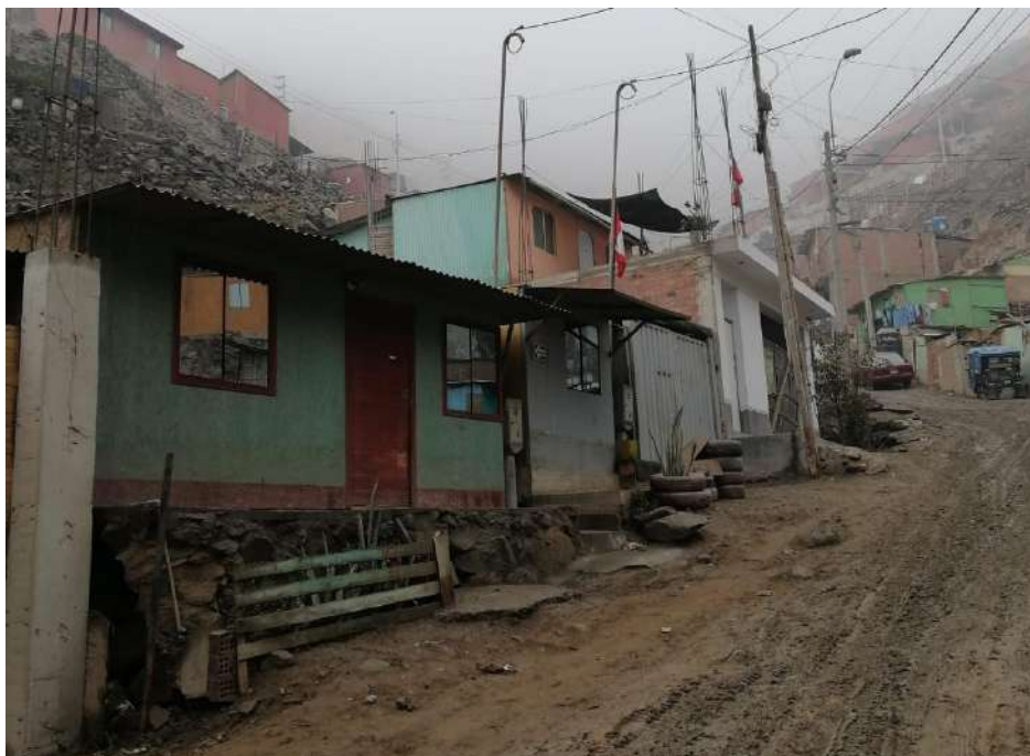
Viviendas construidas con paredes de madera y techo de calamina, así como viviendas de material noble en el AAHH ANDRES AVELINO CACERES-PARCELA 5.
