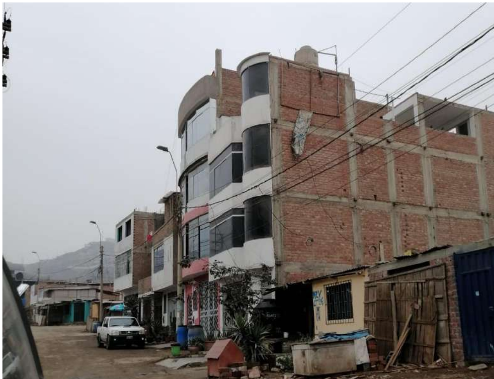
Vivienda de cuatro niveles en el AAHH RAMIRO PRIALÉ II.
