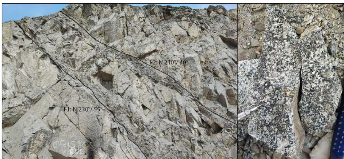
Figura 16. Izquierda; Vista de afloramiento con presencia de fallas y diaclasas.
