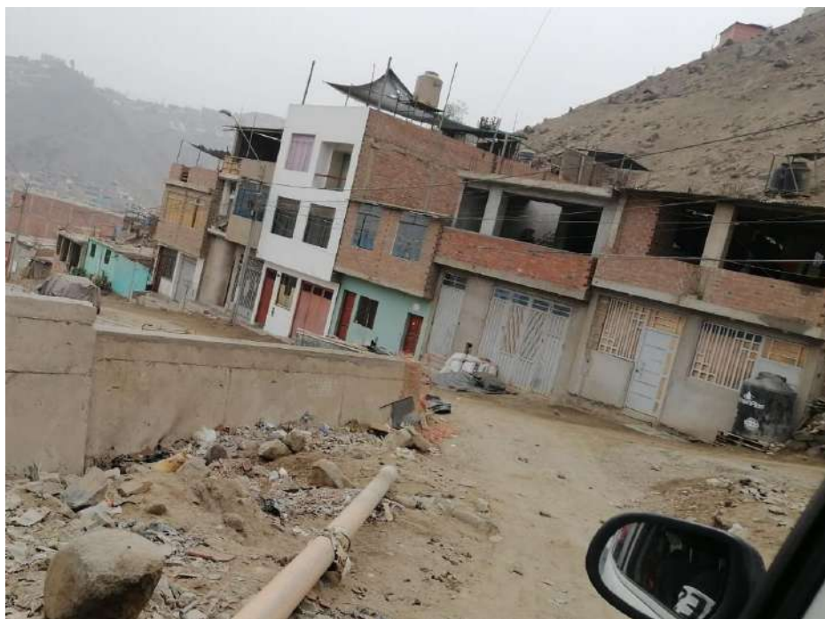
Se observa predominio de viviendas dos niveles a más en el AAHH RAMIRO PRIALÉ II.
