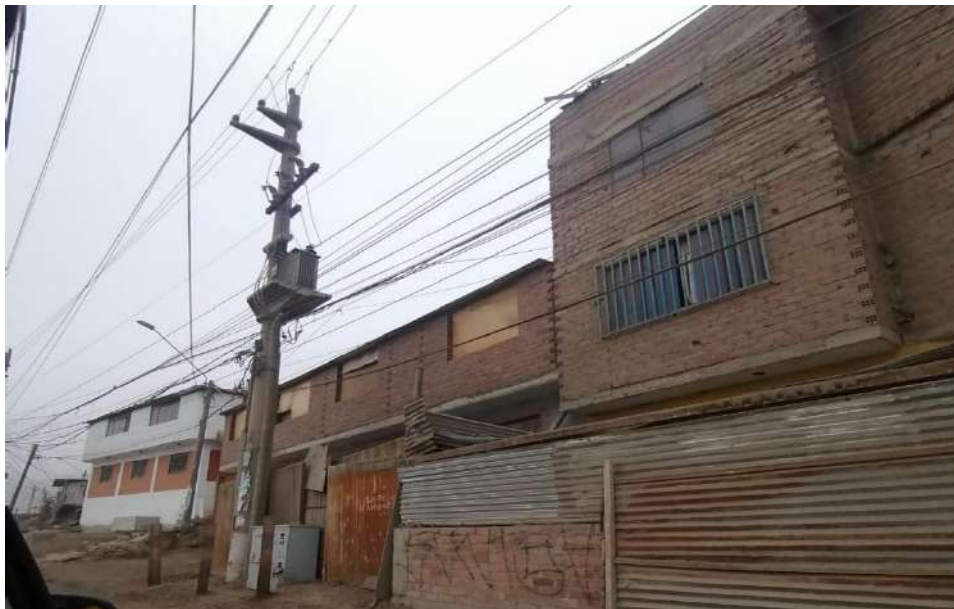
Vista panorámica del AAHH Viviendas con paredes de ladrillo y techos de losa y calamina en el AAHH ANTONIA ALVAREZ.
