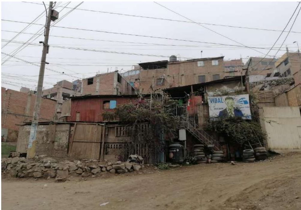
Viviendas con paredes de ladrillo y techos de losa y calamina en el AAHH CIUDAD JARDIN LTDA.
