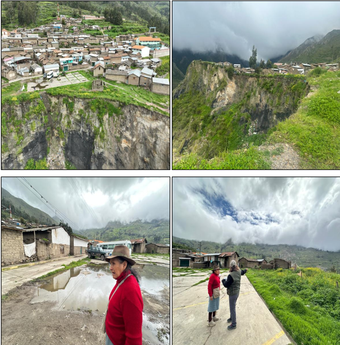
Figura 68. Elementos expuestos, viviendas, loza deportiva y estado de la zona crítica – Zanjón
