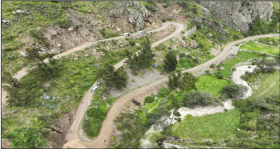
Figura 79. Vista panorámica de la zona crítica – Zinga - Acceso Llamac
