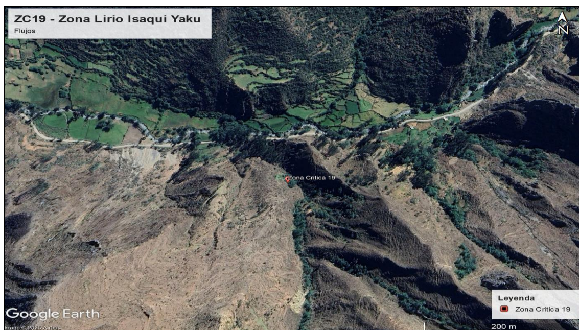
Figura 87. Ubicación de la zona critica Zona Lirio Isaqui Yaku
