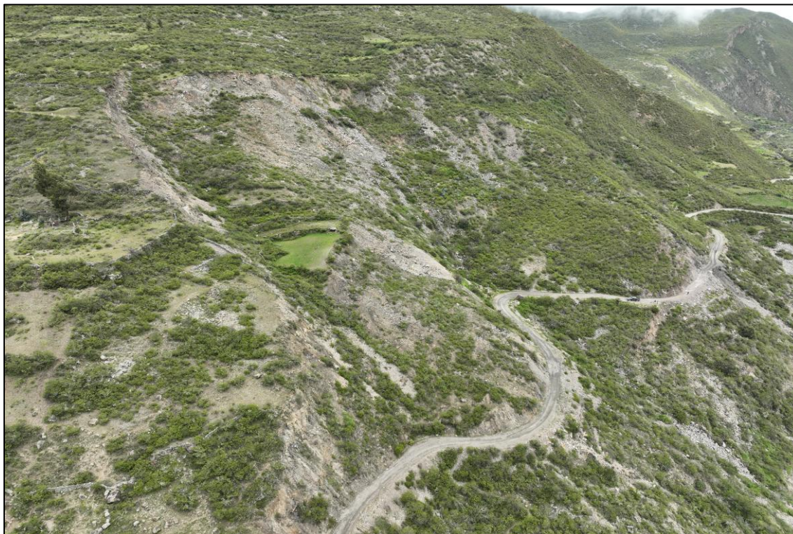
Figura 58. Vista panorámica de la zona crítica – Lamacancha
