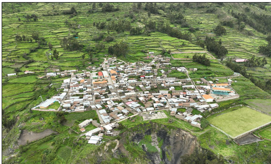
Figura 91. Vista panorámica de la zona critica – Pacllon
