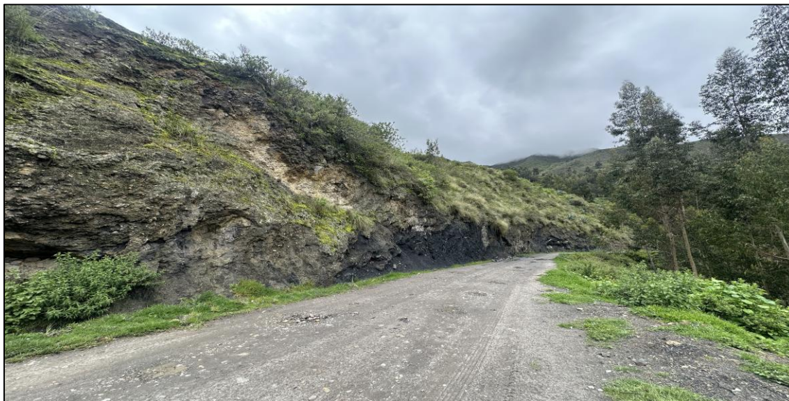
Figura 62. Talud con paquetes de carbón a la base – Cuntun
