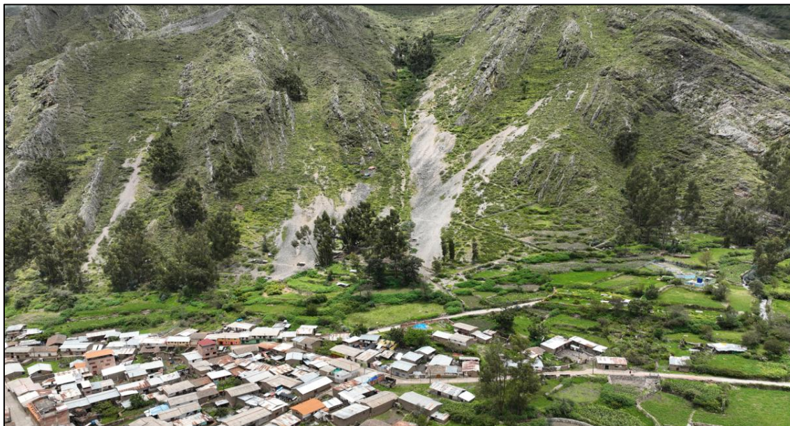
Figura 82. Vista panorámica de la zona crítica – Milwamarca
