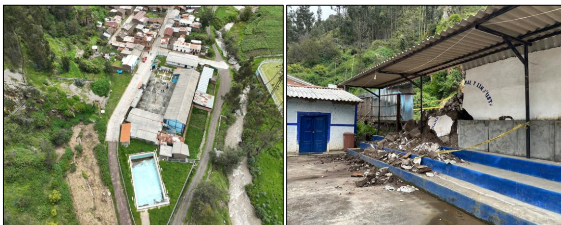
Figura 86. Elementos expuestos de la zona crítica – IE 86239
