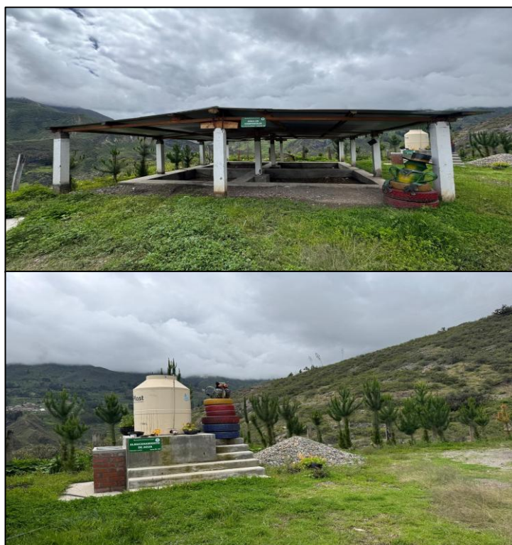
Figura 26. Área de compostaje del botadero de Ahusana
