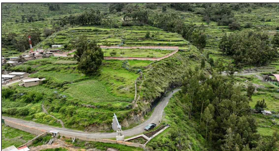
Figura 61. Vista panorámica de la zona crítica – Cuntun
