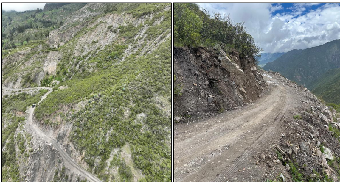
Figura 59. Deslizamiento rotacional – Lamacancha
