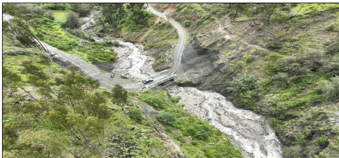
Figura 49. Vista panorámica de la zona critica – Puente Tacra Racra
