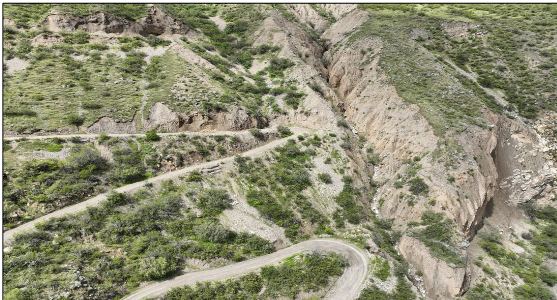
Figura 73. Vista panorámica de la zona crítica – Curva Colpa
