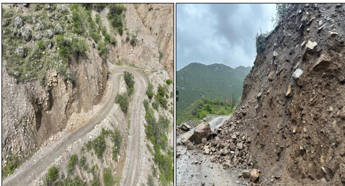
Figura 74. Elementos expuestos de la zona crítica – Curva Colpa
