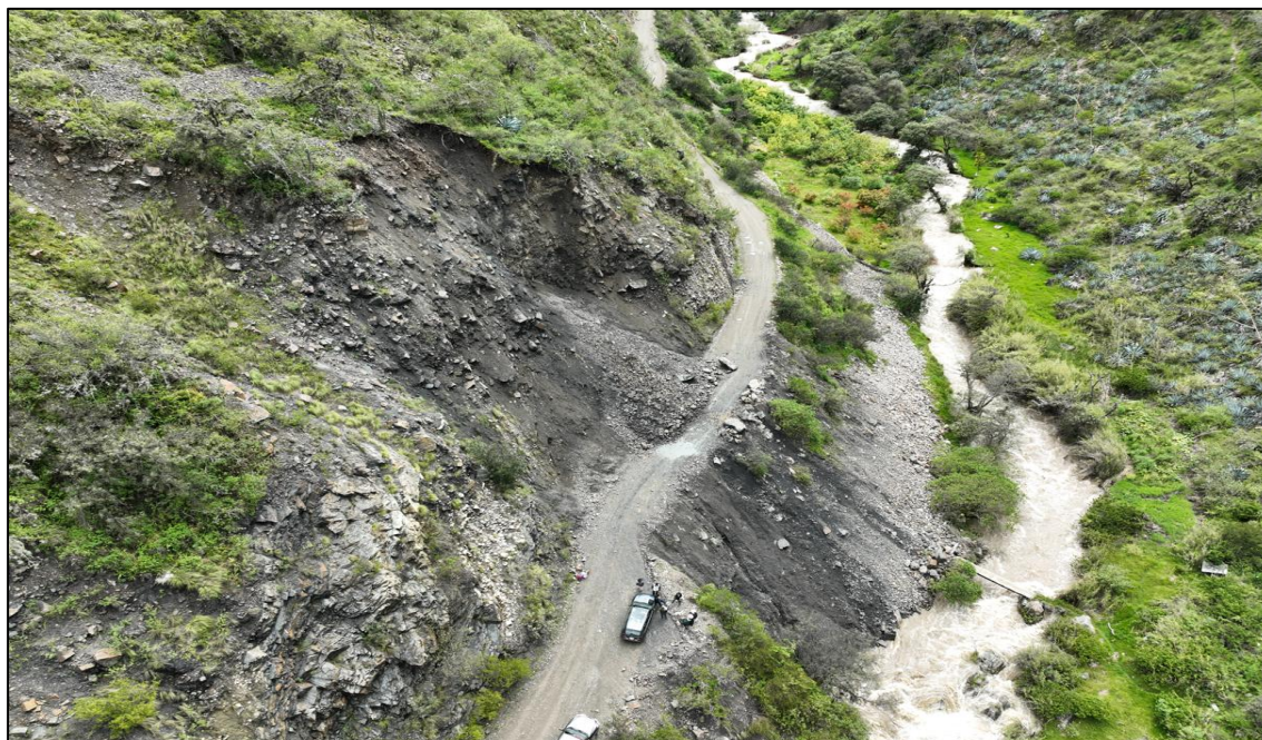
Figura 76. Vista panorámica de la zona critica – Balcón de mono
