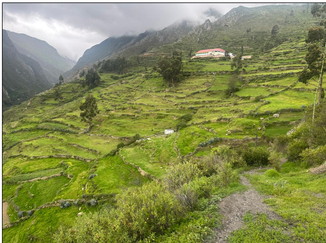
Figura 70. Vista panorámica de la zona critica – PTAR Puya
