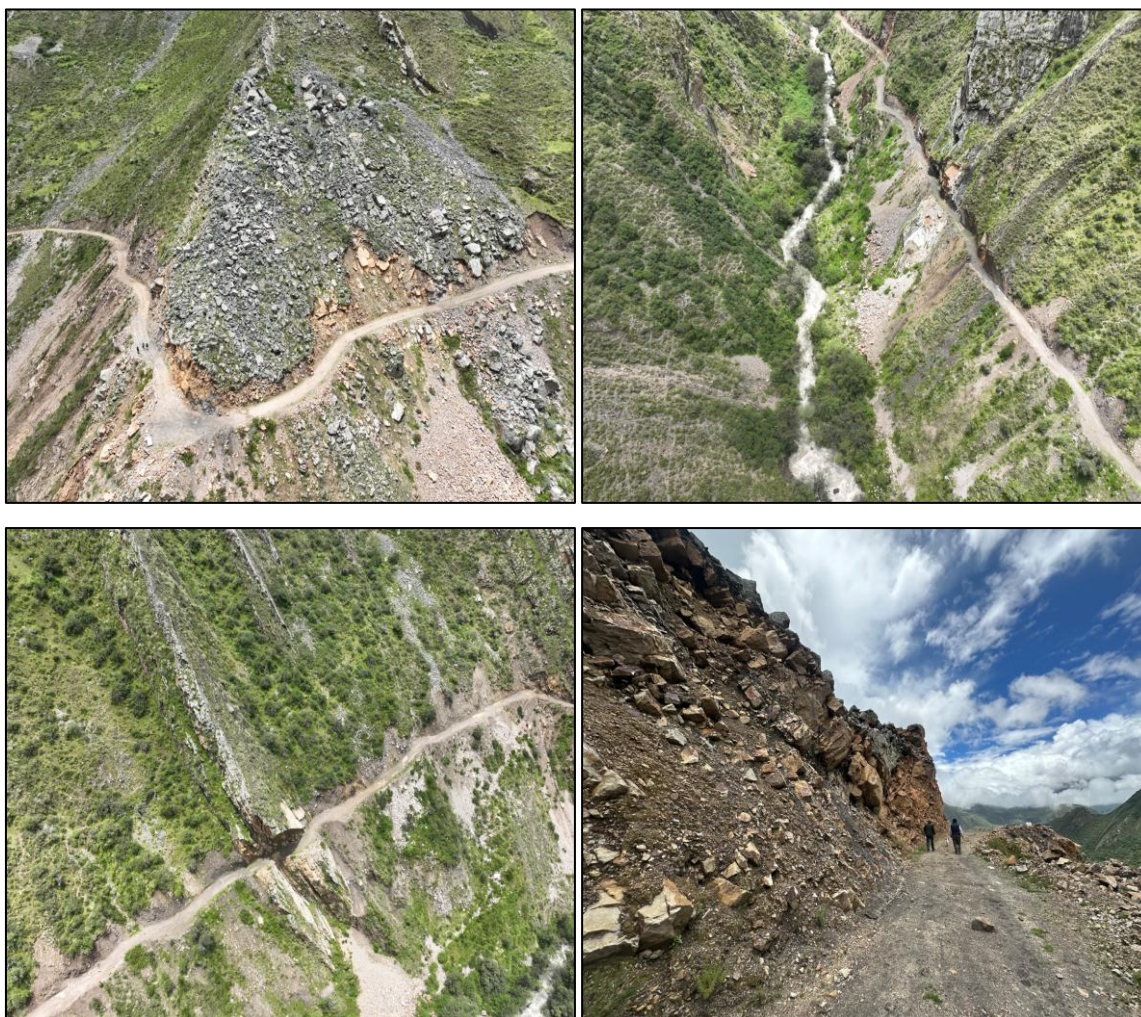
Figura 65. Tramos de la zona crítica – Agoy - San Jose - Tsacapampa – Wauyan
