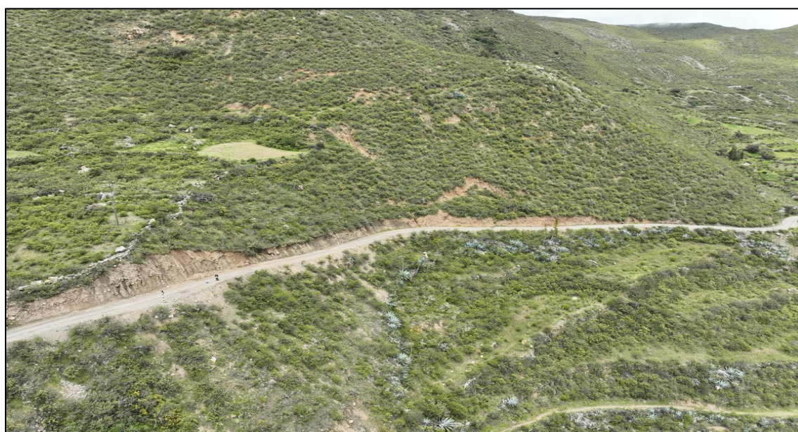
Figura 55. Vista panorámica de la zona crítica – Ahusana
