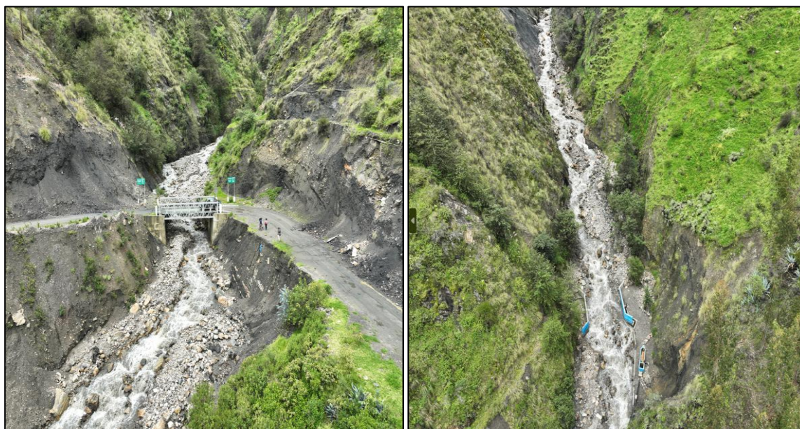
Figura 50. Elementos expuestos de la zona crítica – Puente Tacra Racra
