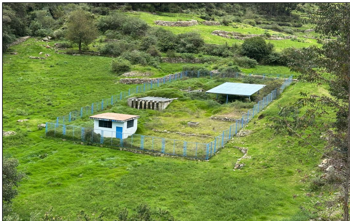
Figura 97. Vista panorámica de la zona crítica – PTAR Tablagaga
