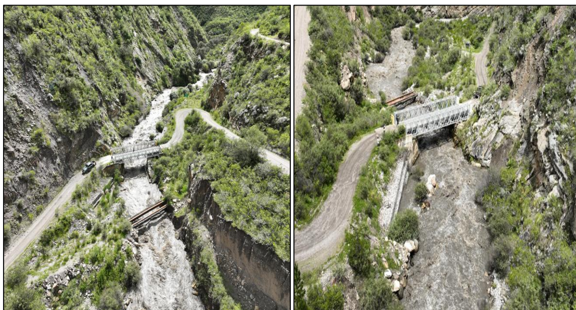
Figura 53. Elementos expuestos de la zona crítica – Puente Colpa
