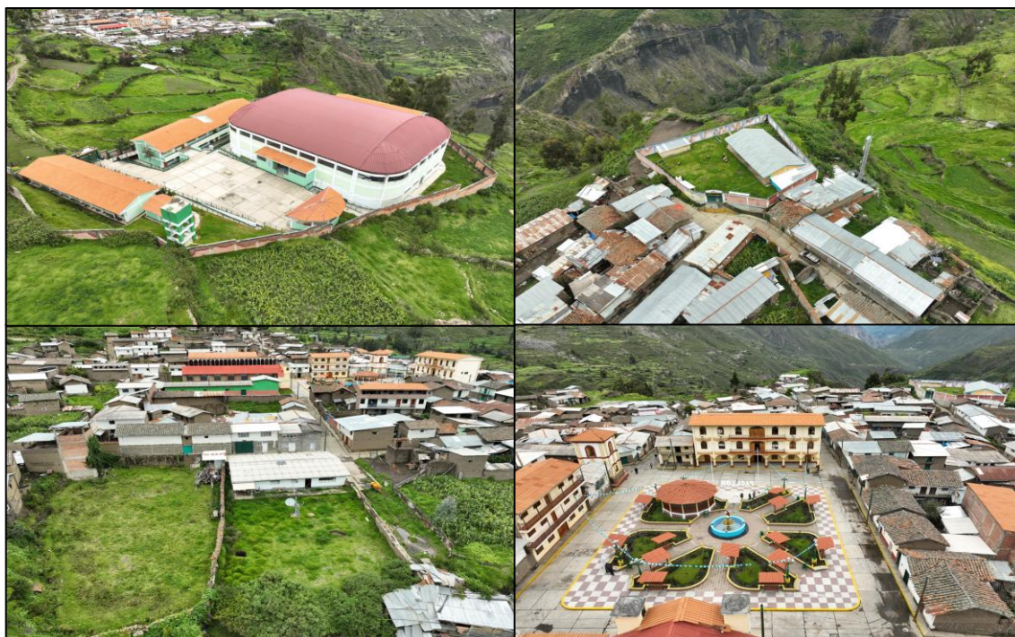
Figura 92. Elementos expuestos de la zona crítica – Pacllon
