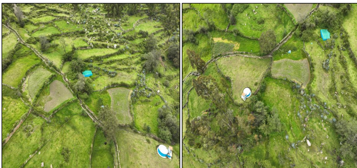
Figura 95. Elementos expuestos de la zona crítica – Captación - Reservorio Huampush
