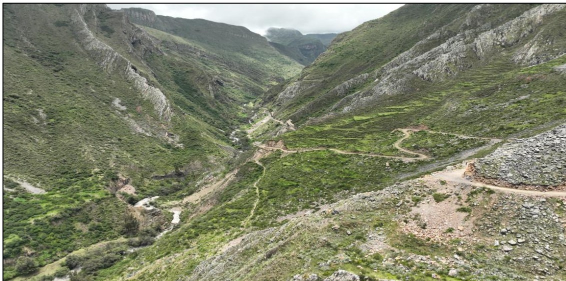
Figura 64. Vista panorámica de la zona crítica – Agoy - San Jose - Tsacapampa – Wauyan
