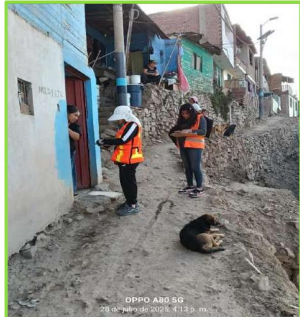
Ausencia de muro de contención en las viviendas de material precario, también se aprecia la altura de las pircas que van más de 1 metro de altura. Lo cual muestra un alto riesgo de deslizamiento e inestabilidad del terreno, con viviendas directamente expuestas al colapso del talud. Hay ausencia de infraestructura de mitigación y un entorno urbano informal que no cuenta con medidas de gestión del riesgo de desastres (GRD) adecuadas.
