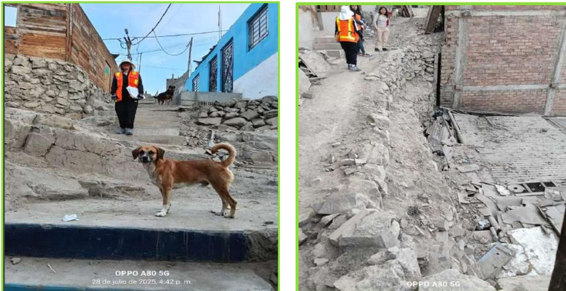
La imagen muestra un alto riesgo por deslizamiento y vulnerabilidad estructural, tanto para los transeúntes como para la vivienda contigua. La zona requiere intervenciones urgentes de estabilización del talud, instalación de un muro de contención, y mejoras en la infraestructura peatonal (escaleras seguras, barandas y drenaje).
