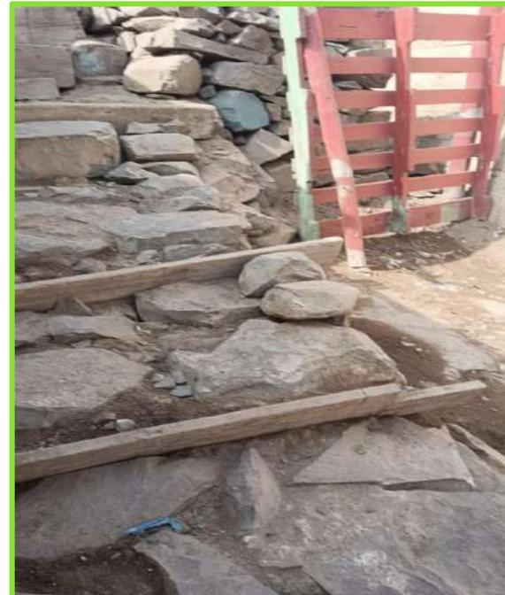
La imagen muestra una situación de alto riesgo físico y estructural. La vivienda se encuentra sobre un muro de contención precario que no ofrece garantías de seguridad. En caso de sismo o lluvias intensas, hay riesgo inminente de colapso del muro y pérdida de la vivienda. Esto representa además un peligro para personas que circulen por la parte baja.
