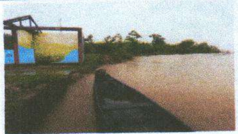
Vista de la zona erosionada en la ribera de la localidad de San Martin
