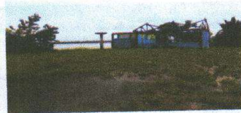
Vista del centro educativo en riesgo, el cual ya fue desarmado y abandonado
