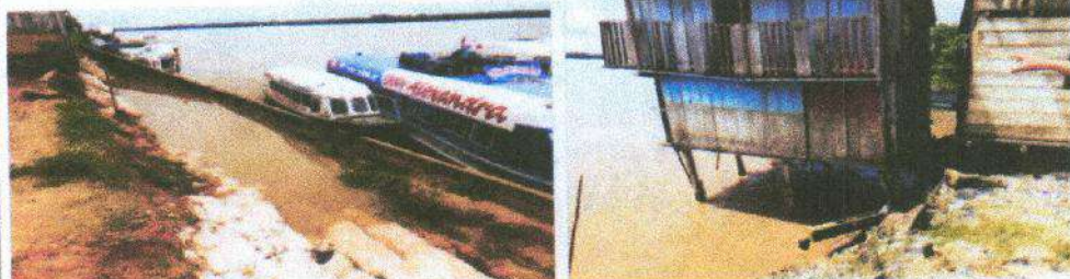
VI.- PANEL FOTOGRÁFICO DE ZONA VULNERABLE
