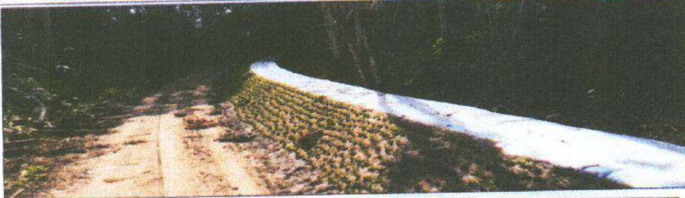
Vistas de la estructura final de la Defensa ribereña a modo de muro de contención frente a inundaciones
