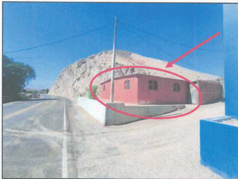
Fotografía 2. Trabajo de campo vivienda de material de madera estado de conservación regular
