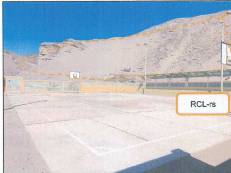
Figura 19. Identificación de la Colina y lomada en roca sedimentaria (RCL-rs) en el proyecto
