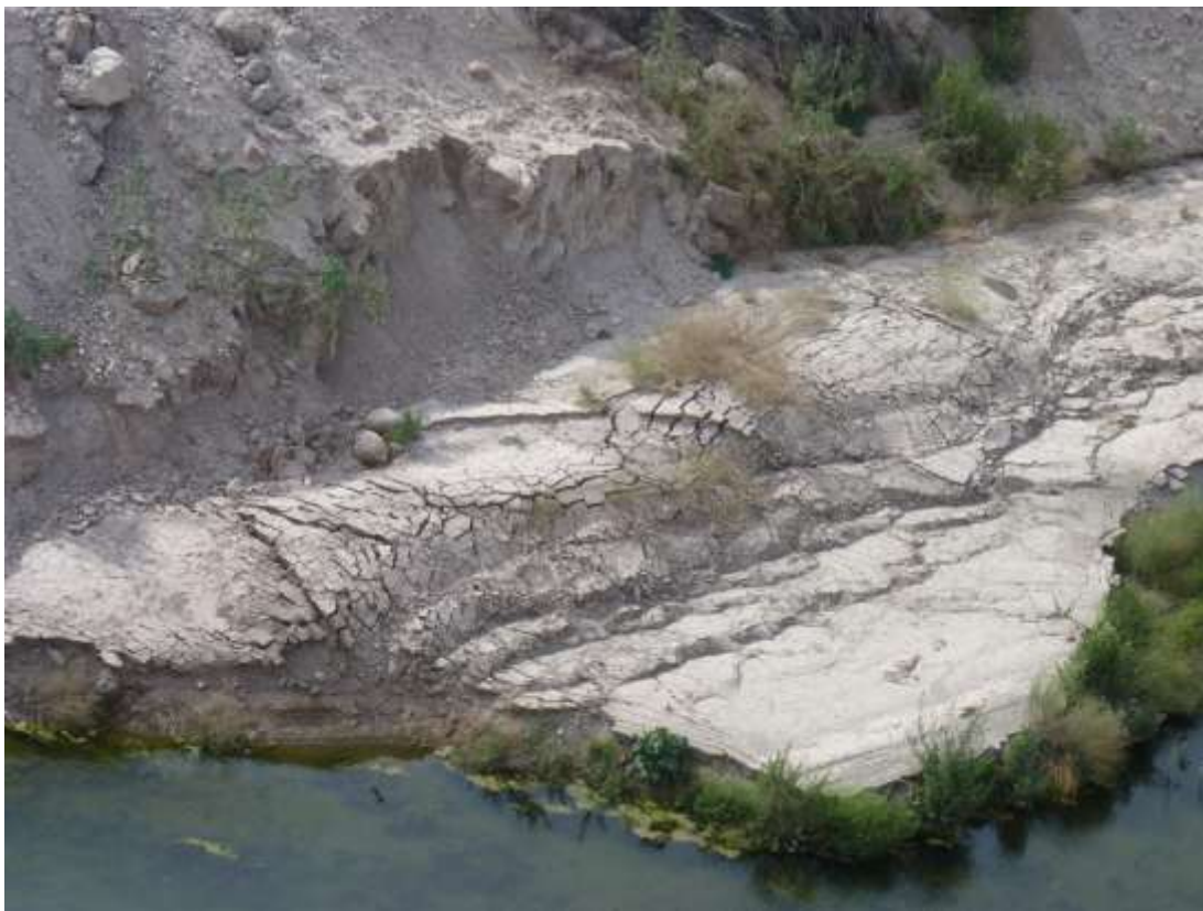
Foto 6: Terraza Fluvial altamente agrietada y destruida.
