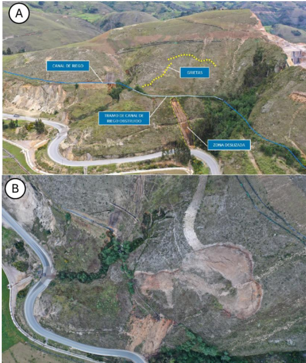
Figura 13. A se observa el avance del deslizamiento a inicios del año 2024 (Fuente: La Arena S.A), (B) se muestra su progresión en el año 2025, evidenciándose una diferencia significativa en su extensión y desarrollo.
