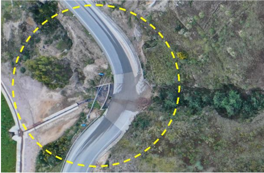
Figura 18. Se observa encerrado en el círculo amarillo una obra de arte de infraestructura vial, así como el material transportado por la quebrada.
