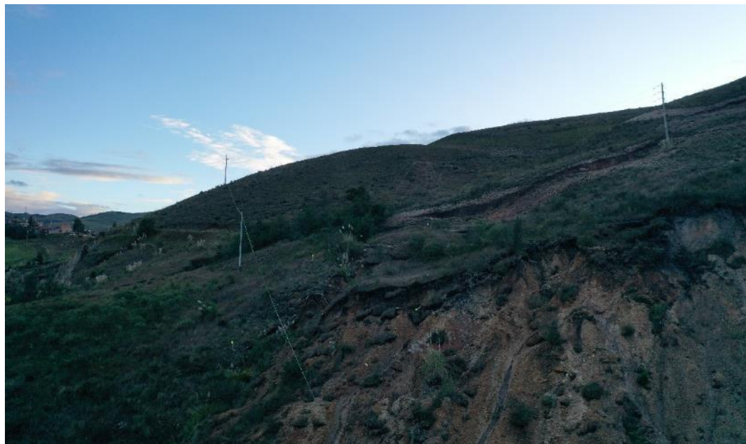
Figura 16. Se observa que el deslizamiento pone en peligro la fibra del operador Claro (internet Huamachuco – Pataz).
