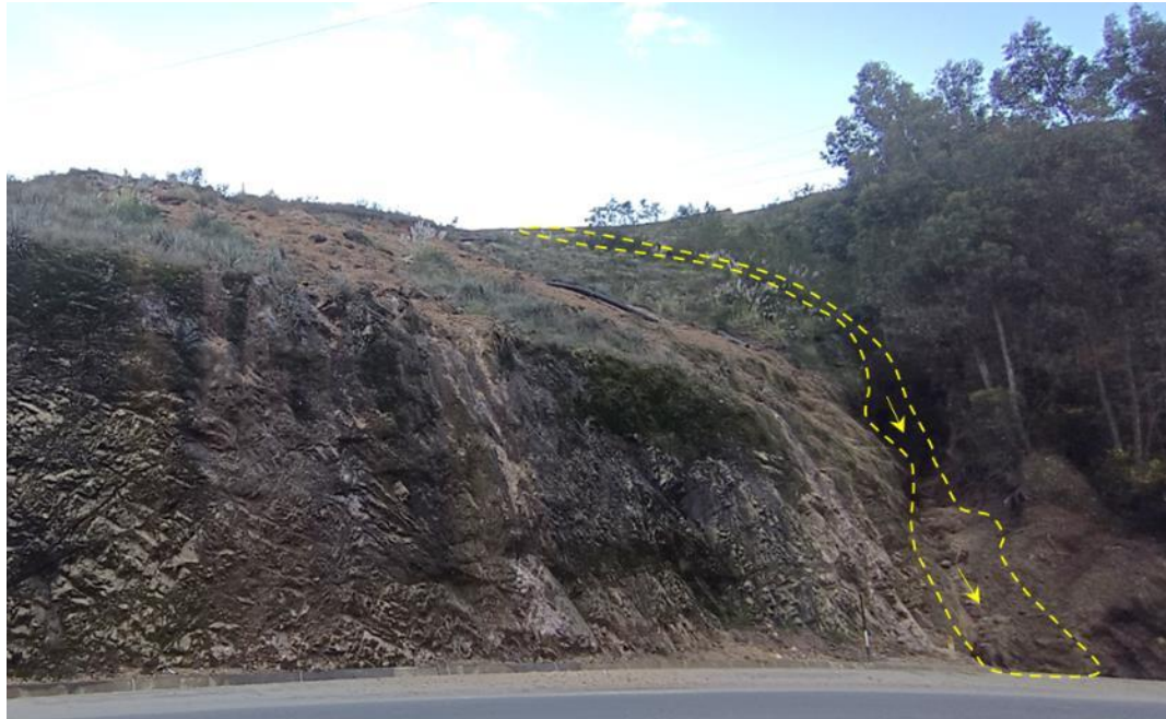
Figura 6. Depósito proluvial (líneas amarillas), está confinado al cauce de una quebrada. Ubicación: E: 816082, N: 9125358.
