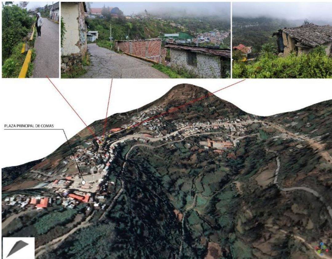
Figura 12: Ubicación de agrietamientos y evidencias de inestabilidad en la ladera de estudio.
