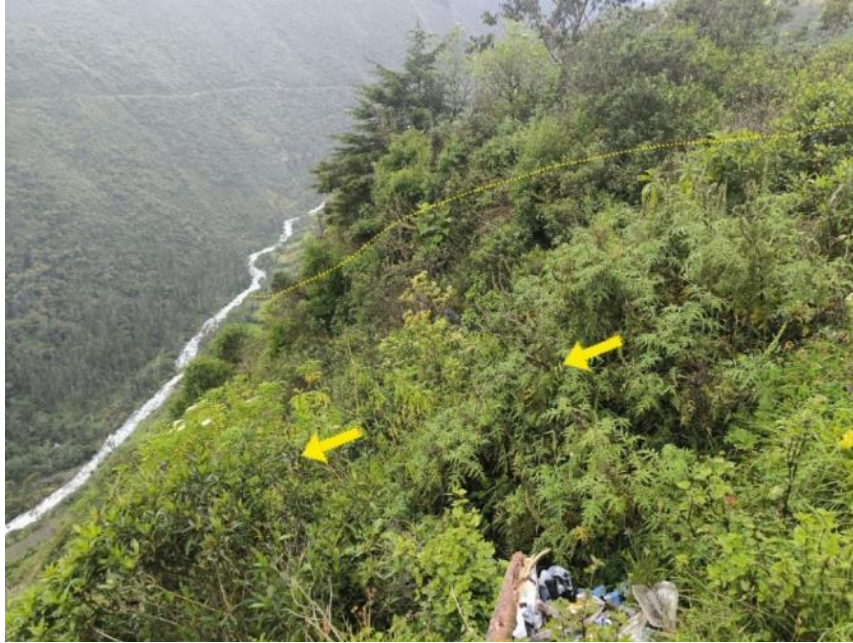
Figura 8: ladera media- baja del derrumbe inactivo latente (D-il1), cubierto por vegetación.
