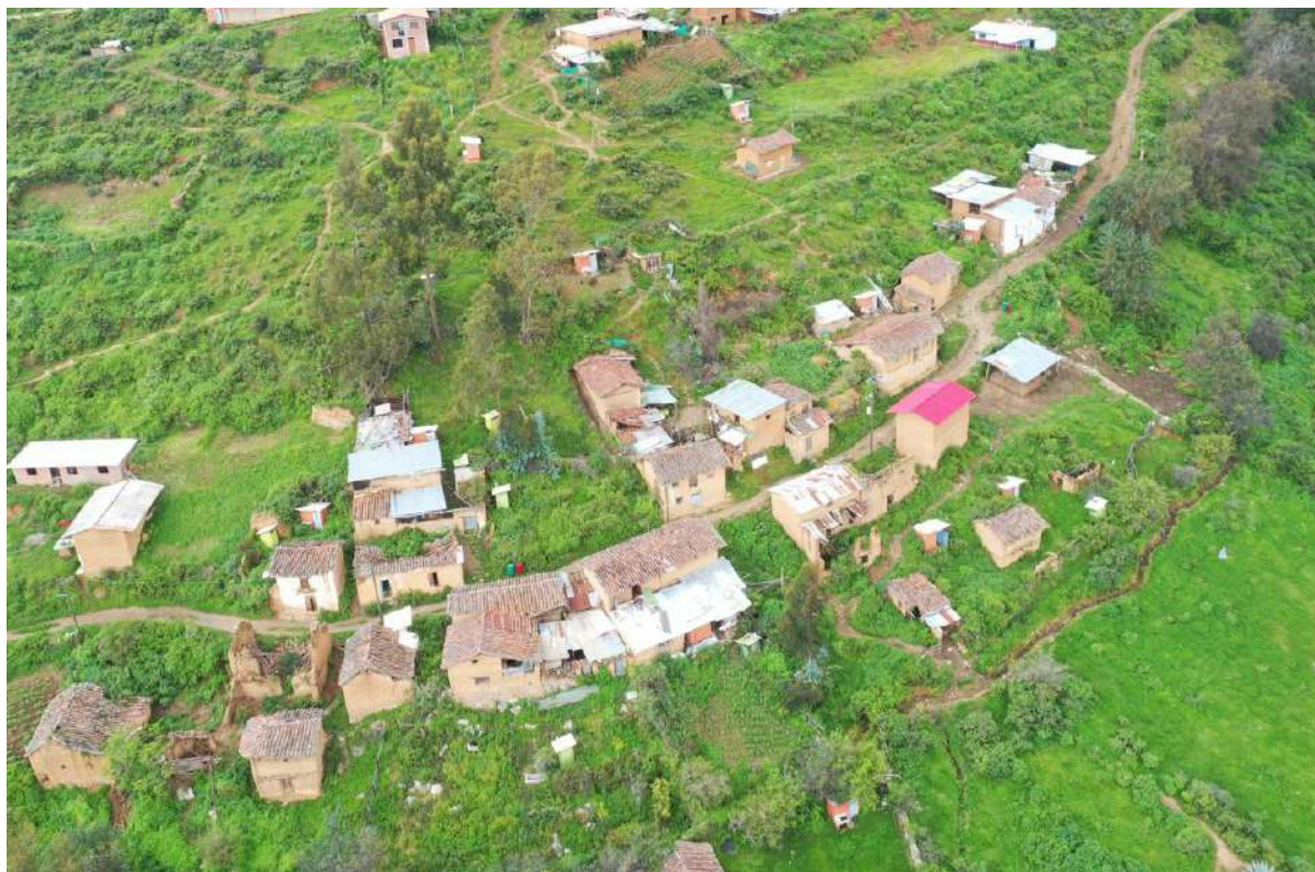
Fotografía 10. Vista de canales de riego no impermeabilizados que coadyuban a la infiltración de las aguas en el suelo sobresaturando la zona.
