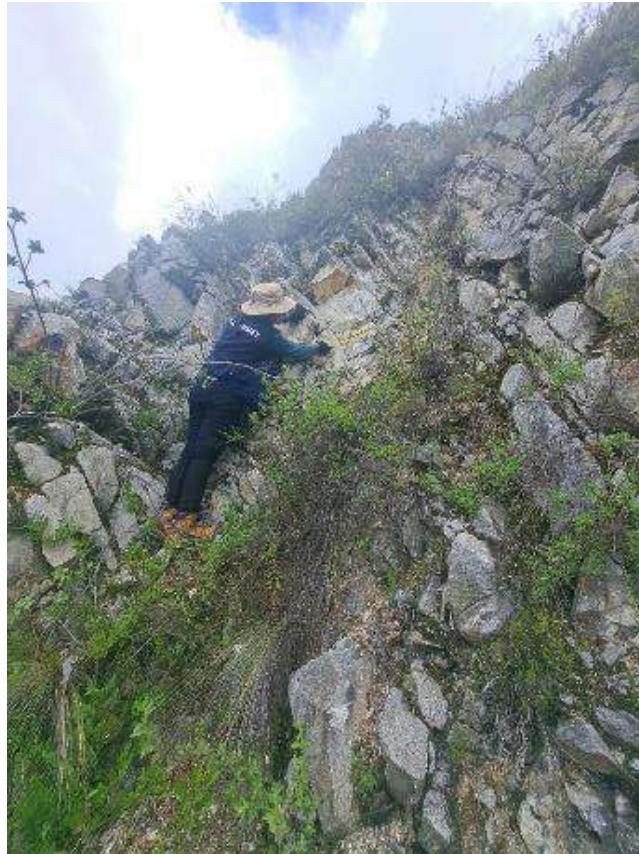
Fotografía 5. Vista del afloramiento rocoso fuertemente fracturado en las fracturas abiertas presenta relleno orgánico, que dejan bloques separados del sustrato rocoso, las discontinuidades son ligeramente rugosas, no presenta agua, la estructura evidencia desprendimientos de rocas por cuña y planar, presentando un grado de fracturación de fracturado a muy fracturado (con espaciamentos de fracturas de 0.06 – 0.60 m).
