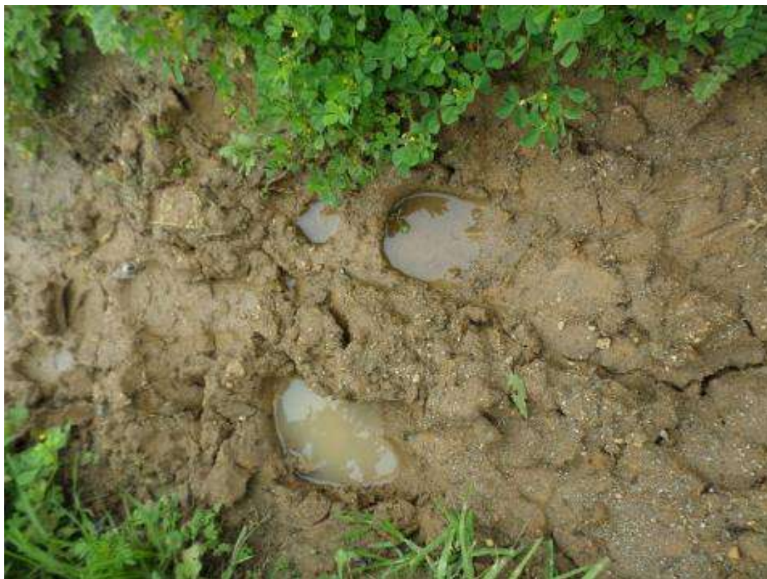
Fotografía 6. Vista de suelo arcilloso, el cual se encuentra saturado por la poca capacidad de transmisibilidad tiende a retener el agua incrementando la presión de poros.
