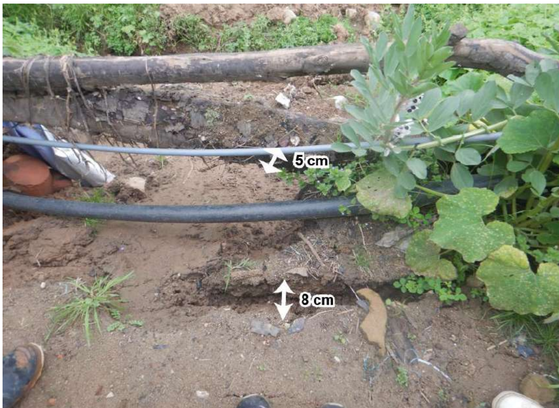
Figura 17. Vista de grietas en el suelo con 5 cm y 8 cm de aberturas y 1 a 3 m de longitud.
