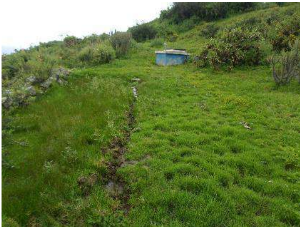
Fotografía 9. Vista de un buzón rompe presión ubicado ladera arriba del anexo Huanchay, donde se evidencia un bofedal formado por las aguas que derivan de este, el cual se encuentra saturando los suelos ladera abajo.
