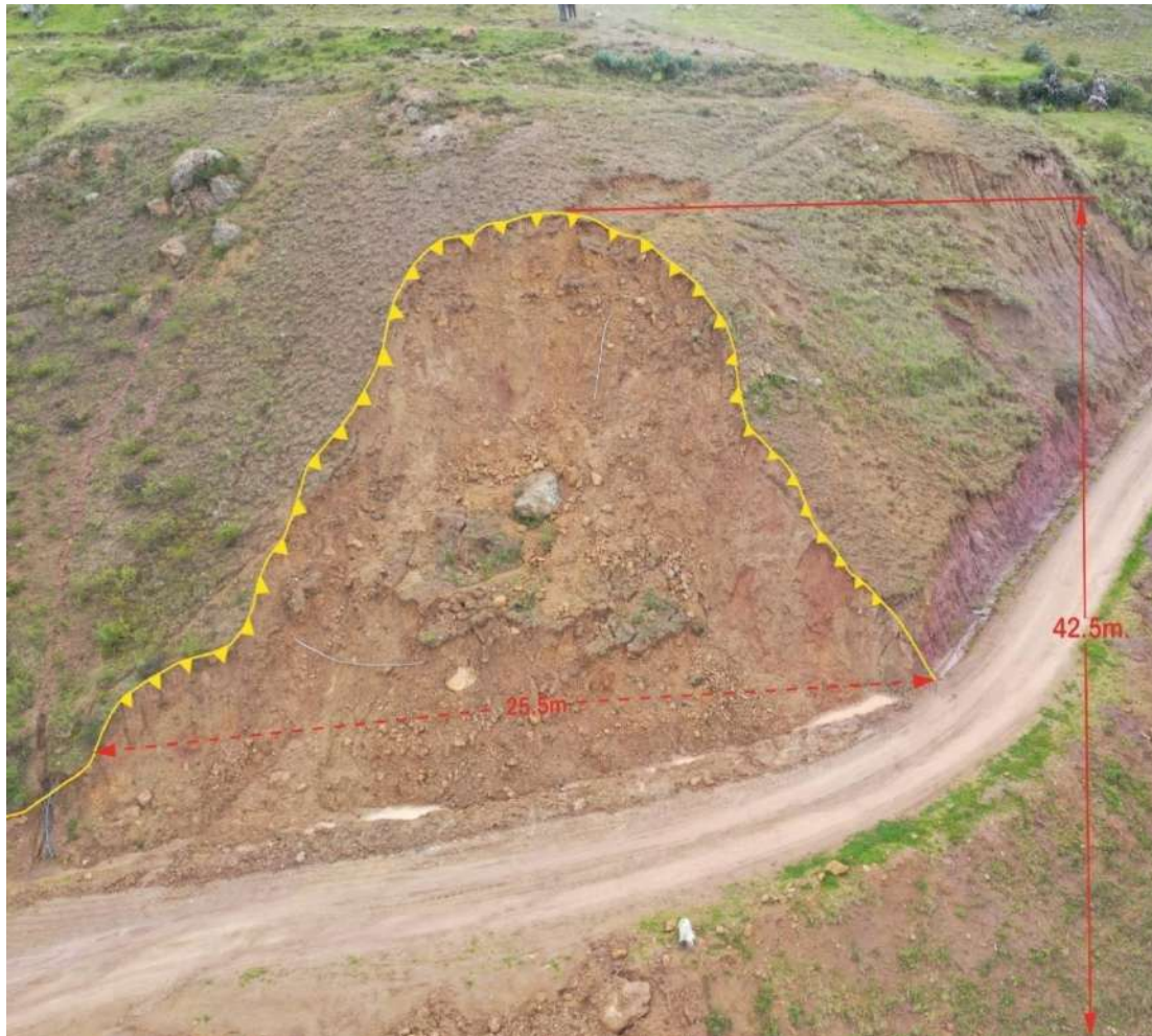
Figura 13. Vista del deslizamiento rotacional, donde se evidencia la escarpa principal tiene 26 m de longitud, dentro del cuerpo del deslizamiento se identificó la presencia de una tubería de agua, grietas próximo a la escarpa, indicando que este deslizamiento es retrogresivo
