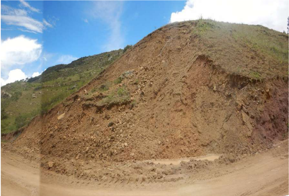
Fotografía 3. Vista del deslizamiento activado en enero del 2025, se observa al pie del evento acumulación de agua, producto de la cuneta obstruida, por el material desplazado.
