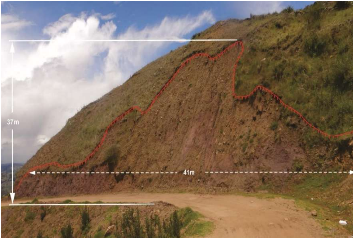
Figura 17. Vista del derrumbe antiguo, ubicado en la margen izquierda del deslizamiento activo, presenta pendiente mayores a 25°.
