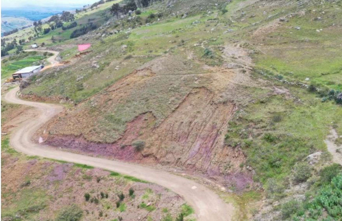
Fotografía 4. Vista con dirección al suroeste se observa un derrumbe a un costado de la trocha carrozable de Santa Cruz - Chilca.
