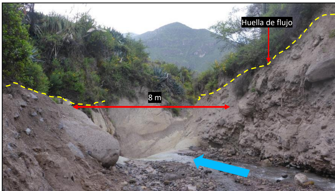
Figura 8. Ensanchamiento del cauce de la quebrada Tacrampa.
