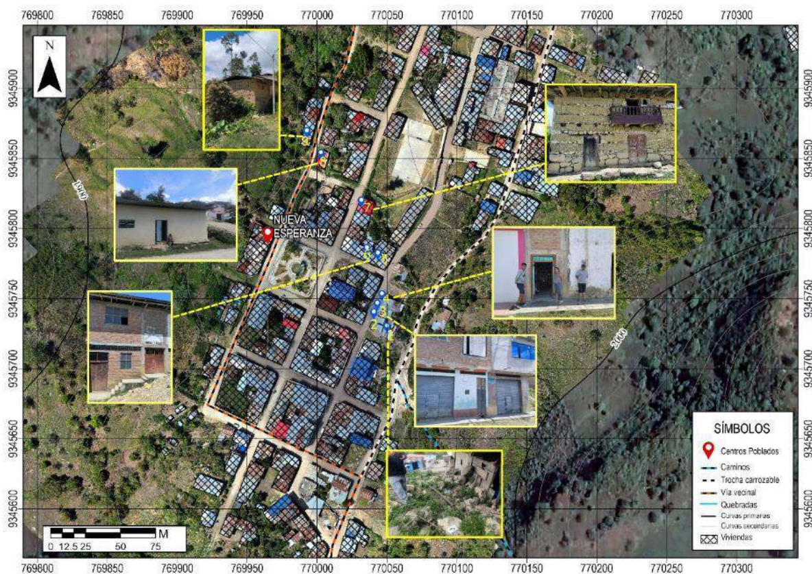
Figura 34. Distribución de las viviendas afectadas en el C.P. Nueva Esperanza.
