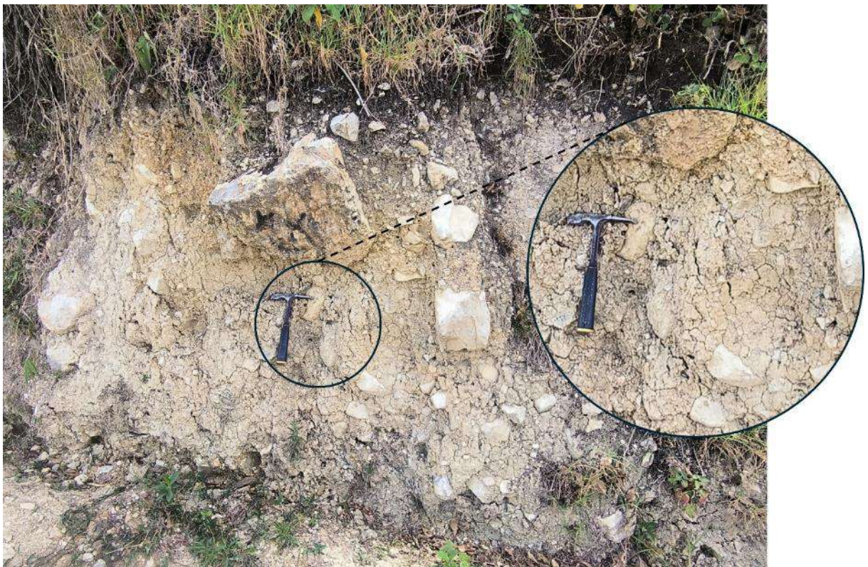
Figura 8. Vista del depósito coluviodeluvial conformado por clastos subredondeados a subangulosos heterométricos con tamaños que van de 0.2- 50 cm. envueltos en una matriz arcillo-limosa, el depósito se muestra húmedo. Coordenadas UTM 18S 2047571E; 8982217N.
