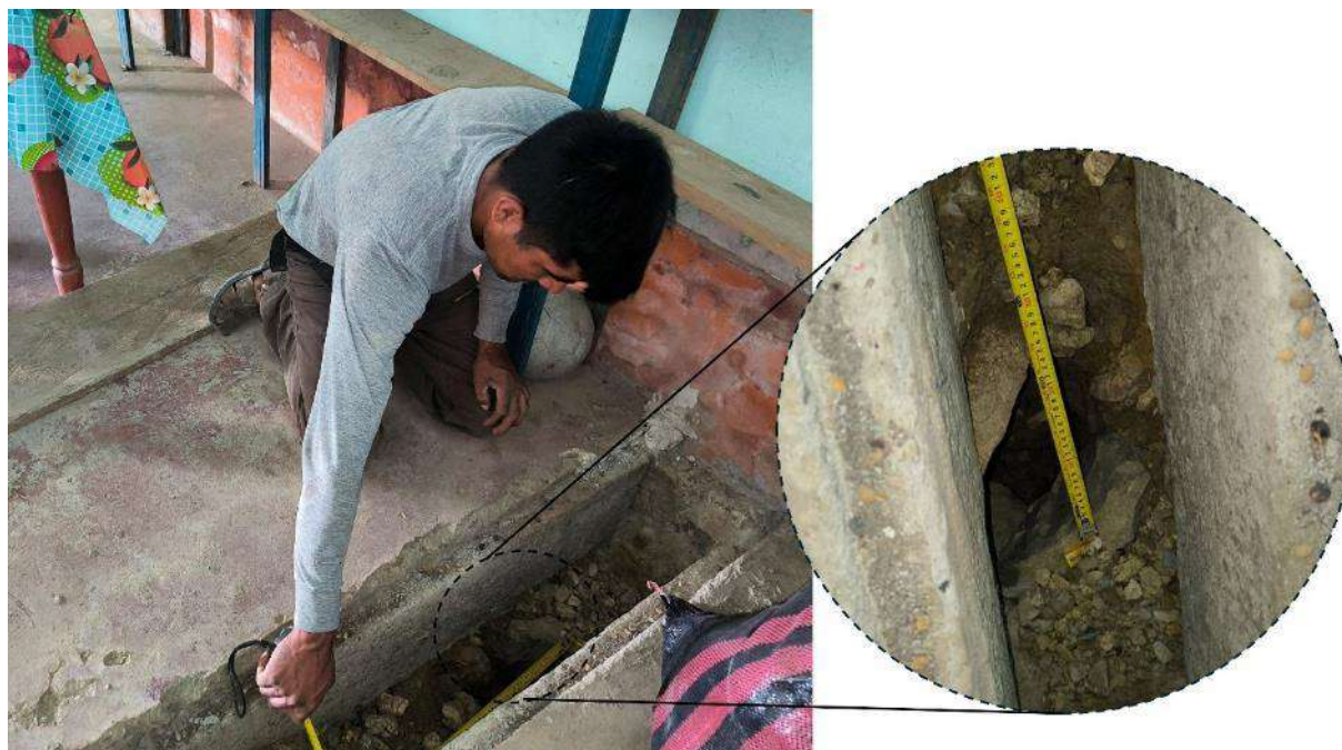
Figura 31. Vista del piso de vivienda, se observa desnivel por hundimiento. Coordenadas referenciales UTM WGS-84, 18S: E: 770032; N: 9345729.
