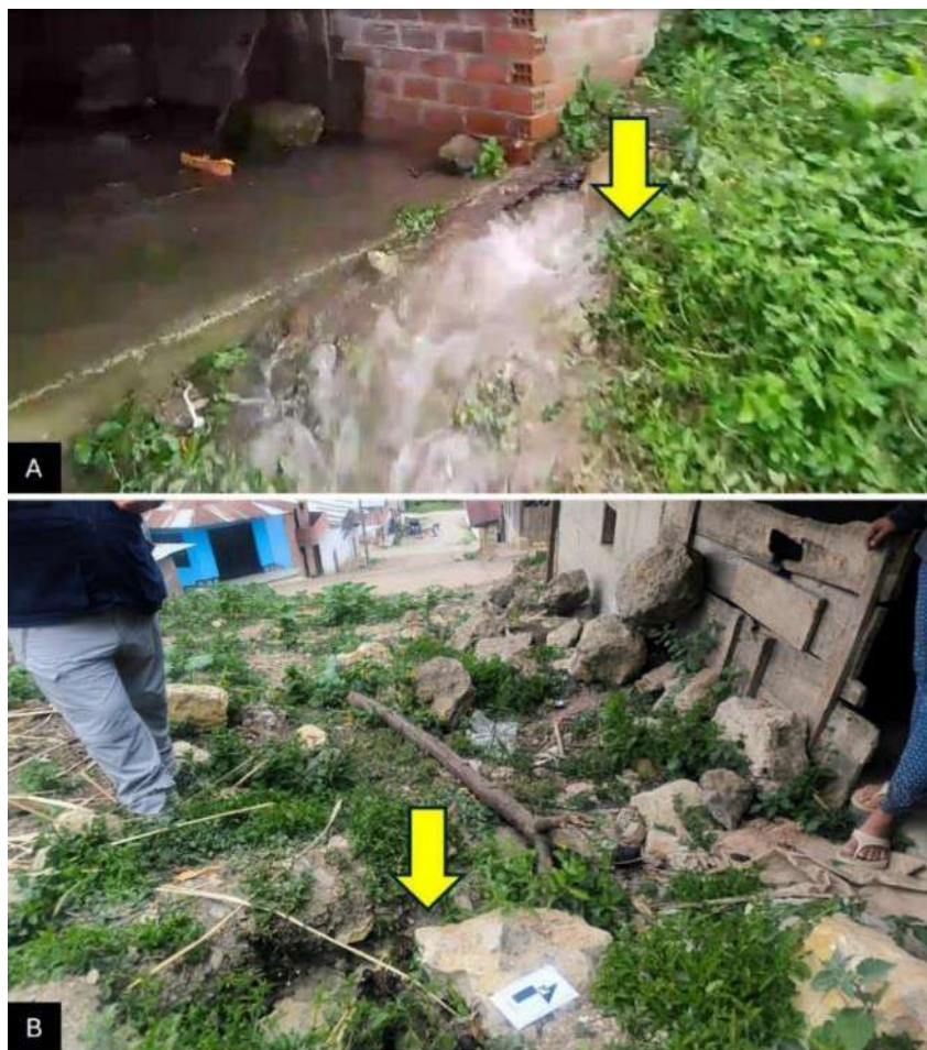
Figura 22. Vista del mismo punto y flujo de agua. A. Durante las lluvias de abril-mayo del 2024. B. Imagen tomada en noviembre, 2024.
