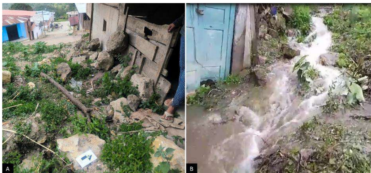
Figura 23. Vista del discurrimento de agua por un canal natural, la acumulación de agua se centra en ciertas áreas y principalmente viviendas debido a las zonas de pendiente baja. A. Vista ladera abajo por donde fluye el agua. B. fotografía tomada por pobladores, mayo, 2024.
