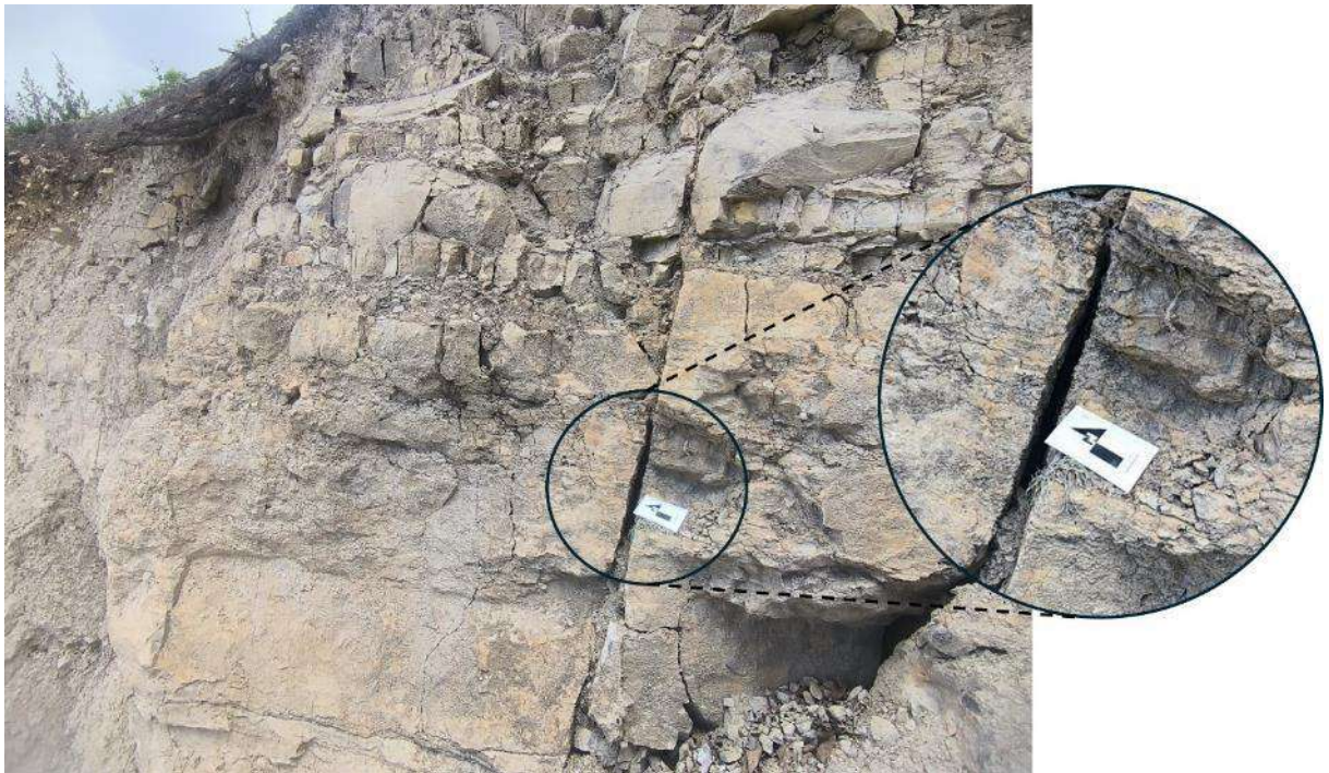
Figura 7. Vista de calizas en estratos decrecientes 50 a 20 cm, grises, intercalado con limoarcillitas de 5-8 cm, fracturadas y moderadamente meteorizadas, ubicado en las coordenadas UTM 17S: 770058E; 9345682N.
