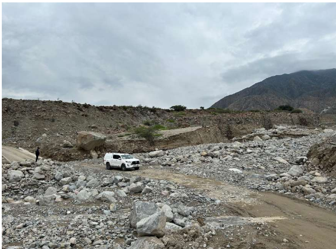
Fotografía 10. Tramo de la carretera departamental Palpa-Ayacucho afectado por flujo de detritos o huaicos en un tramo de hasta 50 m aprox. Coordenadas UTM 506044 E; 8362296 N
