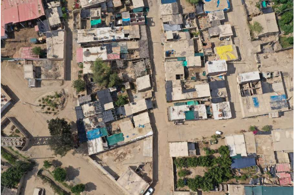
Fotografía 23. Vista tomada con dron del C.P. Los Castillos que podría ser afectado por flujos de detritos (huaicos) provenientes de las quebradas Llancay y Tinajas.
