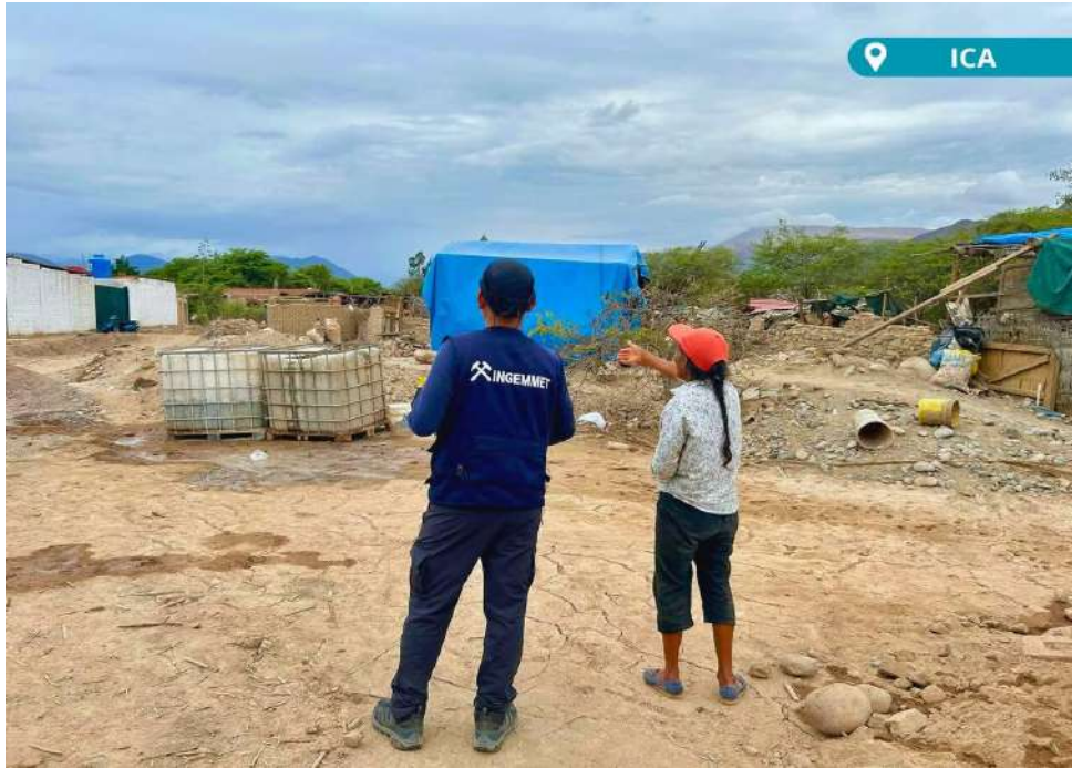
Figura 8. Sector Carmen Pangaraví, viviendas afectadas por flujo de detritos (huaico). Coordenadas UTM 505582 E; 8360125 N.
