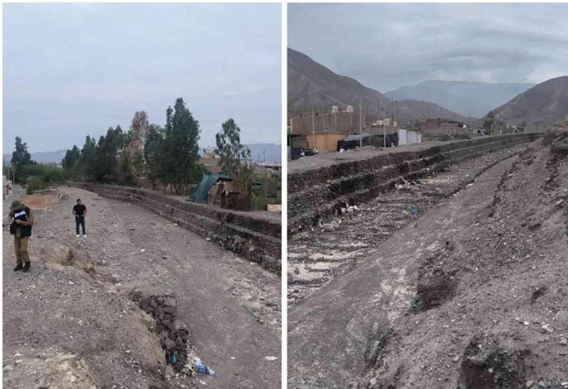
Figura 1. Quebrada Cabeza de cura, se observa viviendas cercanas al cauce de la quebrada (10m a su margen derecha- sector Cajuca 1 y 15m a la margen izquierda- sector Cajuca 2) protegido con gaviones.
