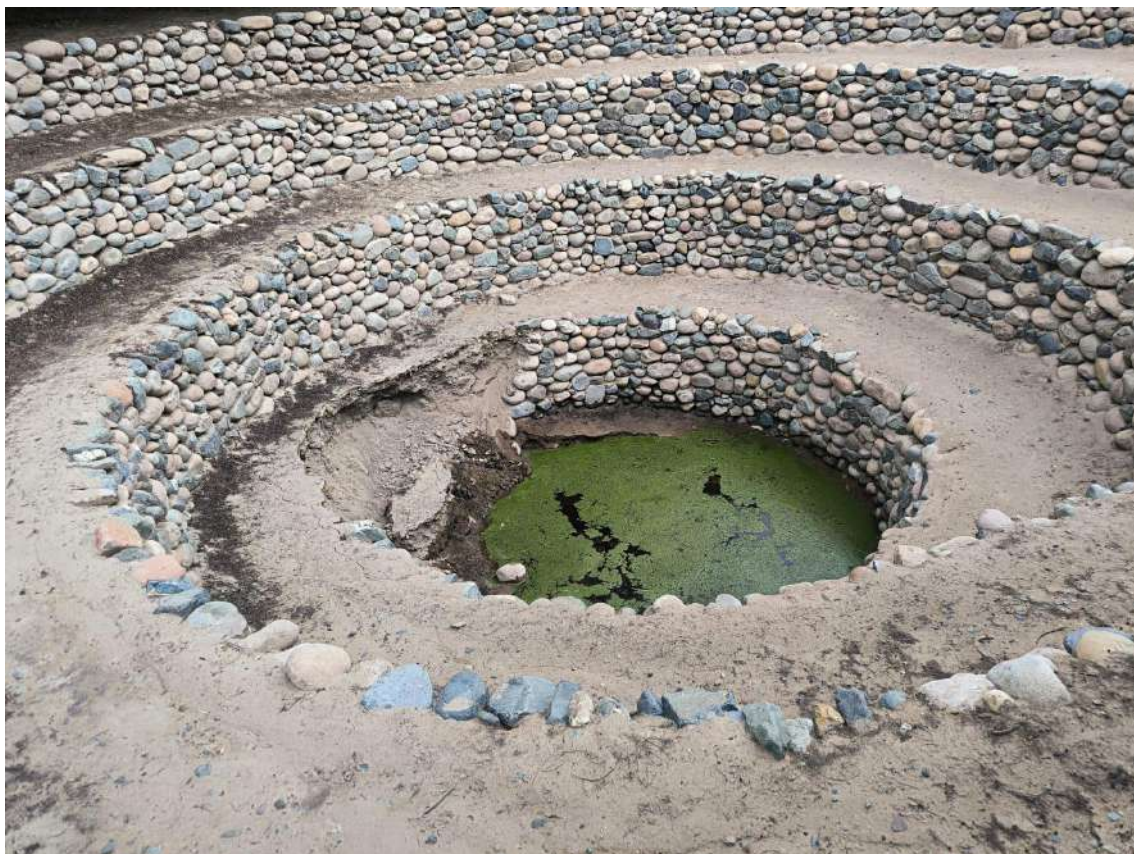
Fotografía 4. Sector Cantalloc. Acueducto afectado por el desborde del río Tierra Blanca. Coordenadas UTM 18S 509617 E; 8360853 N
