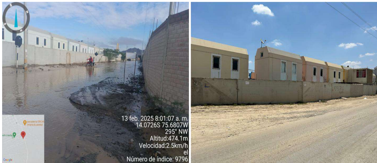
Figura 16. Viviendas afectadas del sector Las Piedras de Buena Vista. Izquierda Imágen tomada por autoridades del distrito. Derecha. Tomada el día de la inspección. Coordenadas UTM 426512 E; 8444127 N.
