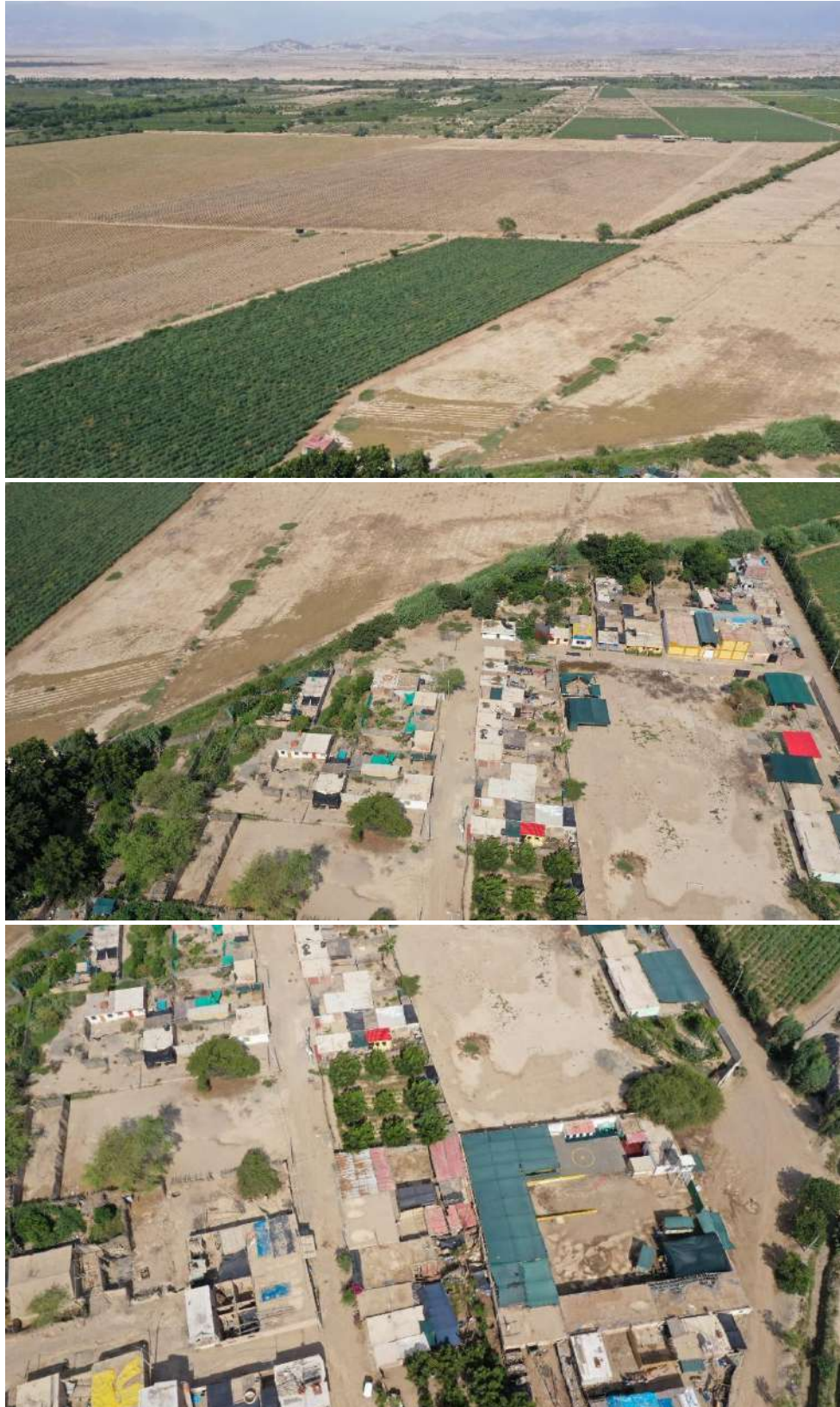
Figura 17. Vista tomada con dron del C.P. Santiago que podría ser afectado por flujos de detritos (huaicos) provenientes de las quebradas Llancay y Tinajas.
