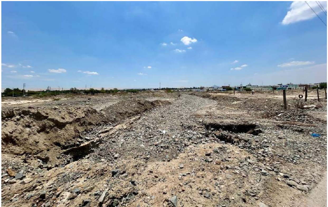
Fotografía 22. Cauce de la quebrada Seca con material generado por flujos de detritos o huaicos, los cuales afectaron vías de acceso, viviendas, postes eléctricos, entre otros. Coordenadas UTM 426703 E; 8444006 N.
