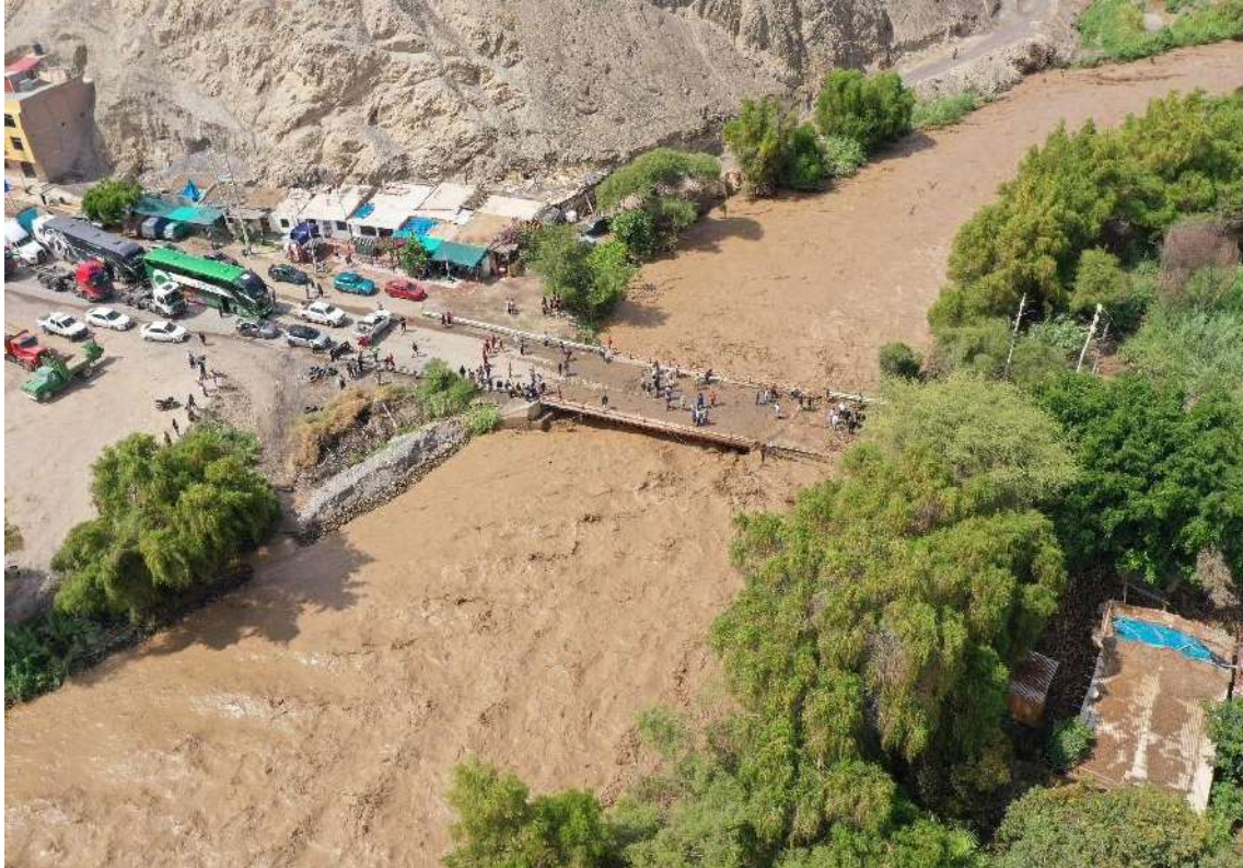
Fotografía 16. Flujo de detritos, vista del puente San José (km 24 carretera Panamericana Sur), distrito El Ingenio. Coordenadas UTM 485038 E; 8376953 N.
