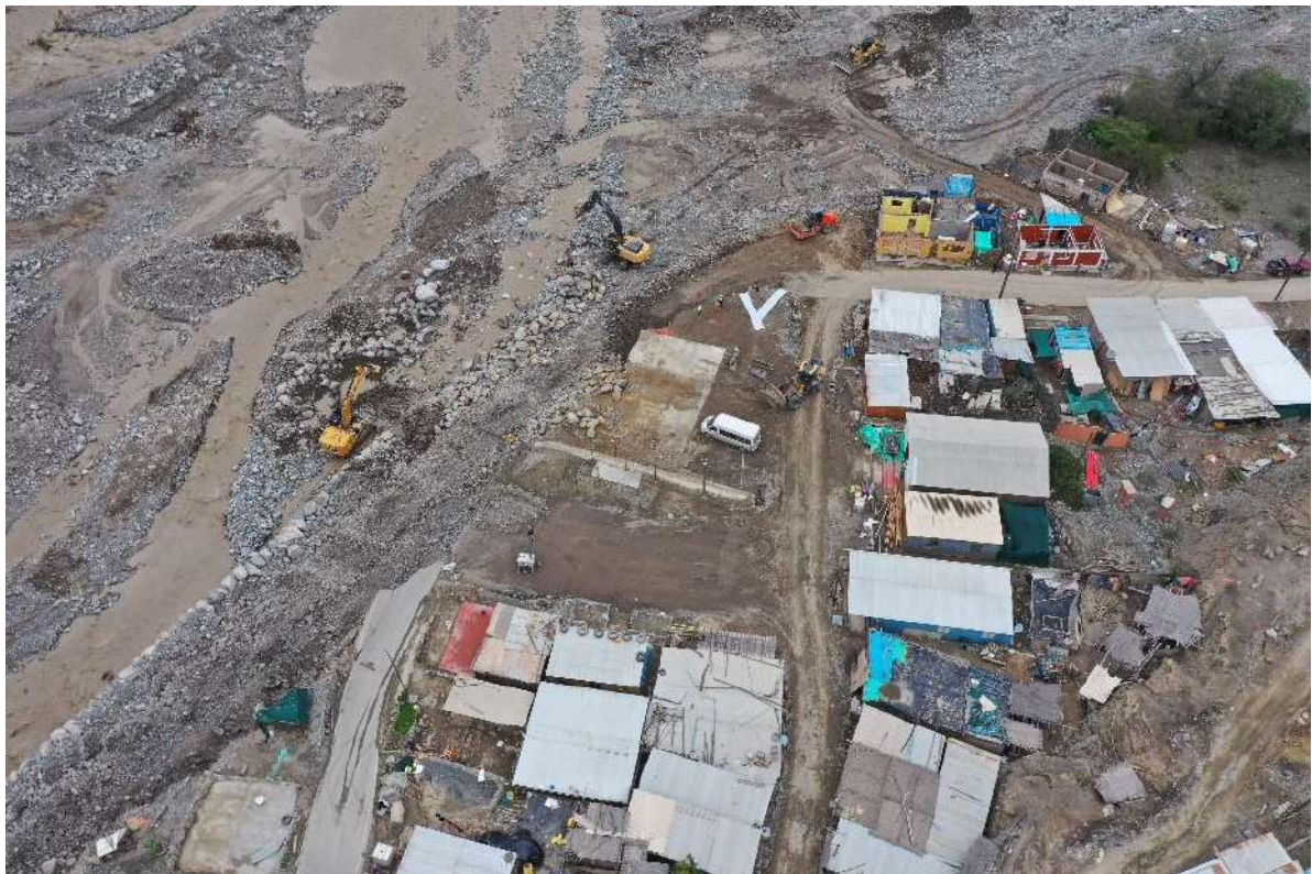
Fotografía 8. Vista tomada con dron del sector Pampa Blanca afectado por flujo de detritos canalizados por río Grande. Los flujos destruyeron un tramo de hasta 100 m de la carretera departamental. Coordenadas UTM 489797 E; 8428239 N.
