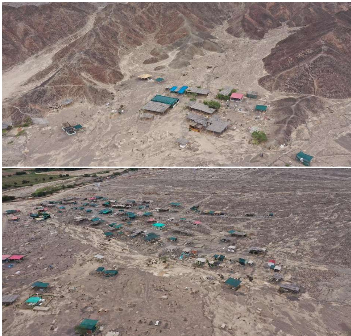
Figura 7. Sector Ajá alto, curso de quebrada que afecta viviendas, terrenos de cultivo y vías de acceso. Coordenadas UTM 506044 E; 8362296 N.
