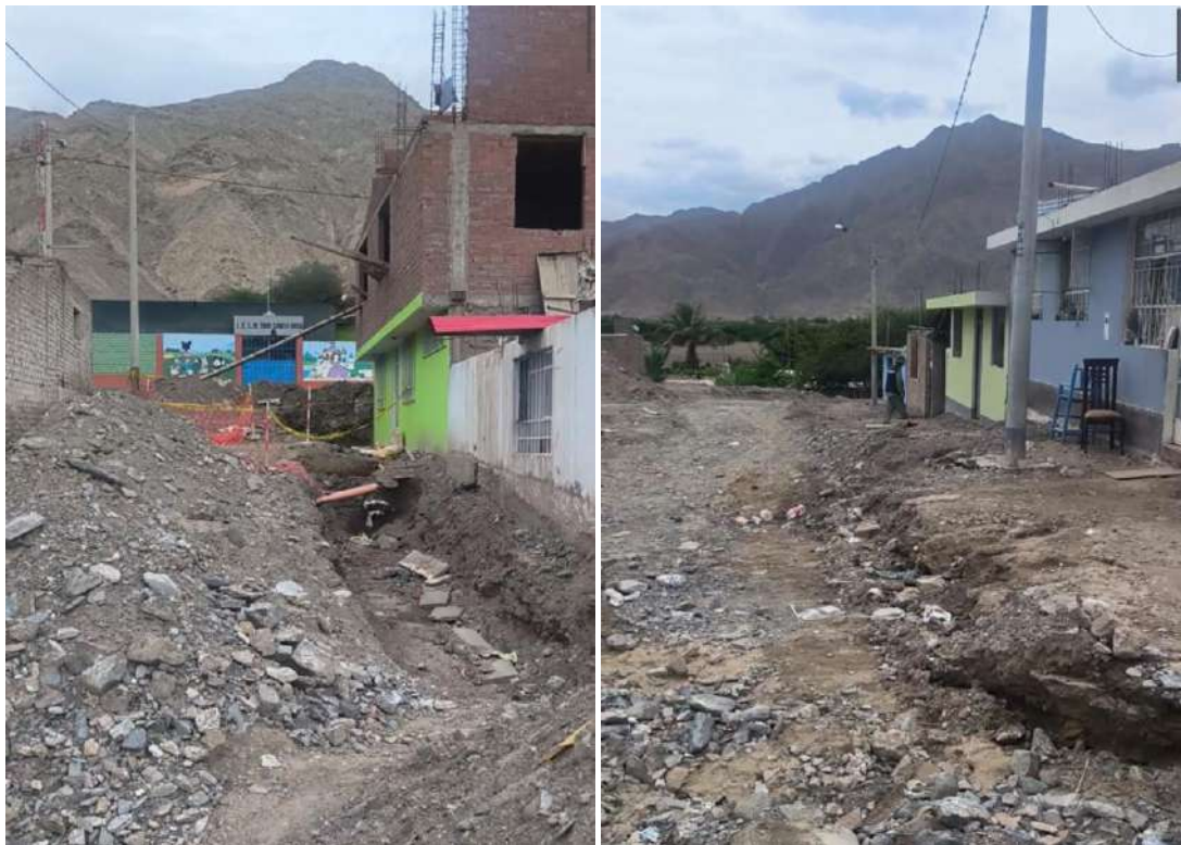
Figura 10. Viviendas afectadas, calles socavadas por flujo de detritos (huaico). Sector Santa Rosa. Coordenadas UTM 506044 E; 8362296 N.
