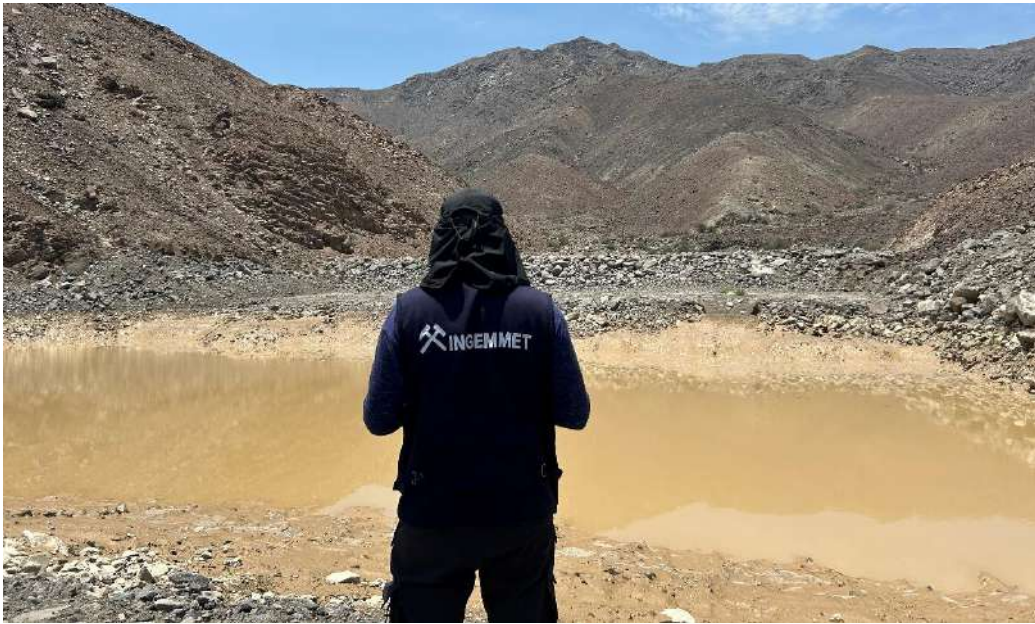
Fotografía 19. Parte alta de la quebrada Llancay donde se han construido dos pozos de sedimentación para retener el material generado por los huaicos. Coordenadas UTM 428266 E; 8456618 N.
