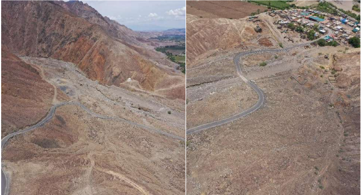
Figura 9. Vistas tomadas con dron del curso de quebrada en curso hacia las viviendas del Sector La Isla (Río Grande). Coordenadas UTM 479531 E; 8403251 N.
