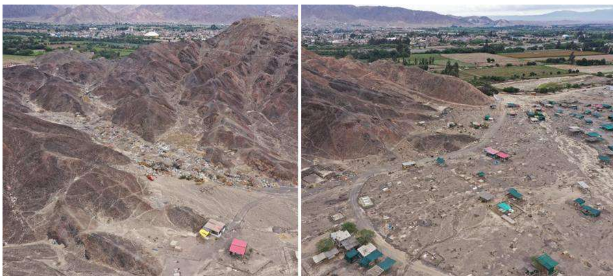
Figura 6. Sector Ajá Alto, curso de quebrada, afectan el nuevo cementerio Aja. Coordenadas UTM 506172 E; 8362416 N
