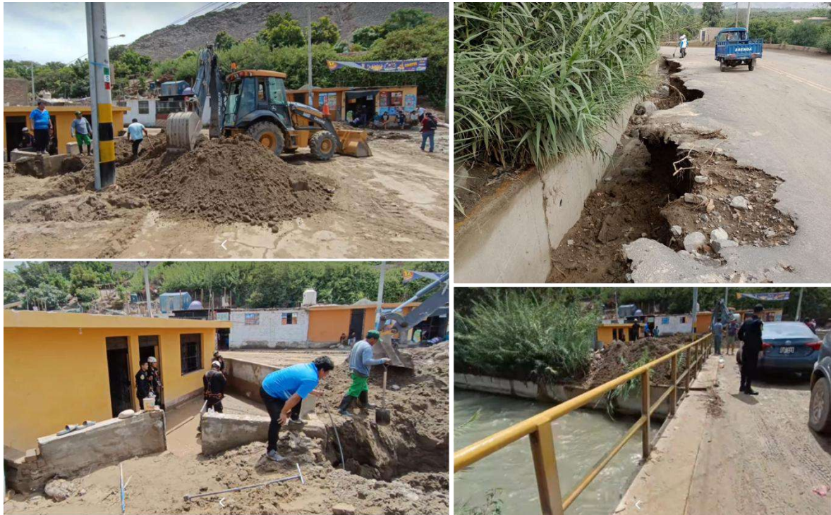
Figura 13. Viviendas afectadas por flujo de detritos (huaico) del año 2024 en el sector Pampa de Islas. Imágenes tomadas por las autoridades del distrito San José de Los Molinos. Coordenadas UTM 425071 E; 8456698 N.
