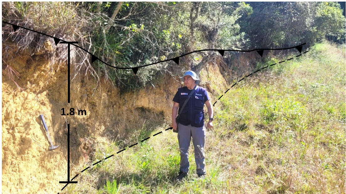
Figura 8. Escarpe de deslizamiento, el salto vertical tiene 1.7 m.
