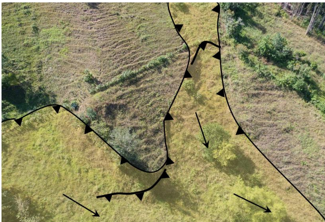
Figura 10. Se observa escasa vegetación y ausencia de drenajes en la ladera, lo que contribuye a la saturación del terreno.
