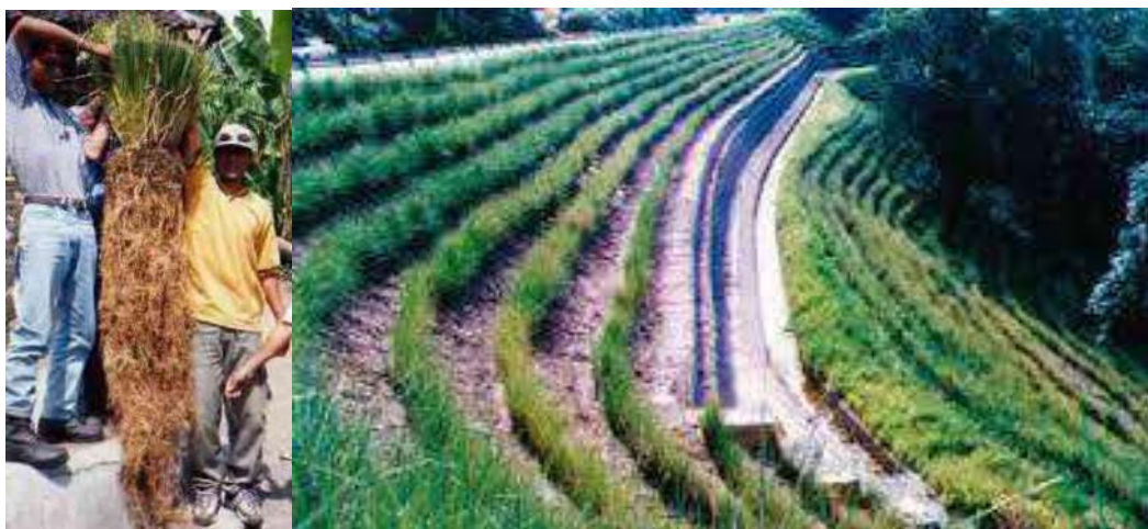
Figura 36. Ejemplo de bioingeniería con arbusto (vetiver) en taludes de materiales sueltos.
