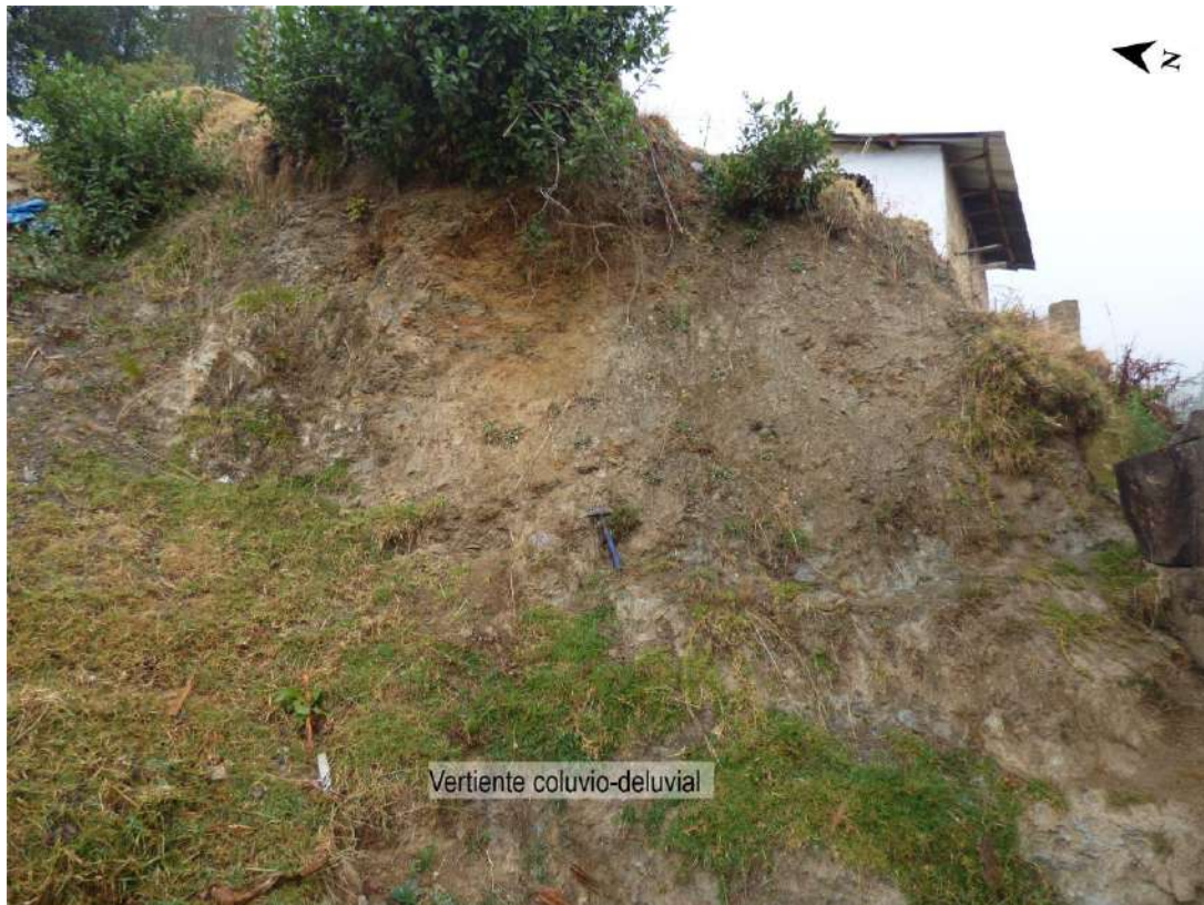
Figura 18.5 Detalle de Vertiente coluvio-deluvial, conformado por depósitos de antiguos deslizamientos en el sector Marías. Vista mirando al noreste.
