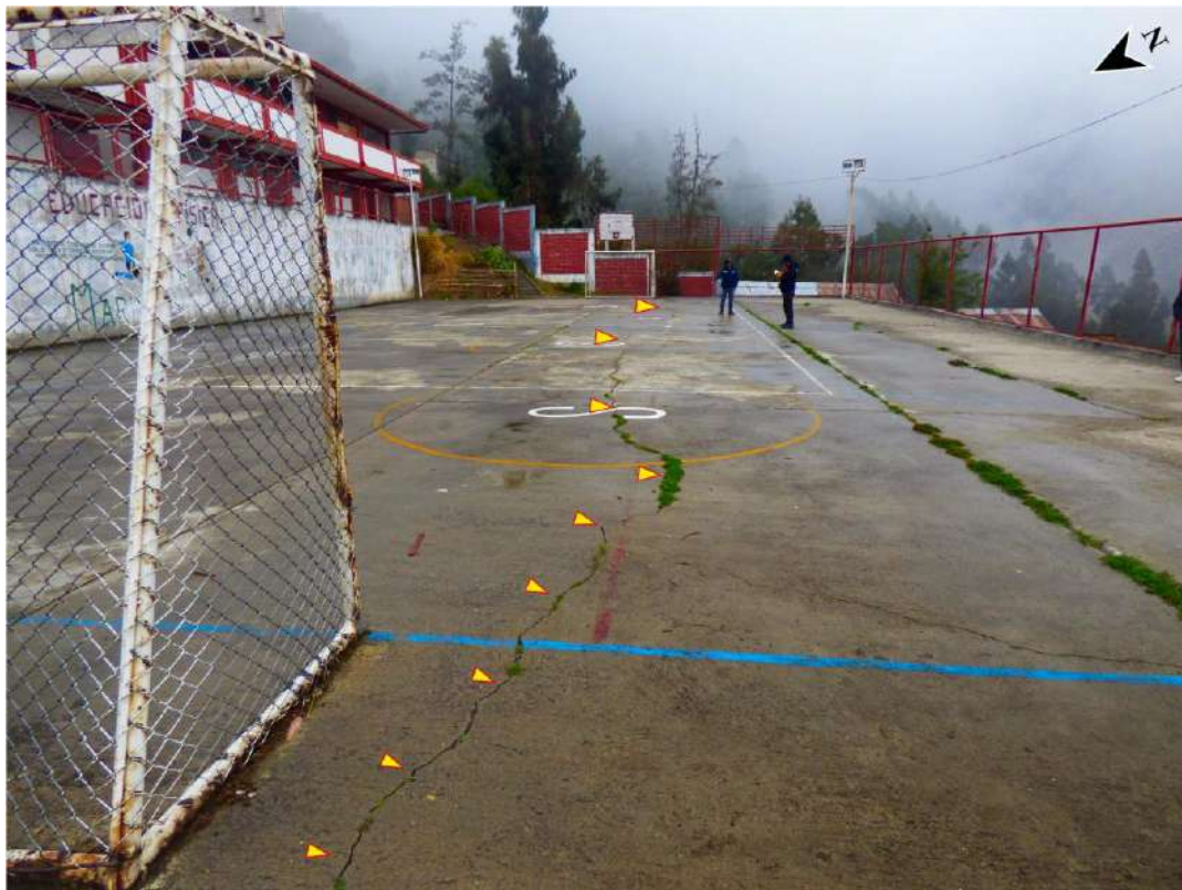
Figura 24. Grieta interna en el cuerpo del deslizamiento activo, situado en la I.E. N°32230 del distrito de Marías (E:313162, N:8937447).
