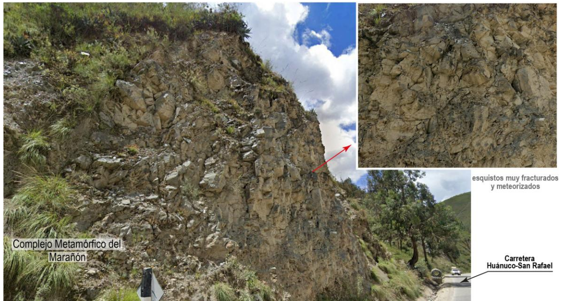
Figura 8.5. Corte de carretera situado a la entrada del distrito San Rafael. Se muestra un macizo rocoso constituido por esquistos muy fracturados y fuertemente meteorizados que le dan un aspecto fragmentado a triturado de Complejo Metamórfico del Marañón. Vista mirando al norte.
