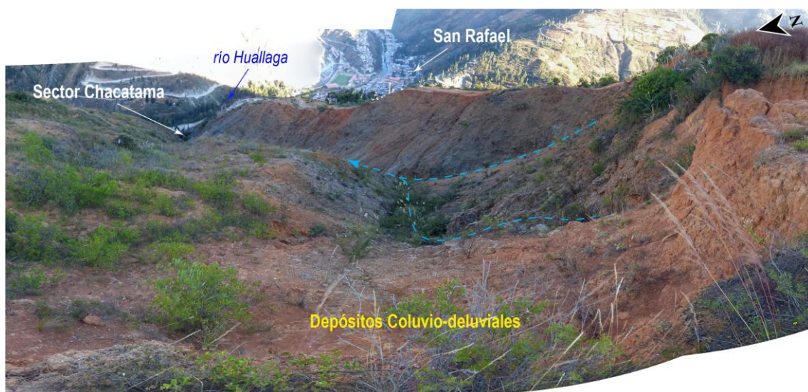
Figura 9. Depósitos coluviales-deluviales en la parte media superior de la ladera que mira hacia el río Huallaga.
