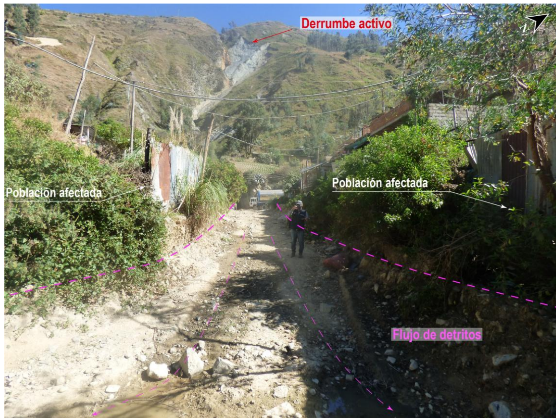
Figura 21. Flujo de detritos que se abre paso en la misma dirección de una trocha carrozable que se dirige hacia el río Huallaga. Este evento afectó lateralmente a la población asentada al pie de la ladera. Nótese, el nivel precario de la construcción. Vista mirando al noroeste.
