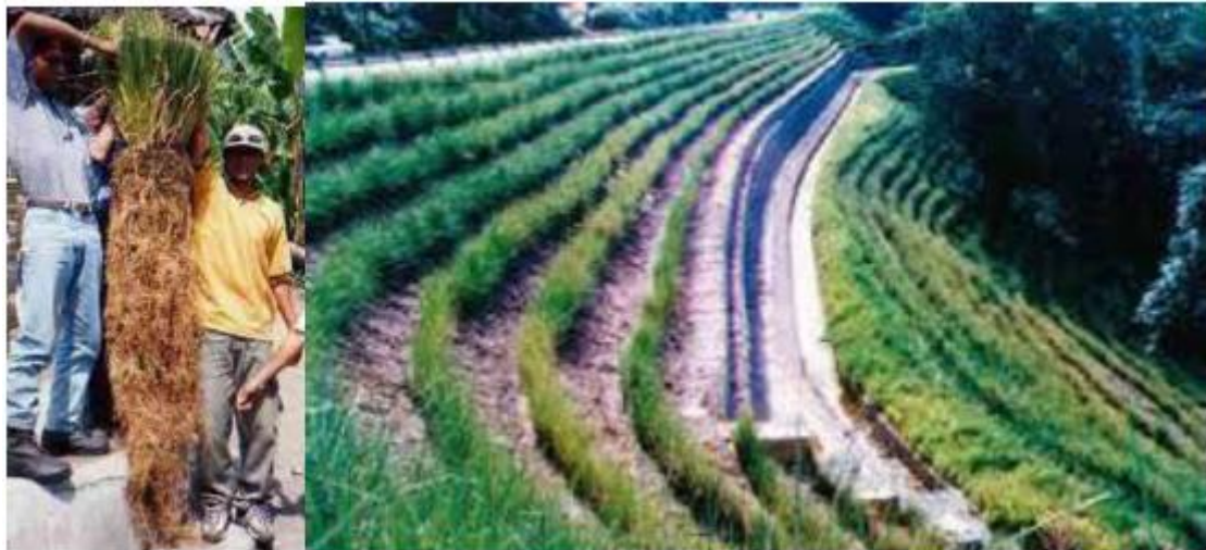
Figura 29. Ejemplo de bioingeniería con arbusto (vetiver) para reforestación de taludes inestables.
