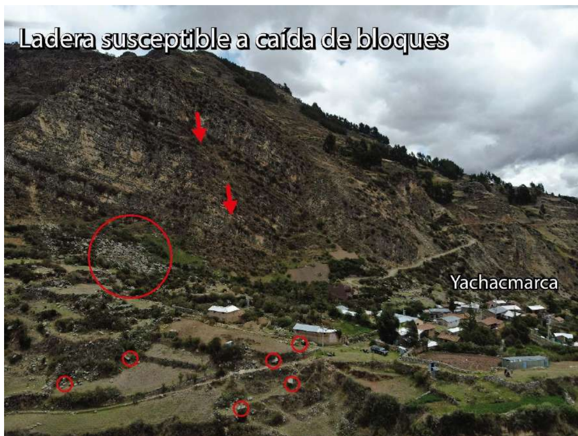
Figura 22: Evidencias de caída de bloques en el sector de la comunidad de Yachacmarca UTM: WGS 84, 18s, , X: 513301.33; Y: 8602670.60.
