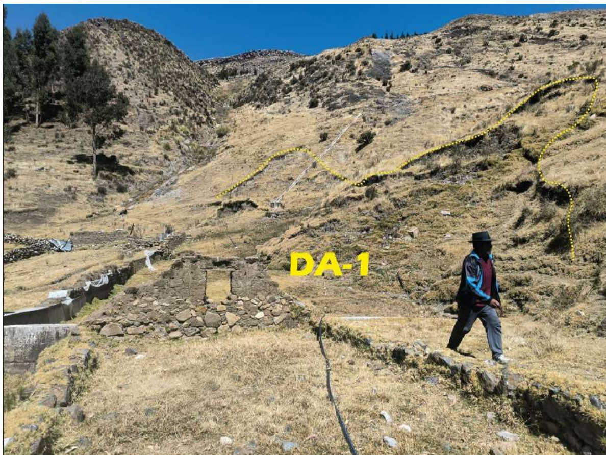
Figura 12. Vista de la corona del deslizamiento rotacional activo 1 (Da-1), donde se observa el escarpe principal de aproximadamente 2,5 m de altura, desarrollado sobre los cuerpos de deslizamientos antiguos (DIL-1 y DIL-3).
