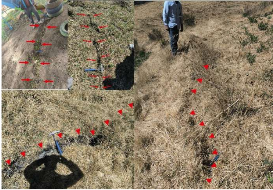
Figura 16. Grietas de tracción asociadas al deslizamiento rotacional activo 2 (Da-2), identificadas en el sector de Santa Rosa de Ccocha, las cuales evidencian deformaciones progresivas en el terreno.
