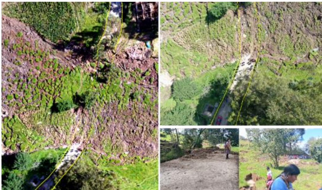
Figura 13. Se observa la vía CA-3N afectada.
