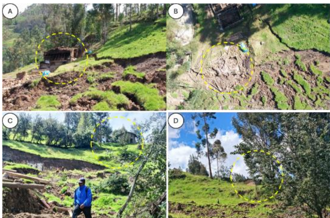
Figura 12. En las imágenes A y B se observan las 2 viviendas que han sido afectadas, mientras que en las imágenes C y D se aprecian las 3 viviendas expuestas al deslizamiento activo – DA1.
