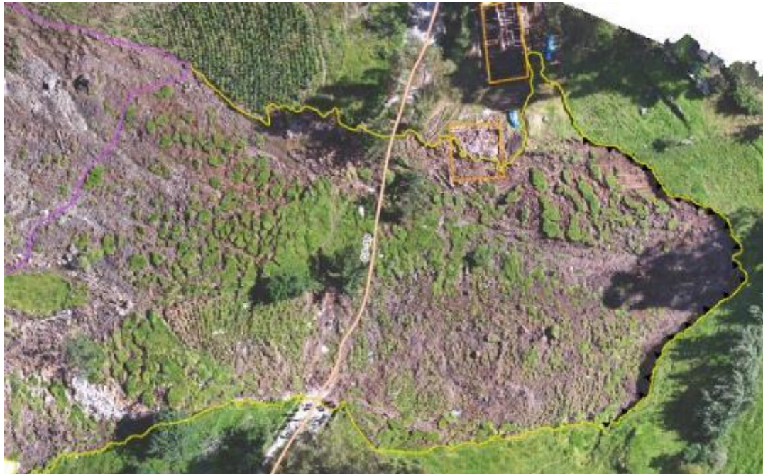
Figura 10. En la imagen se observa una vista en planta del deslizamiento DA1 cuya extensión horizontal es de 60 m. Se visualiza el tramo obstruido de la vía CA-3N (línea rosada) y las 2 viviendas afectadas (línea naranja).
