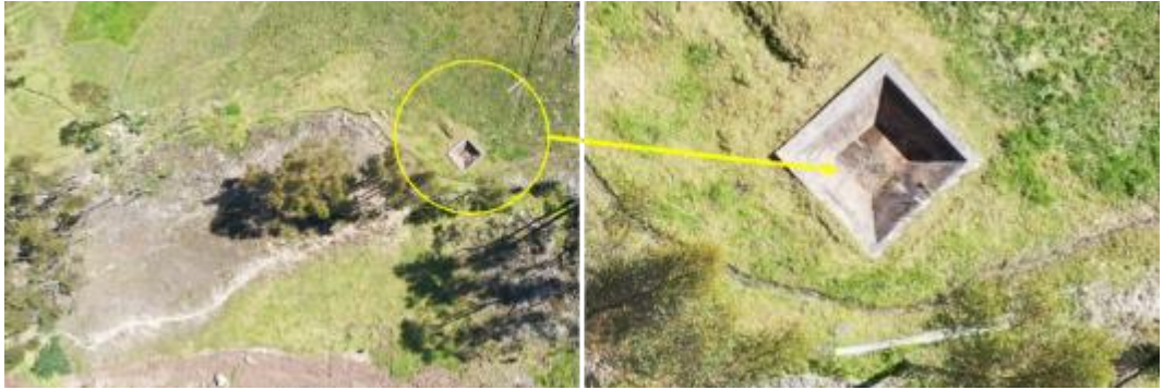
Figura 18. Reservorio de agua expuesto al deslizamiento activo DA2.
