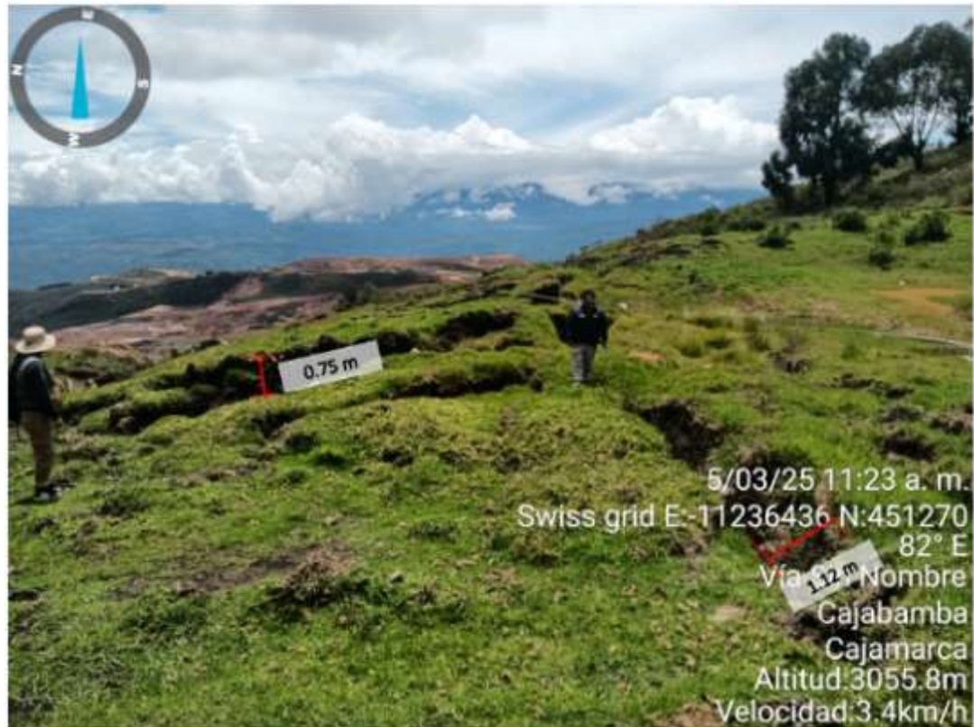
Figura 10. Agrietamientos en el cuerpo del deslizamiento con escarpes visibles de 0.75 m y 1.12 m de altura.
