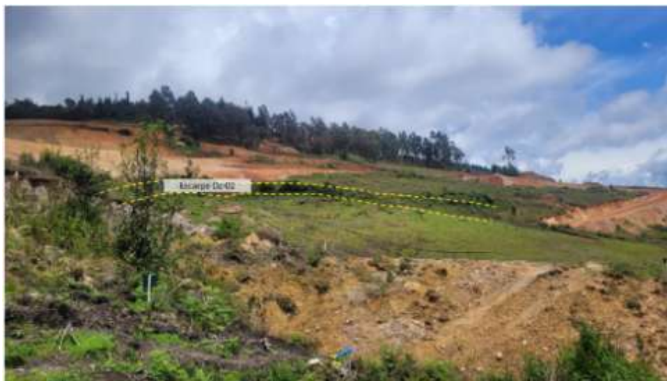
Fotografía 9. Escarpe de deslizamiento 02, con saltos de escarpe entre 0.10 m y 0.35 m.
