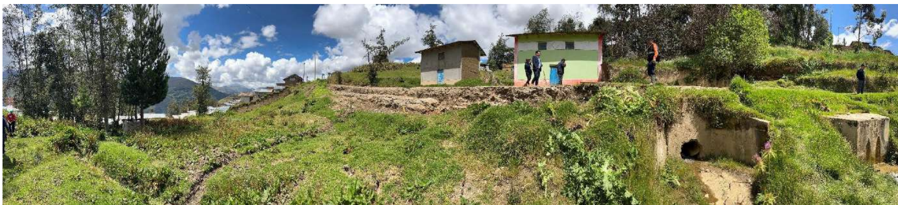
Fotografía 3. Vista hacia el suroeste del deslizamiento de Chaupis. Se evidencia el sistema de drenaje en parte con revestimiento.
