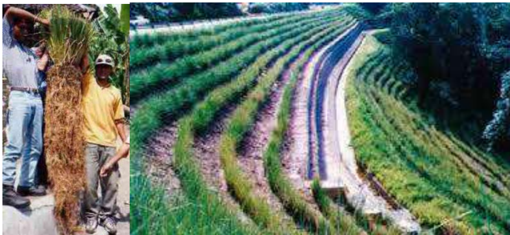
Figura 3. Ejemplo de bioingeniería con arbusto (vetiver) en taludes de materiales sueltos.
