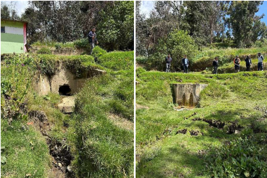
Figura 13. Drenaje sin revestimiento en el sector Chaupis, lo que genera infiltración de las aguas en el terreno y la saturación del mismo. Estas condiciones contribuyen en la generación de un terreno inestables propenso a la ocurrencia de movimientos en masa.
