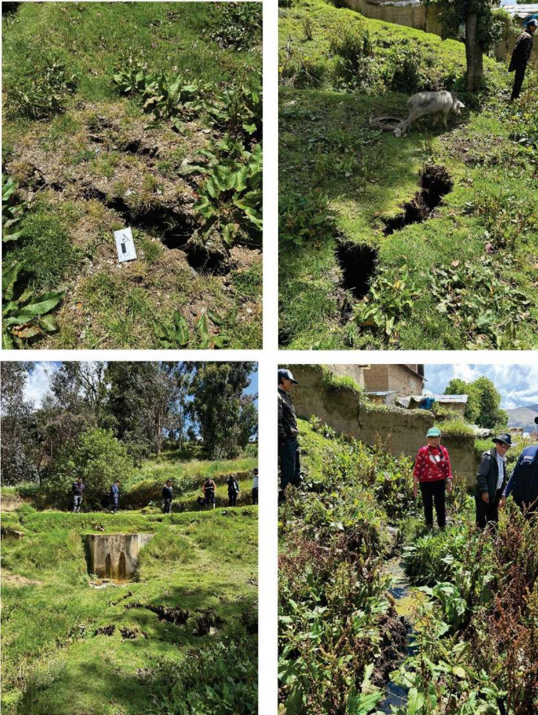
Figura 11. Evidencia de los agrietamientos en la masa deslizada del sector Chaupis. Los agrietamientos presentan aberturas de hasta 20 cm. y 40 cm de profundidad, y son transversales y longitudinales al escarpe principal del deslizamiento.
