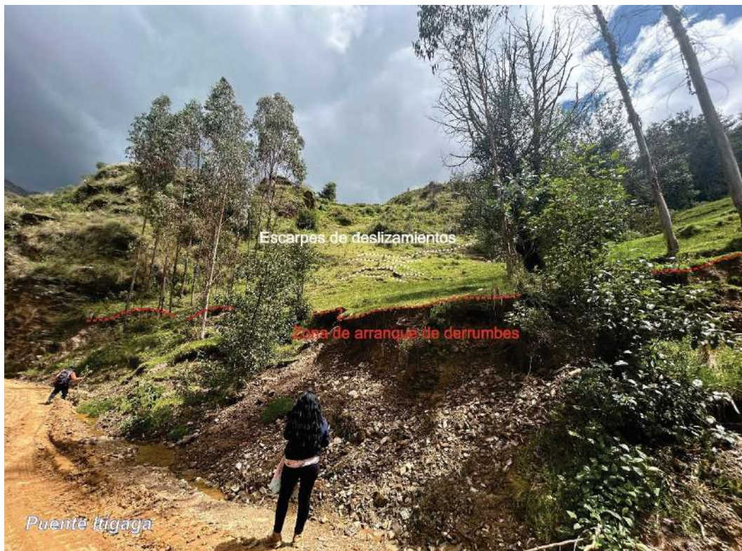
Figura 15. Escarpes de deslizamientos y derrumbes recientes originados en la vía de acceso al sector Chaupis, debido a las precipitaciones pluviales (lluvias) entre los meses de febrero y marzo del presente año.
