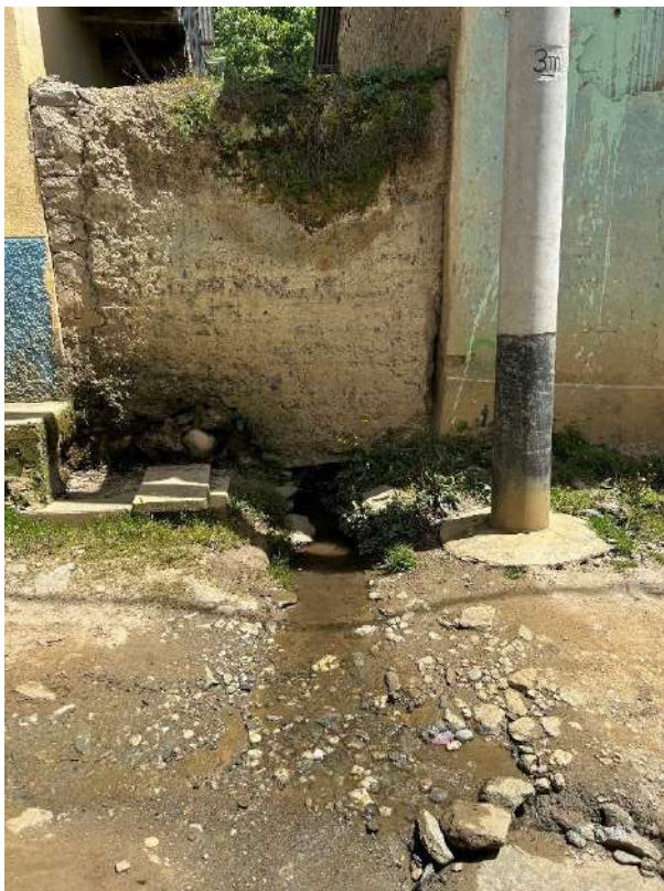
Figura 13. Drenaje sin revestimiento en el sector Chaupis, lo que genera infiltración de las aguas en el terreno y la saturación del mismo. Estas condiciones contribuyen en la generación de un terreno inestables propenso a la ocurrencia de movimientos en masa.
