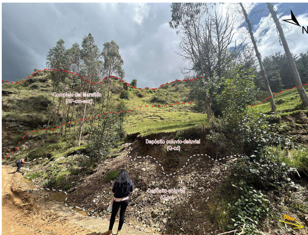
Figura 6. Depósito coluvio-deluvial y coluvial identificado a la altura del puente Itigaga. Hacia el fondo, se puede observar el Complejo del Marañón. Coordenadas WGS 84, 18s, X: 317029 m E; Y: 8914241 m S.
