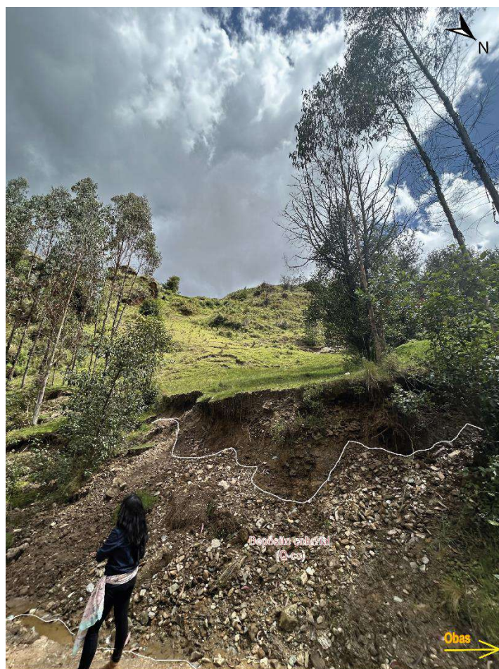
Figura 7. Depósitos coluviales inconsolidados originados por derrumbes recientes en depósitos coluvio deluviales. Coordenadas WGS 84, 18s, X: 317029 m E; Y: 8914241 m S.
