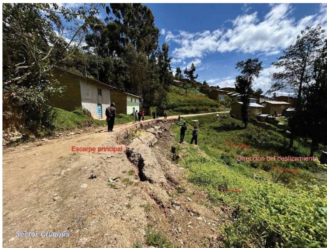
Figura 10. Escarpe principal del deslizamiento identificado en el sector Chaupis, así como la dirección de la masa deslizada hacia el noreste-este.
