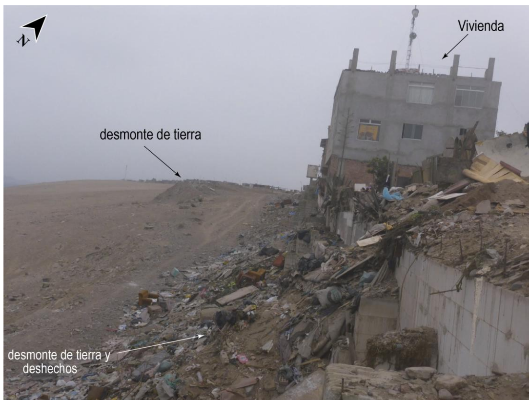
Figura 17. Viviendas de material noble de hasta de 3 niveles construidas en la parte inmediatamente superior al muro de contención. También se observa desmontes de tierra y basura. Esto, ubicado en la parte sur del sector evaluado.
