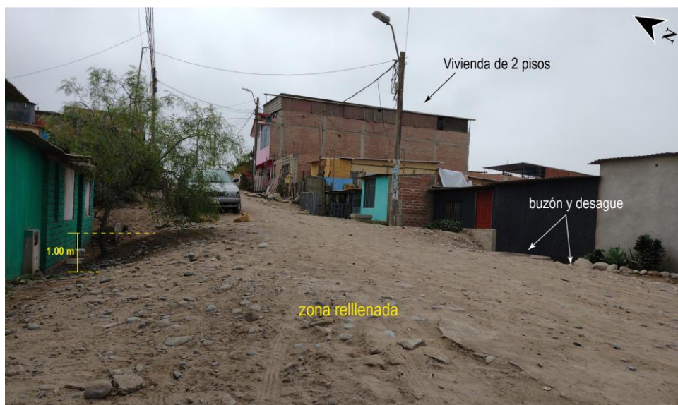
Figura 19. Zona rellenada de ~1 m de espesor aproximadamente con material de gravas, arenas y limoarcillas en el sector 9 Grupo residencia 3-A. Este relleno se hizo sobre suelos incompetentes del Lomo de Corvina. Se observa buzones y desagües, tuberías que podrían colapsar con eventos sísmicos, asimismo, al fondo de visualiza construcciones de viviendas con material noble de hasta 2 pisos.
