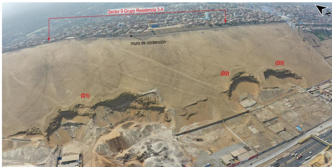
Figura 13. Áreas de alta susceptibilidad a derrumbes D1, D2, y D3 alojados en la parte inferior del talud del Lomo de Corvina. En la cresta de la lomada se encuentra asentada el sector 9 Grupo Residencia 3-A. Vista panorámica mirando al noreste.
