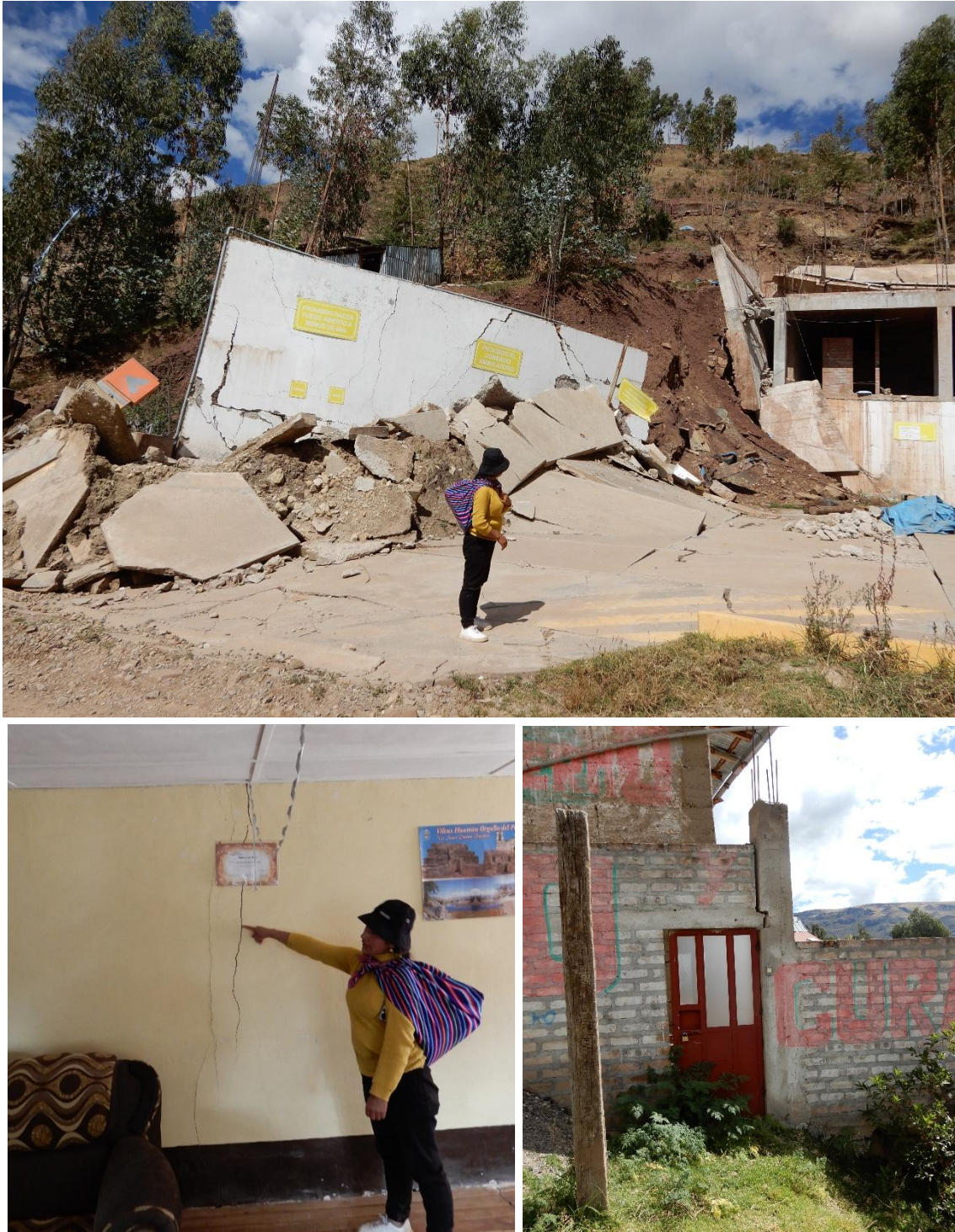
Figura 5. Grifo y viviendas afectadas por el deslizamiento del cerro Pucará.
