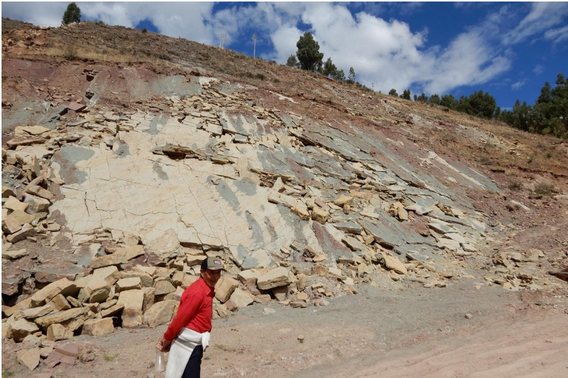
Fotografía 2. Deslizamiento traslacional producido el año 2024.
