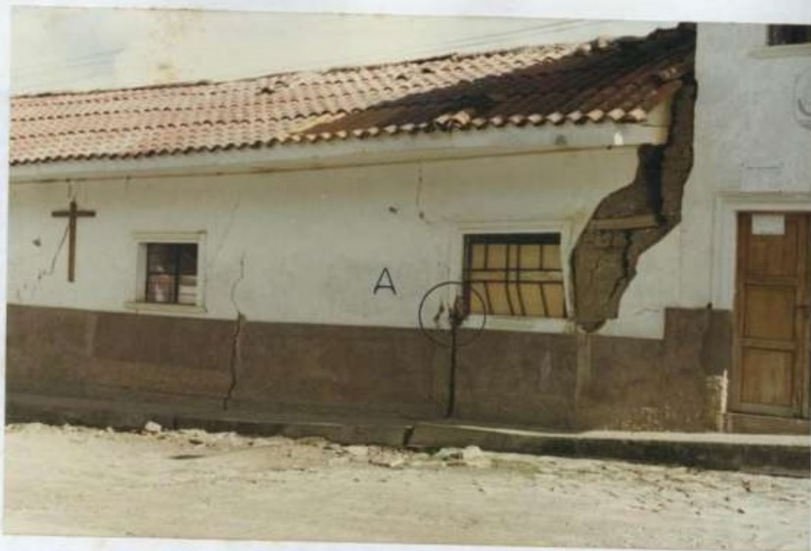
Foto 8: Fuertes agrietamientos en el local Parroquial (Plaza de Armas). A: Detalle en Foto 9.
