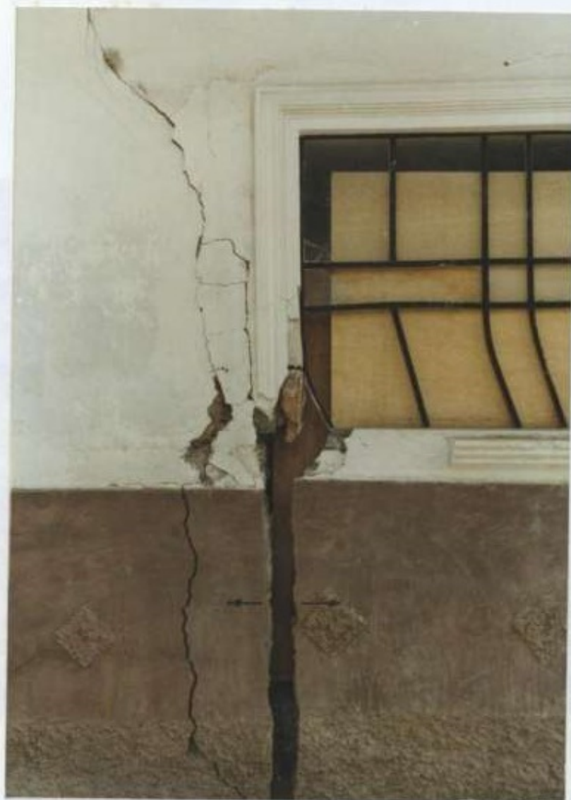
Foto 8: Fuertes agrietamientos en el local Parroquial (Plaza de Armas). A: Detalle en Foto 9.
