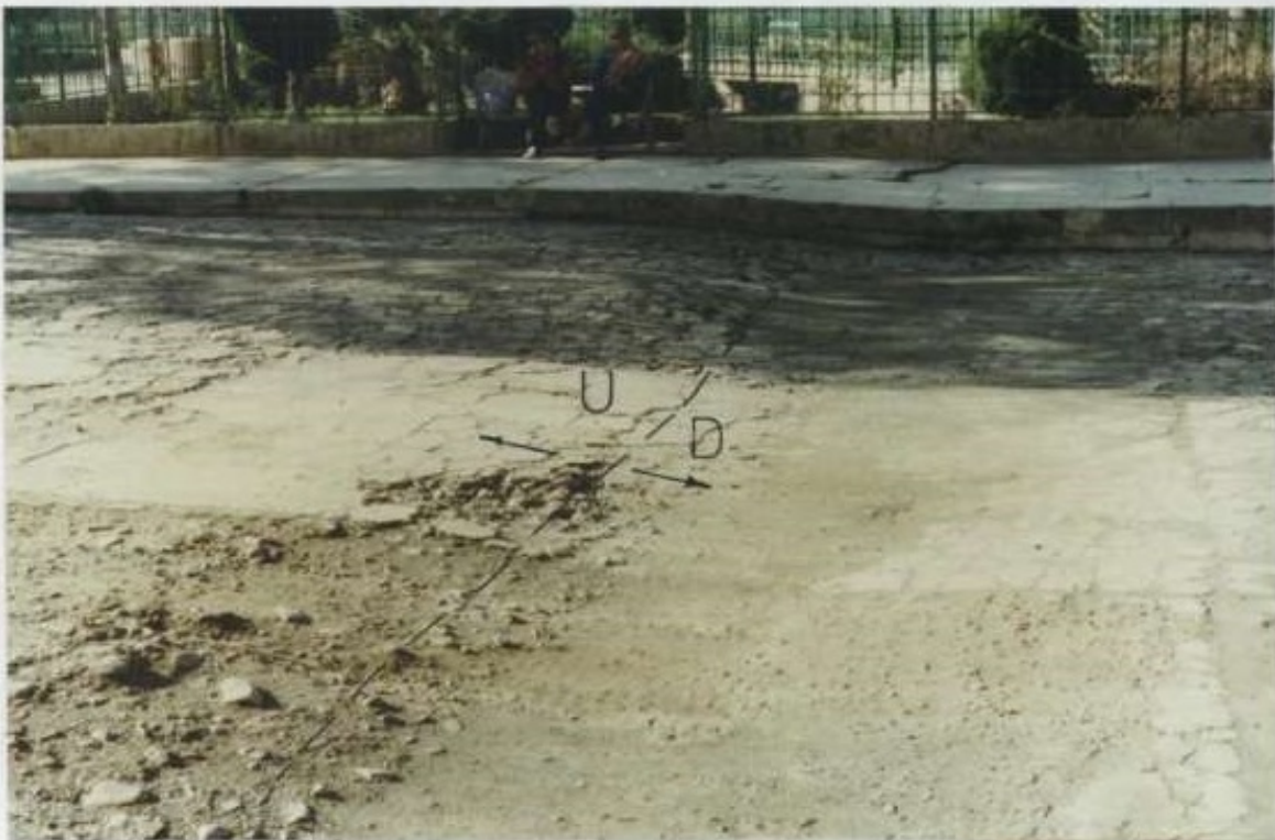
Foto 12: Desnivel observado en la Plaza de Armas de San Luis, productos de los empujes existentes.
