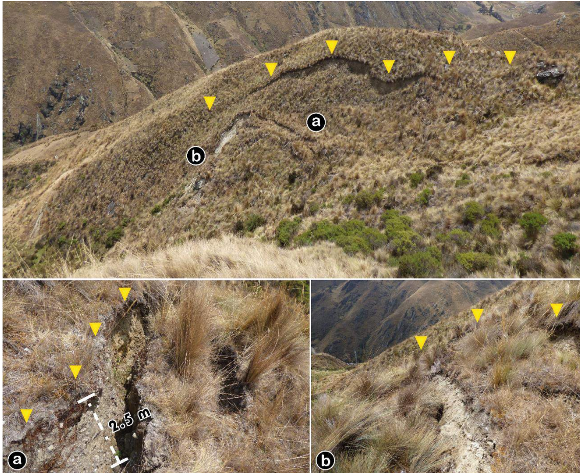
Figura 18: Vista del deslizamiento reactivado D1, con saltos principales de escarpe que varían de 2.0 a 3.0 m y señalados en triángulos color amarillo. Coordenadas referenciales UTM WGS-84, 18S E:320029, N:8944985.
