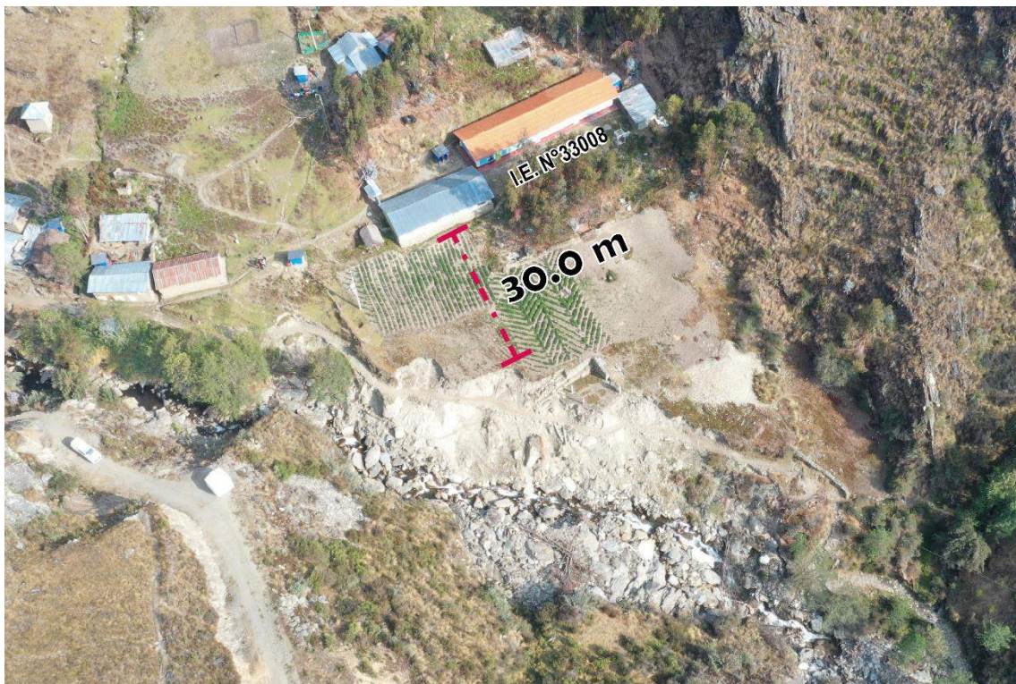
Figura 24: Erosión del cauce principal, a consecuencia de la recurrencia de flujos de detritos en la quebrada Progen. Nótese que los derrumbes al pie de la ladera se encuentran en la actualidad a 30 m de la vivienda más cercana.
