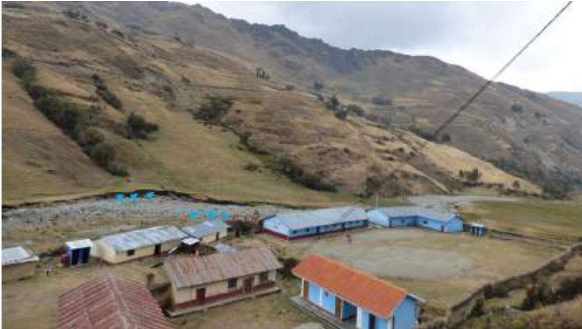
Figura 33: Vista panorámica, que muestra la IE N° 32742, con procesos de erosión fluvial (flechas de color celeste) y susceptible a inundación fluvial y/o flujos de detritos.
