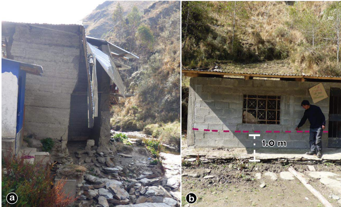
Figura 23: a. Afectación de vivienda a consecuencia del último evento de flujo de detritos en la quebrada Progen. Nótese la cercanía de la vivienda con respecto al cauce principal de la quebrada. b. Huellas dejadas por el flujo, con altura de 1.0 m registrada en pared de vivienda.
