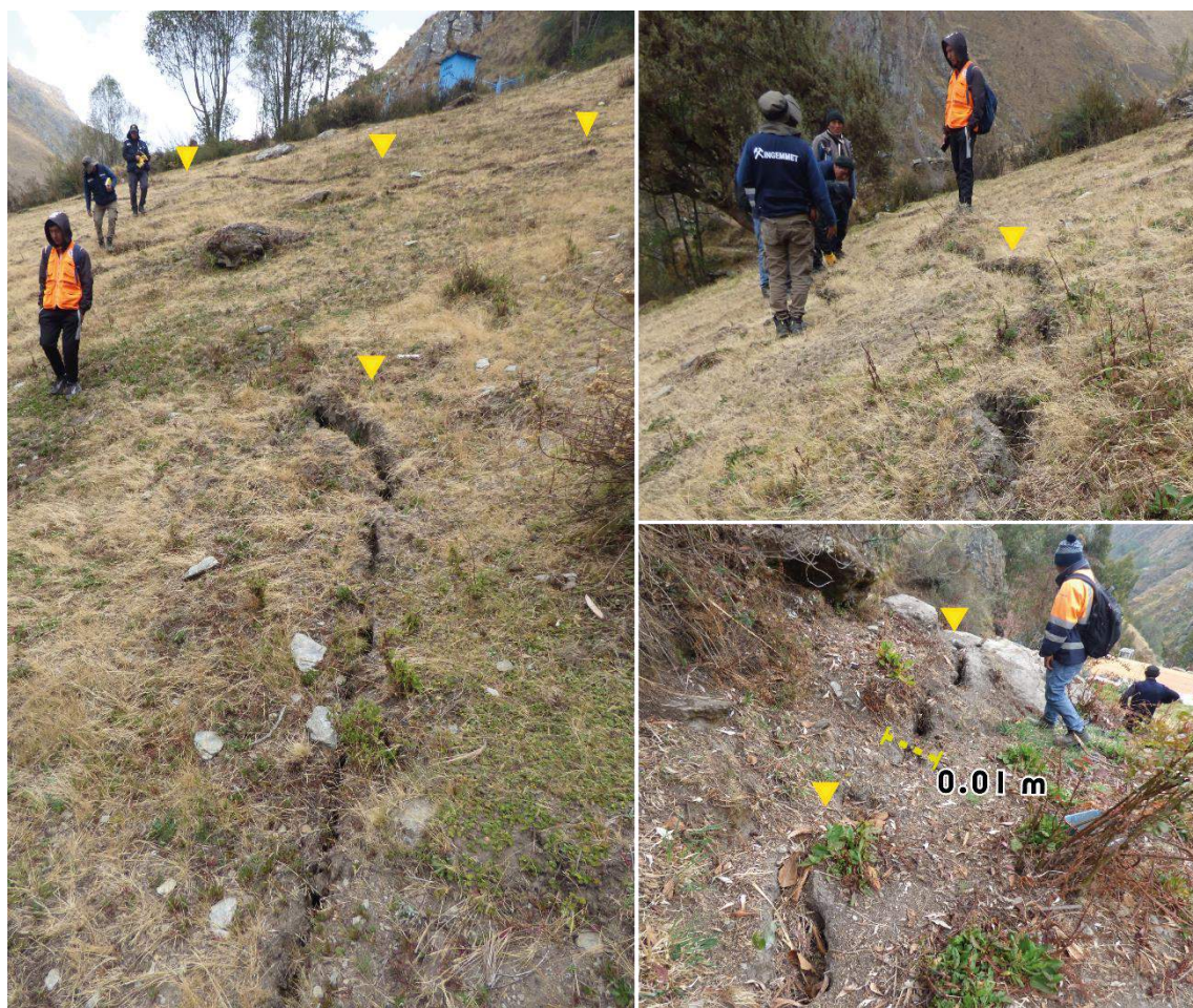
Figura 20: Evidencias recientes de la reactivación del deslizamiento D3, con grietas en el terreno, indicativos del avance progresivo de la masa deslizada. Coordenadas referenciales UTM WGS-84, 18S E:319777, N:8945188.
