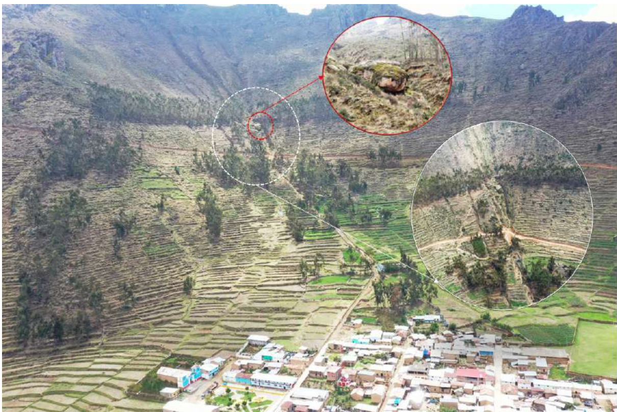
Figura 9. Procesos de erosión de ladera en cárcavas en la parte alta del cerro Antapa. En círculo rojo se observa el bloque que podría ser arrastrado cuesta abajo y afectar a las viviendas de Hongos.
