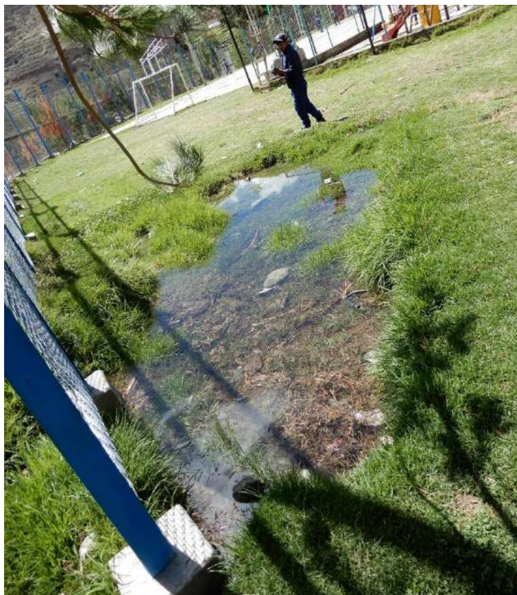
Fotografía 9. Vista de ojos de agua en el terreno de la Institución Educativa.
