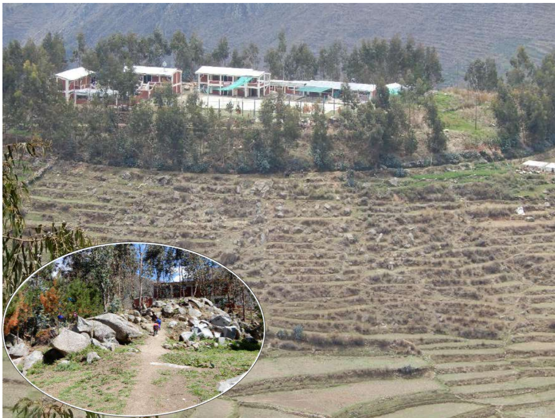
Figura 7. Vista de la Institución Educativa N°2097 asentada sobre depósito de avalancha antigua.
