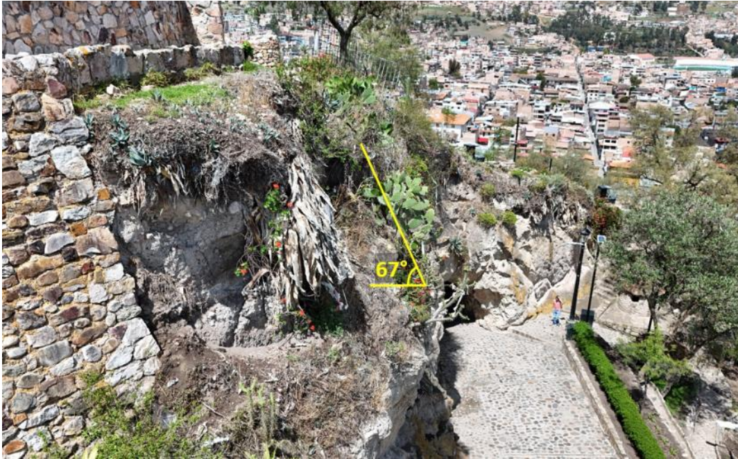
Figura 4. Pendiente de ladera >45^\circ en el flanco derecho de la colina Santa Apolonia, donde se originan los derrumbes.
