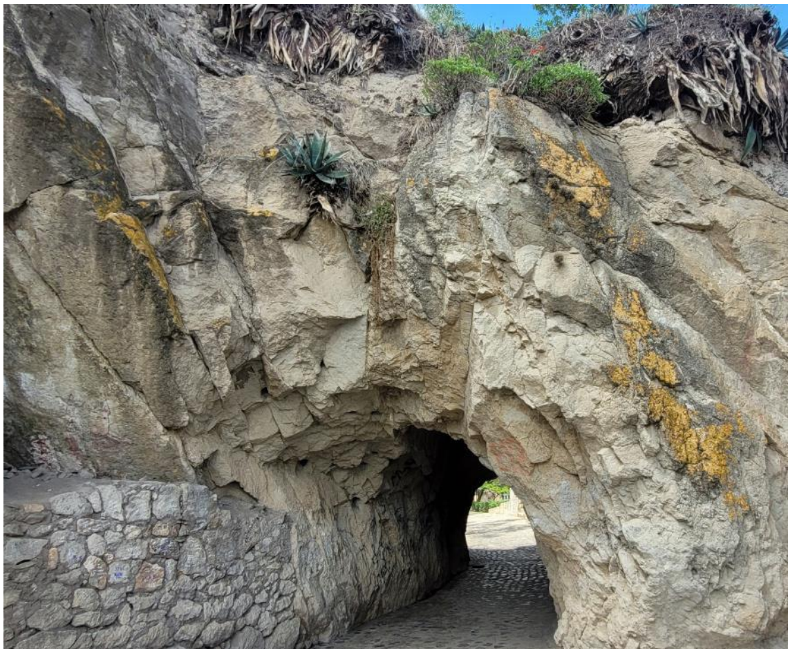
Figura 9. Macizo diaclasado, lado este del túnel, moderadamente meteorizado y medianamente a muy fracturado.
