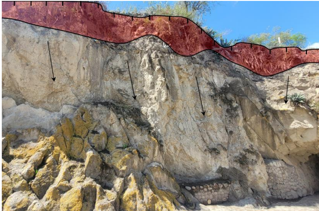
Figura 5. Derrumbe sobre un macizo de roca volcánica la cual se encuentra muy fracturada y moderadamente meteorizada.
