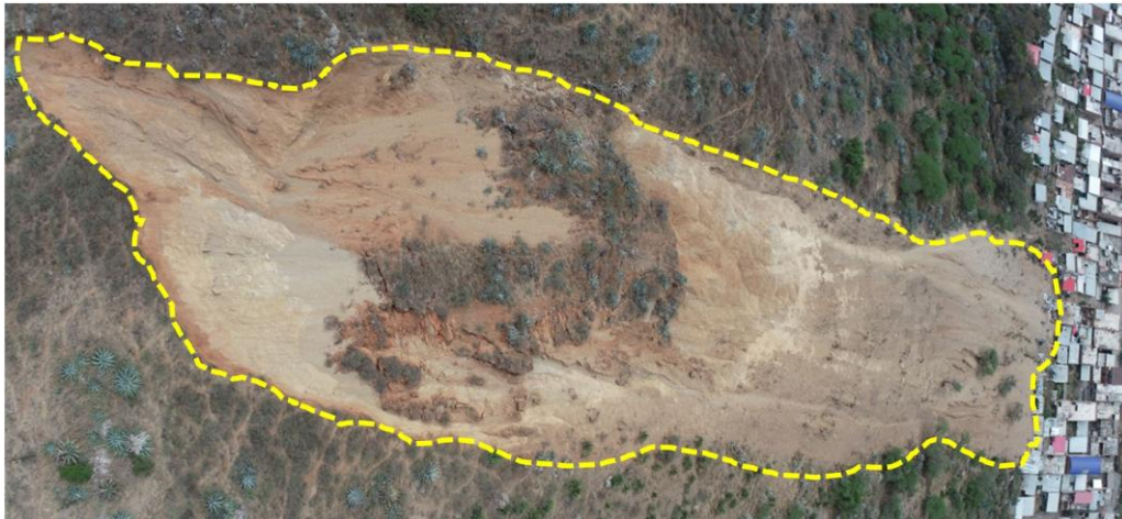
Figura 9: Se aprecia la vertiente coluvio-deluvial proveniente de la activación de deslizamiento, que ocurrió el 04 de junio del 2025.
