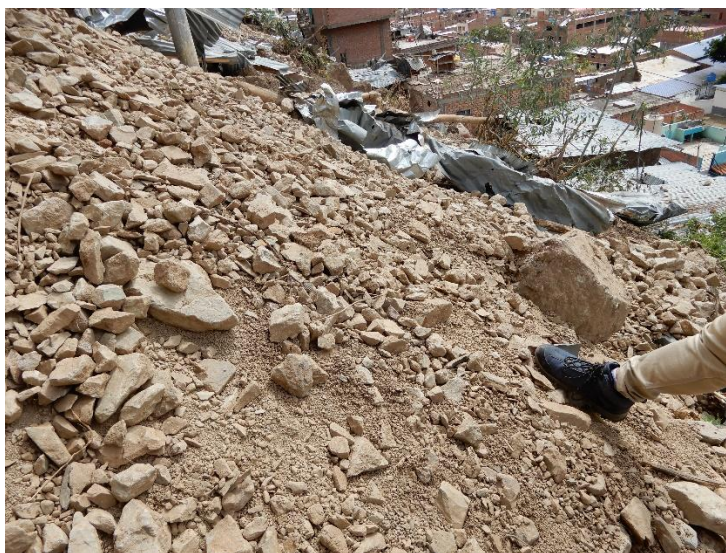
Fotografía 1: Se aprecia el material detrítico proveniente del derrumbe.
