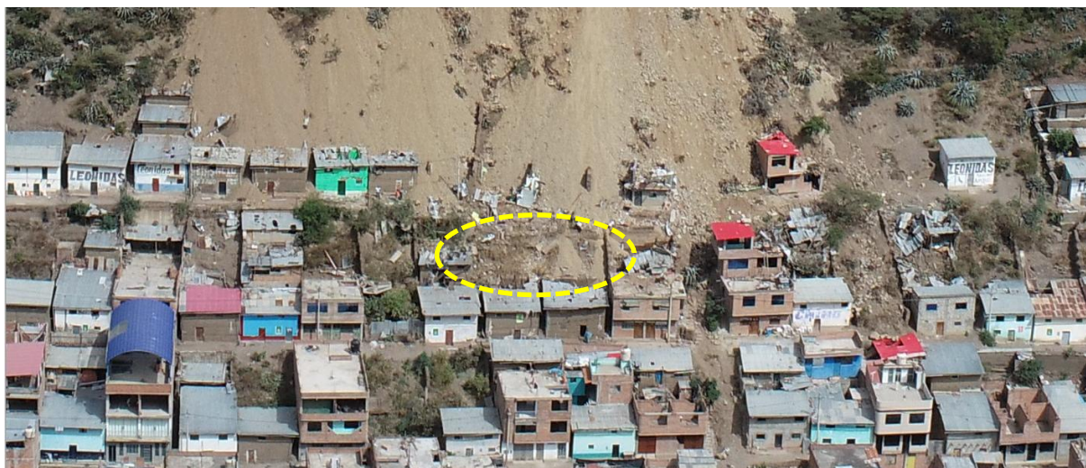
Figura 20. Se muestra la zona donde fueron destruidas viviendas.
