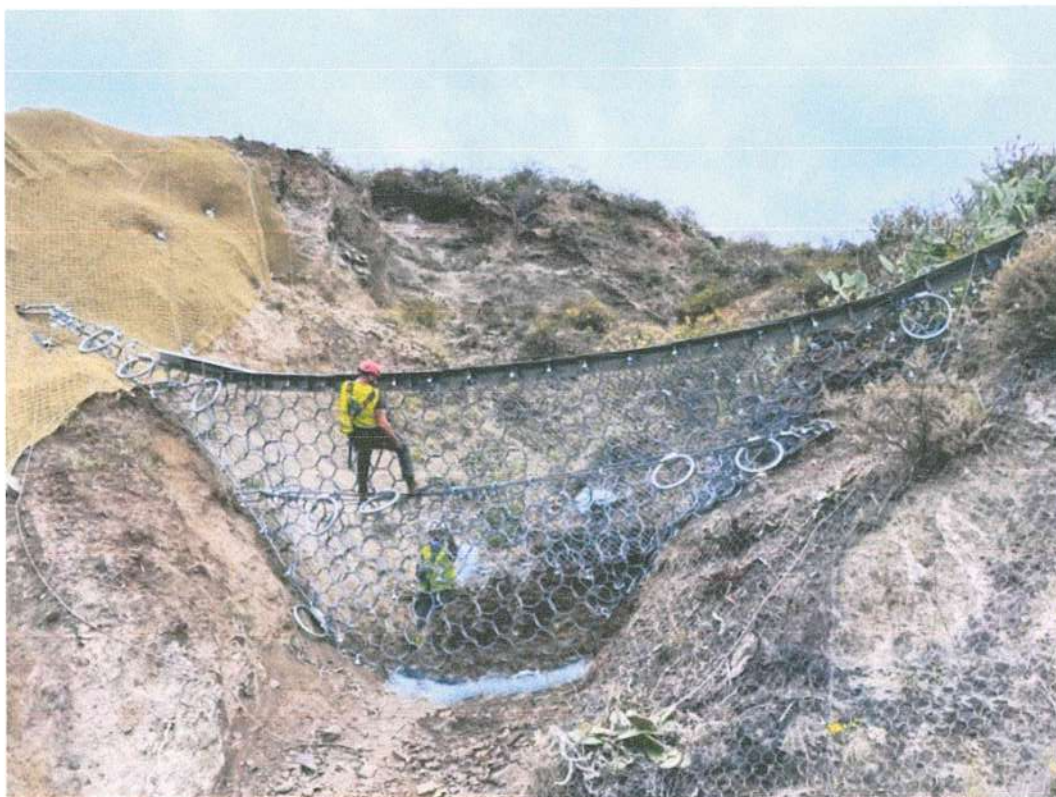
Figura 15: Detalle de una barrera dinámica para frenar el avance de grandes volúmenes de material.
