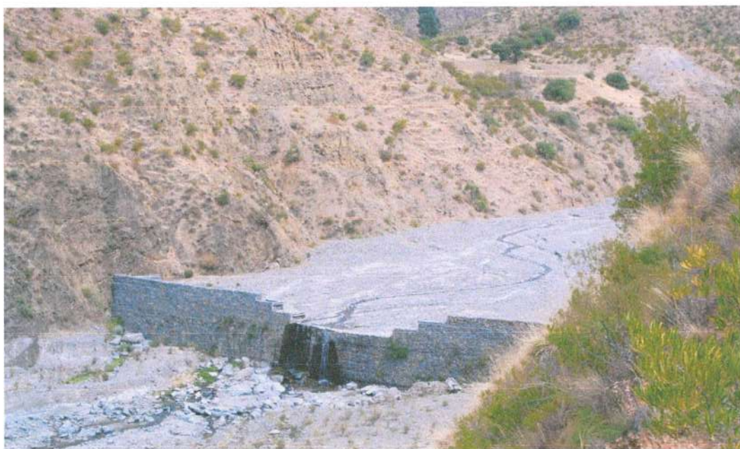
Figura 14: Detalle de mampostería gavionada formando una represa de sedimentos.
