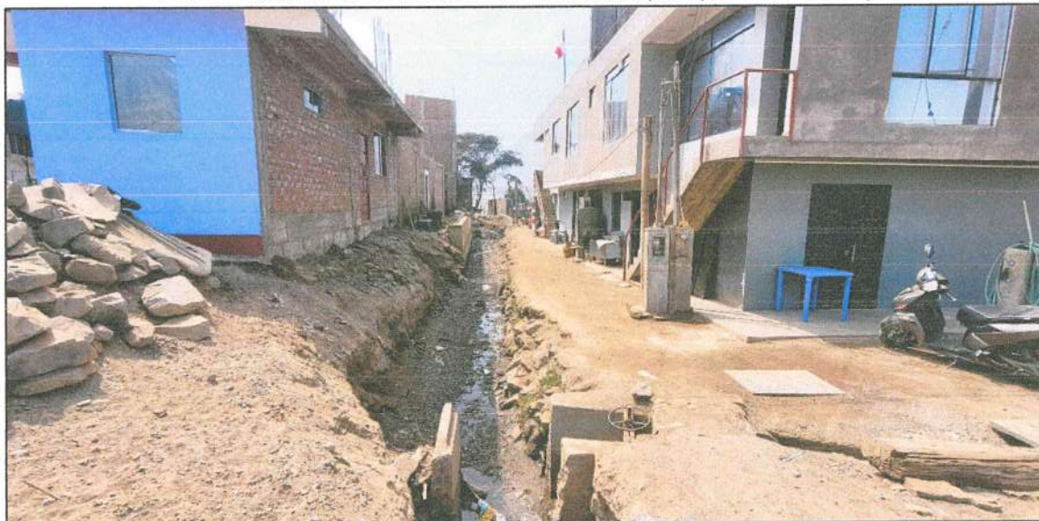
Foto 4: Viviendas construidas con material noble, principalmente ladrillo y concreto
