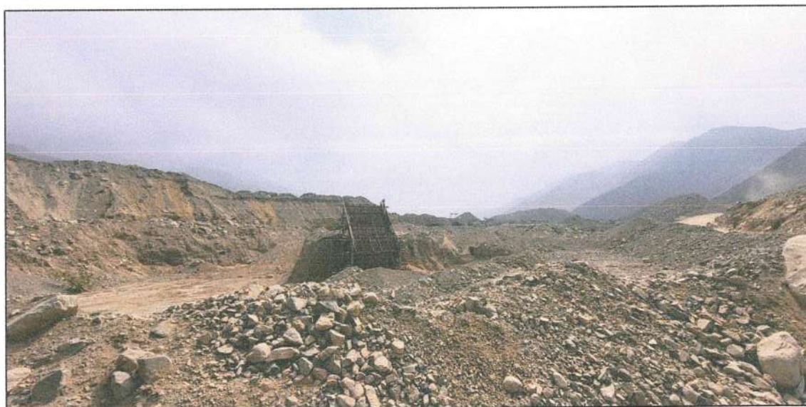
Foto 11: En el centro se observa una malla, posiblemente utilizada para la clasificación de material. El entorno evidencia actividades extractivas, lo que indica que la quebrada está siendo utilizada como cantera para la extracción de agregados
