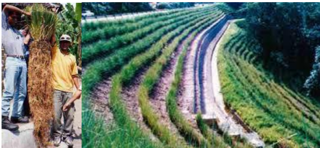
Figura 14. Ejemplo de bioingeniería con arbusto (vetiver) en taludes de materiales sueltos.
