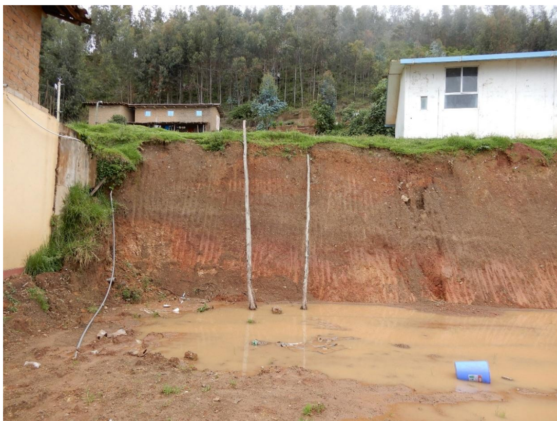
Fotografía 3. Depósitos coluvio-deluviales provenientes de derrumbes antiguos que fueron acumulados en la parte media superior de la ladera este del cerro Marco. Vista panorámica mirando al oeste.
