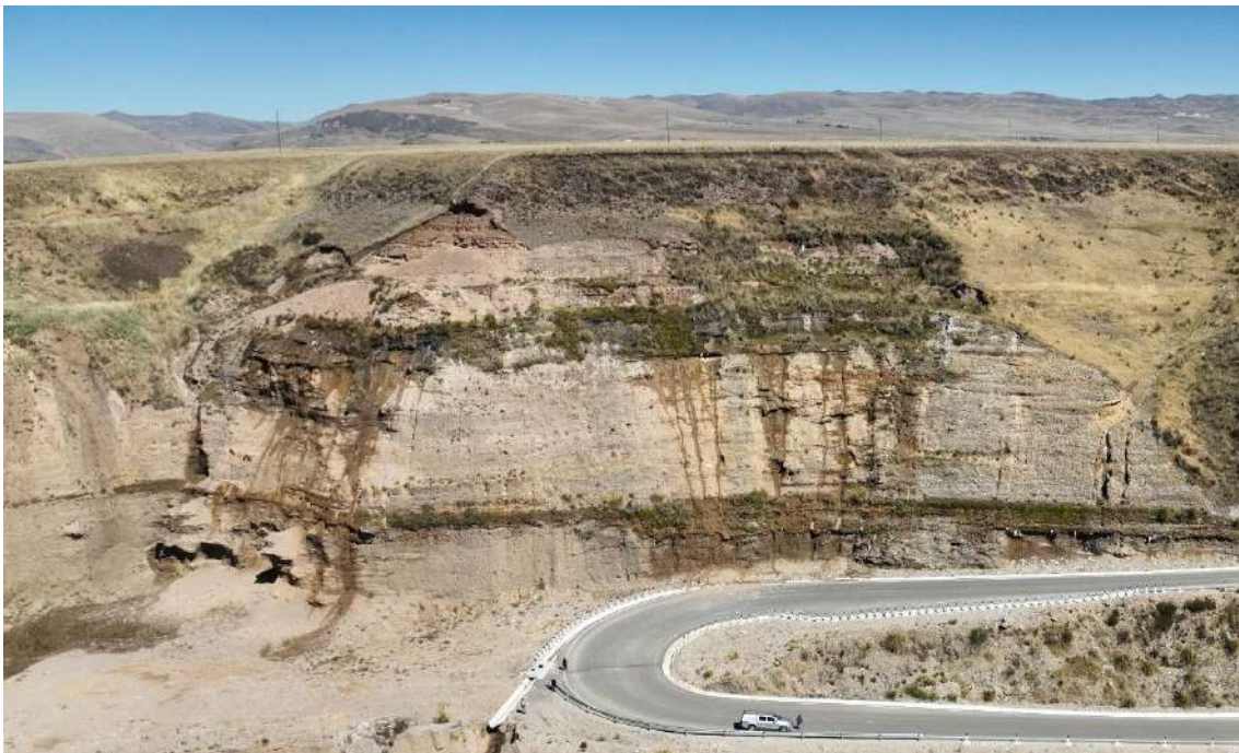
Fotografía 6. Vista a detalle de la escorrentía superficial el cual aumenta considerablemente en época de avenida en taludes semi verticalizados. Su permeabilidad media a alta condiciona el desprendimiento constante de materiales gravoso de hasta 12 cm de diámetro hacia la carretera.
