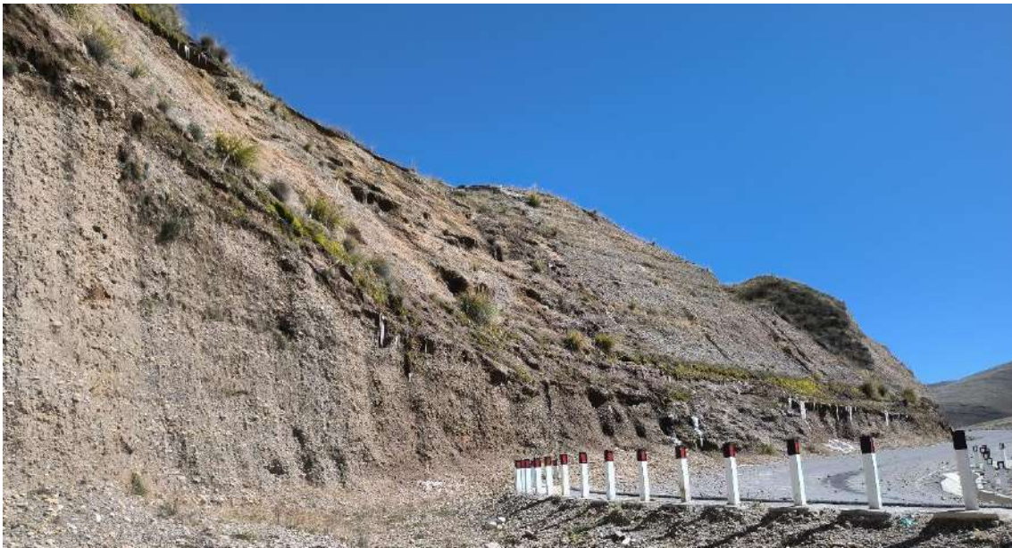
Fotografía 3. Depósito fluvio-glacial formados por gravas en una matriz de arenas gruesas y limos, inconsolidados, con un espesor de 50 m. Nótese la escorrentía superficial que condiciona la erosión y el desprendimiento de gravas hacia la carretera Vista Alegre – Chicche.
