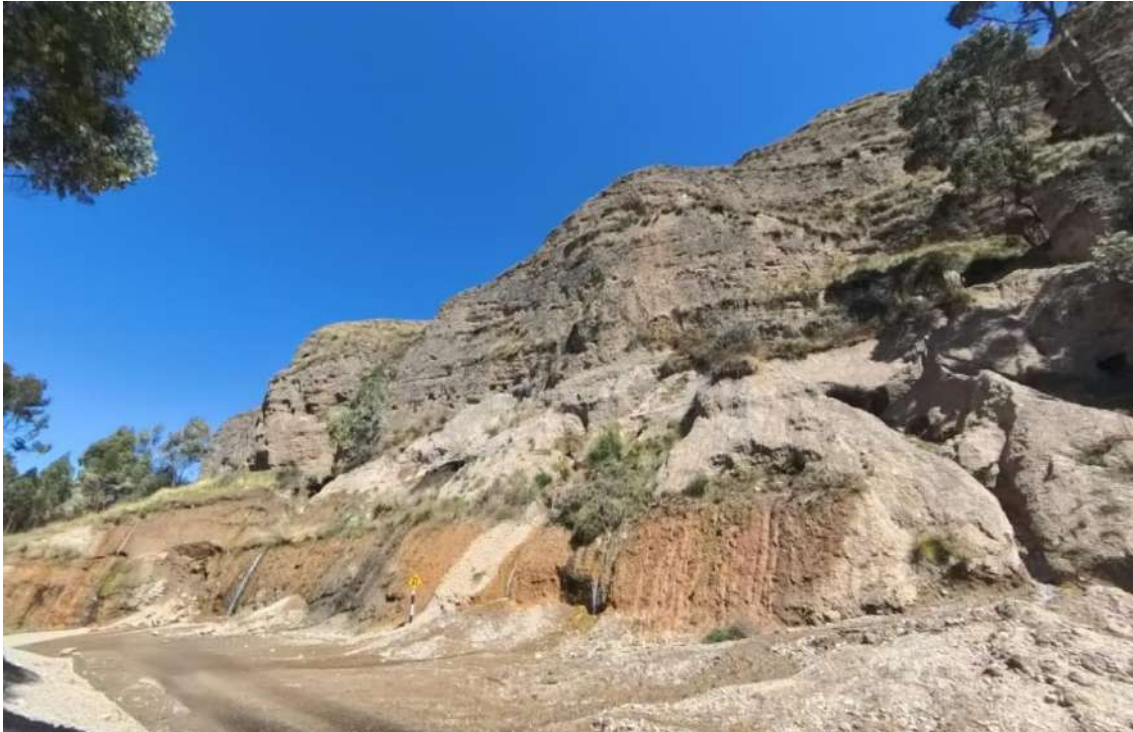
Fotografía 10: Procesos de erosión en cárcavas activos que afectan constantemente la vía Vista Alegre – Chicche, entre la progresiva 37+400 y 37+600. Obsérvese el material saturado producto de la escorrentía superficial, el cual aumenta en épocas de avenida.
