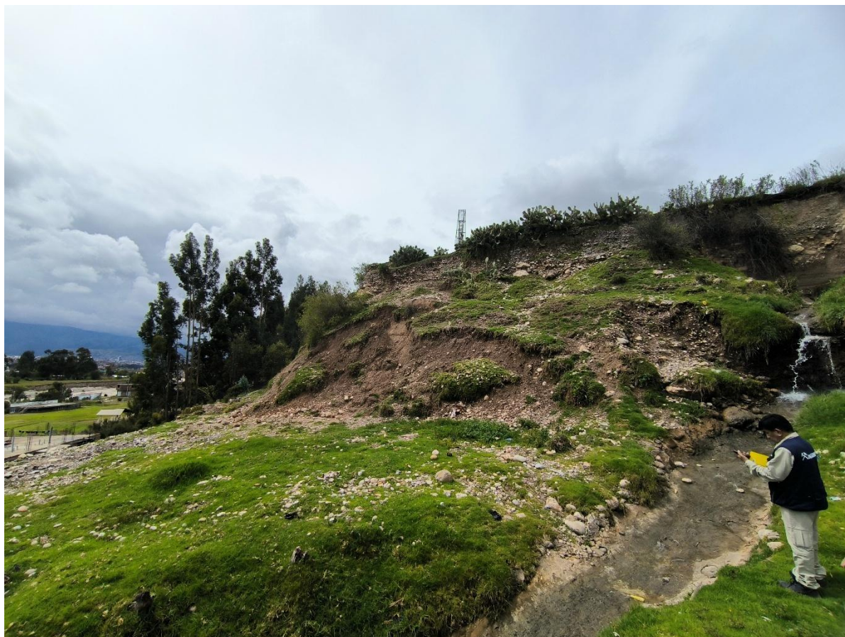
Fotografía 5. Evidencias de pseudo inestabilidad en la ladera adyacente a Viso Bajo por cortes de talud.
