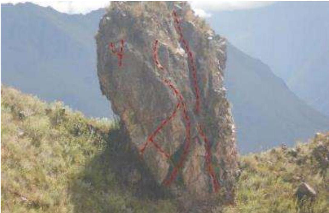
**Figura 3:** Bloque de roca que puede perder equilibrio, además, presenta fracturas que muestra su inestabilidad.
