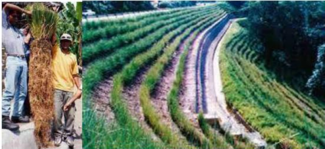
Figura 22. Ejemplo de bioingeniería con arbusto (vetiver) para reforestación de taludes inestables.
