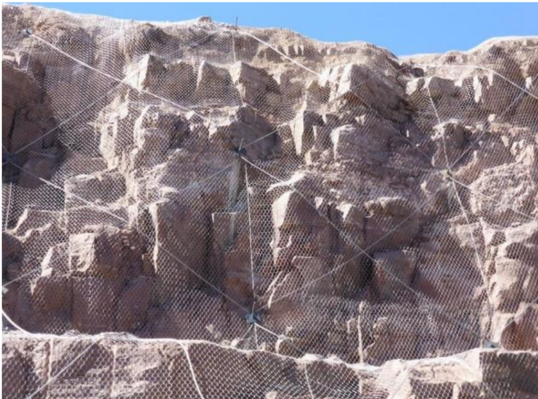
Figura 23. Ejemplo de implementación de mallas ancladas para el control de caída de rocas o bloques rocosos.
