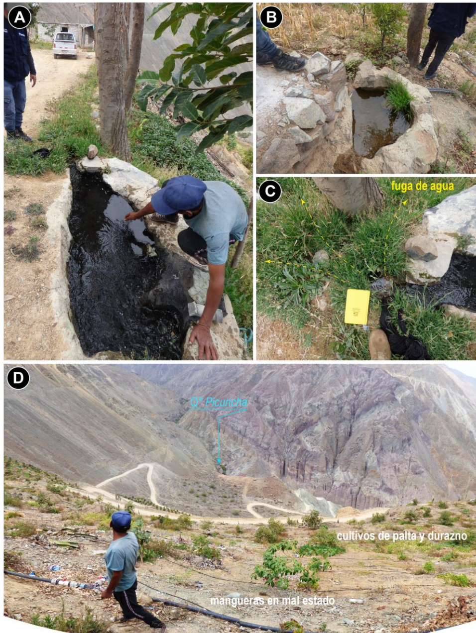
Figura 15. A), B) y C) Puntos de captación y almacenamiento de agua en cubetas de concreto pobremente revestido, en donde se observa filtraciones y fugas de agua hacia la ladera inestable. D) Mangueras de PVC en mal estado que son usadas para riego de cultivos de árboles.
