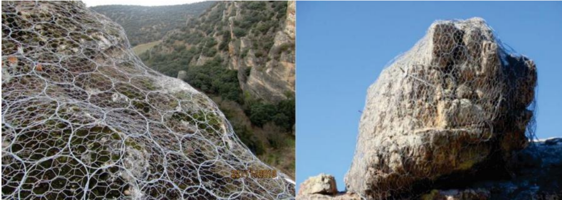
Figura 24. Ejemplo de estabilización de rocas o bloques rocosos con red de anillos.
