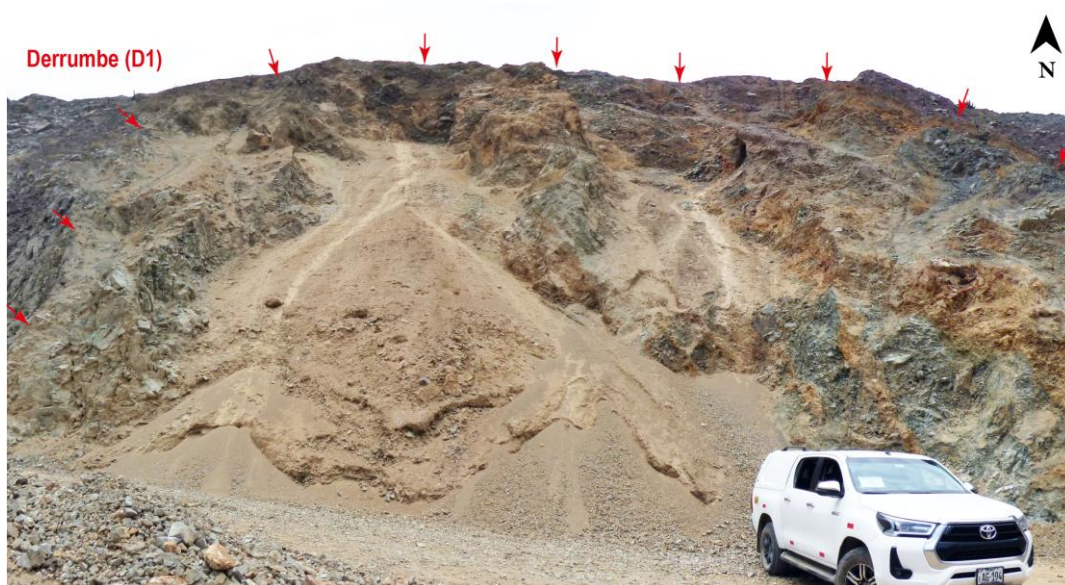
Figura 14. Derrumbe (D1) que se activó el 22 de abril del 2023. Este evento afectó la carretera que da acceso a la comunidad de Muzga.
