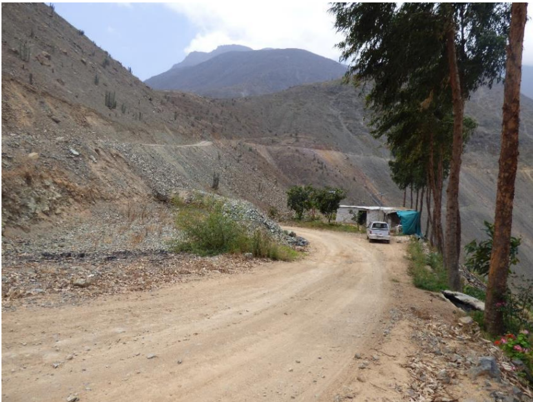
Fotografía 1. Vivienda ubicada en la parte media de la ladera del cerro Jaracoto que queda expuesta antes la ocurrencia de movimientos en masa.
