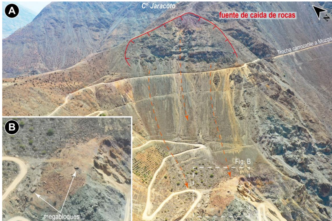
Figura 16. A) Al fondo se observa la fuente de rocas propensas a caída en la parte alta del cerro Jaracoto. B) Las evidencias de bloques caídos se aprecian ladera abajo, justo en la cresta del depósito de un deslizamiento antiguo.
