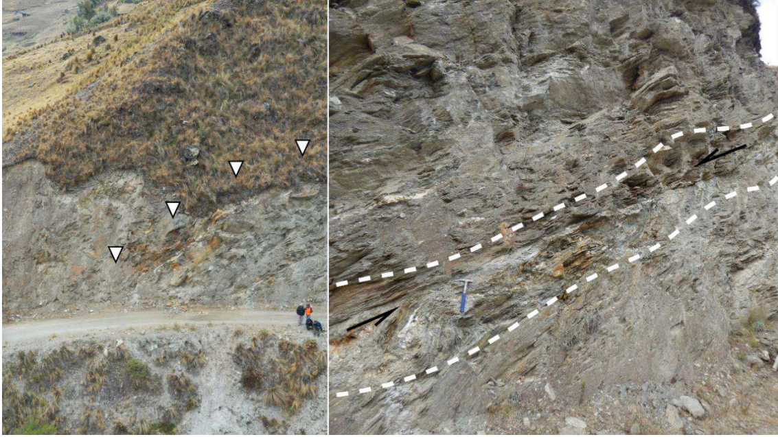
Figura 26: Zona de debilidad (zona de cizalla) observada en esquistos, demarcada en líneas entrecortadas blancas, que condiciona los derrumbes en la carretera Sogobamba - San Juan de Quiru Quiru. Coordenadas referenciales UTM WGS-84, 18S E:318965, N:8946385.
