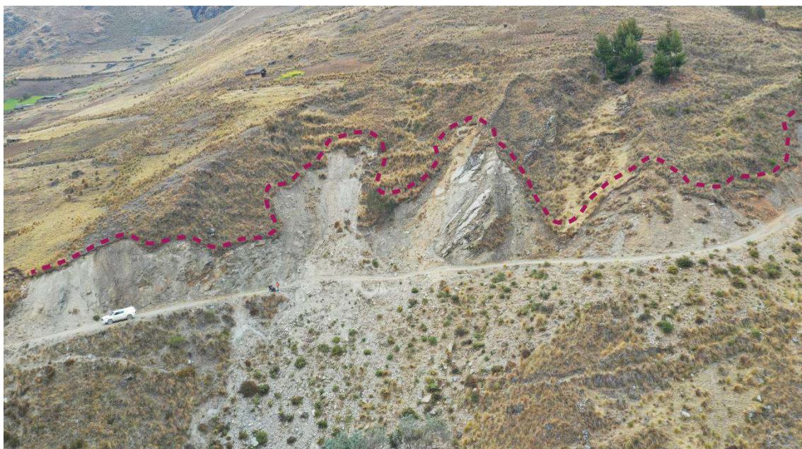
Figura 25: Zona de arranque (líneas entrecortadas) de varios procesos de derrumbes los cuales afectan principalmente la carretera Sogobamba y San Juan de Quiru Quiru, específicamente en la progresiva 6+700.
