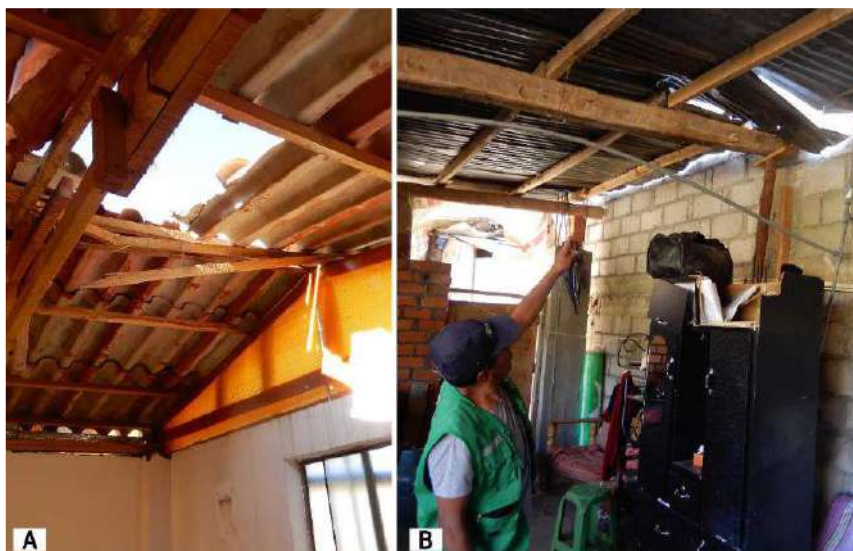
Fotografía 04: Vestigio del impacto de la caída de roca en el techo de hospedaje "Vista Alegre Izcuchaca". Coordenadas referenciales UTM WGS-84, 18S: E: 500368; N: 8618026. B. Techo de vivienda continúa al hospedaje y de igual forma, afectado por la caída de roca reciente.
