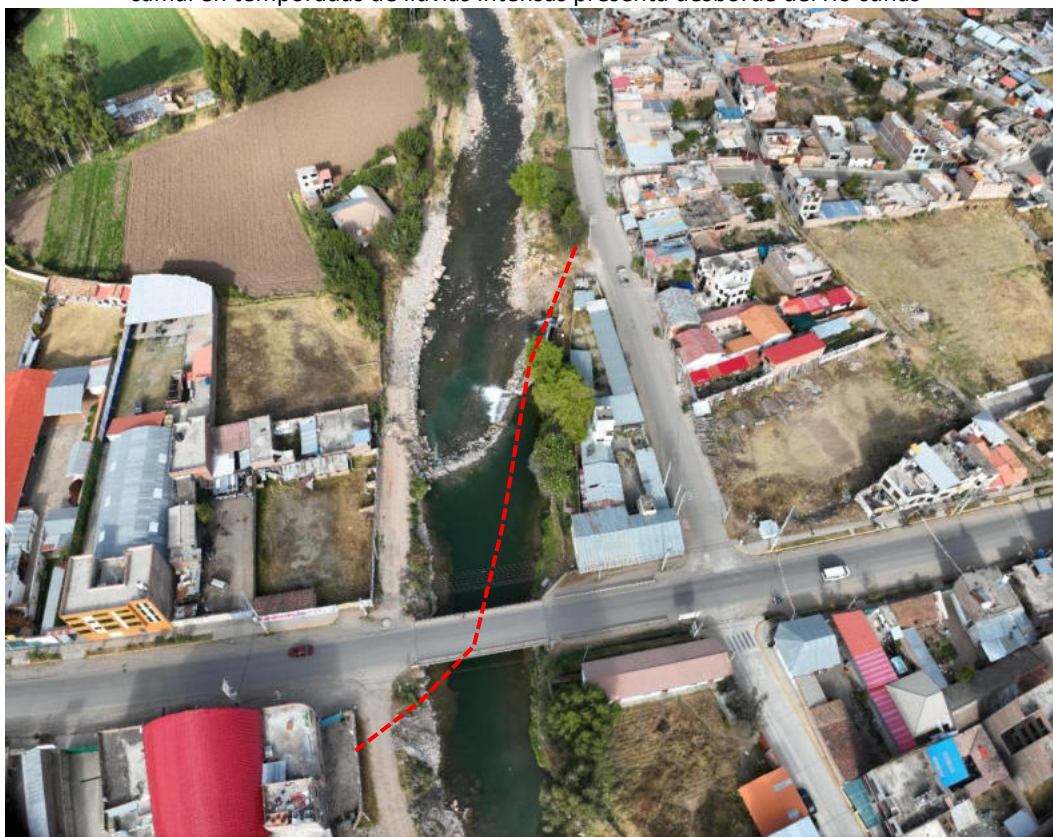
Imagen N° 26: A consecuencia para la captación de agua a la altura del camal en temporadas de lluvias intensas presenta desborde del río cunas
