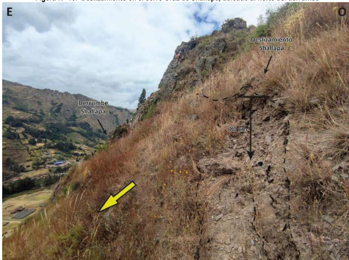
Figura N° 13. Deslizamiento en el cerro Cruz de Shallapa, ubicado al norte del derrumbe
