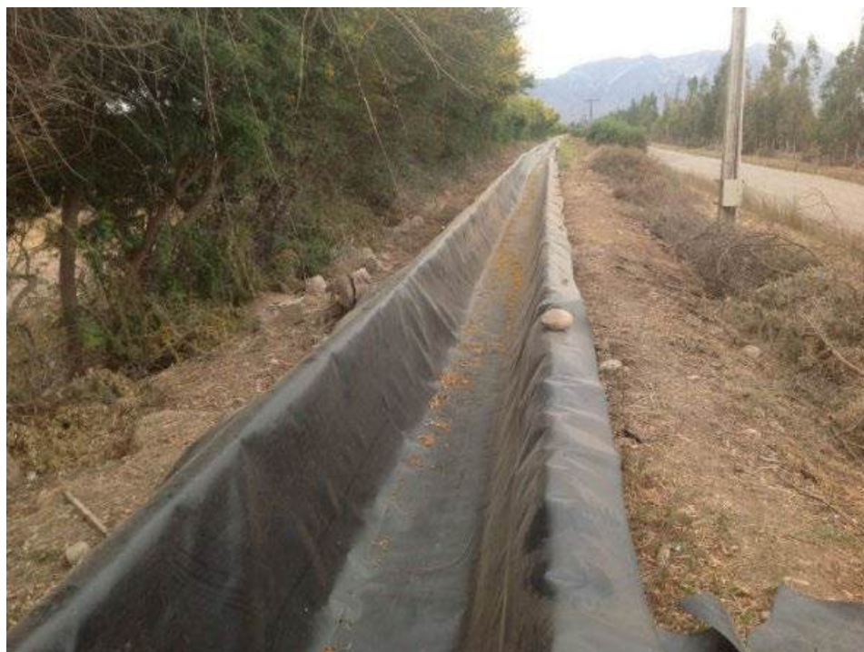
Figura 13: Zanja de coronación impermeabilizada
