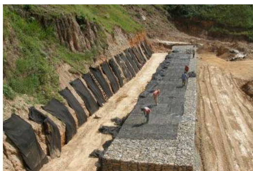
Figura 17: Ejemplo de instalación de muros de gaviones drenantes.
