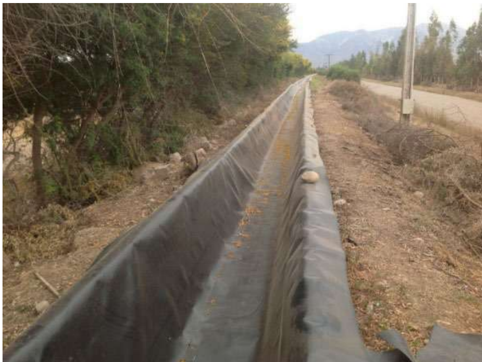
Figura 15: Zanja de coronación impermeabilizada
