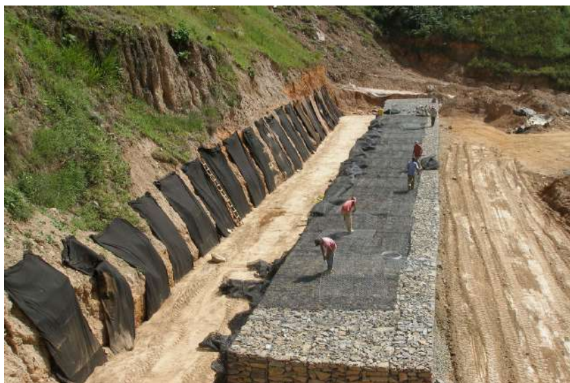
Figura 19: Ejemplo de instalación de muros de gaviones drenantes.
