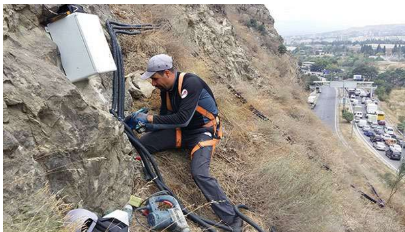
Figura 20: Ejemplo de instalación de sistema de monitoreo.
