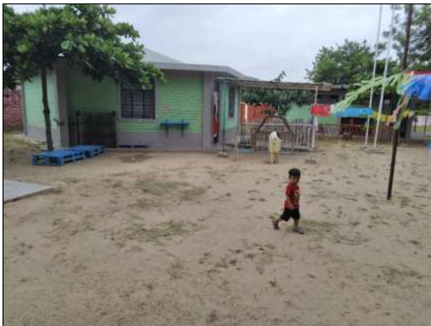
Foto 11. I.E.I. N° 314, ambiente usado como aula, construcción de material noble, techo aligerado apoyado en elementos estructurales de concreto, puertas y ventanas de fierro con vidrio
