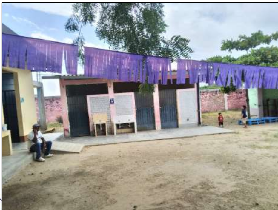
Foto 10. I.E.I. N° 314, vista de SS. HH., construcción de material noble, techo de calamina apoyado en estructura metálica, puertas y ventanas de fierro con vidrio y muros de concreto
