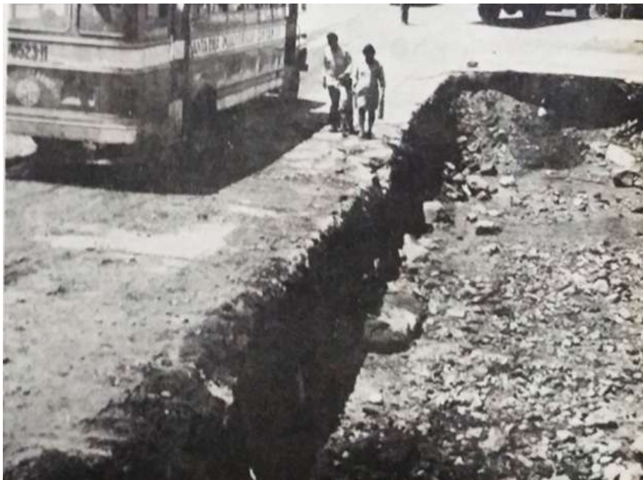
Arequipa, 08/03/1972. En la imagen se aprecia una extensión de vía de 40 m de largo por 12 m de ancho, destruida debido a la activación de la torrentera de Mariano Melgar a la altura del colegio La Gran Unidad Escolar (Diario El Pueblo).
