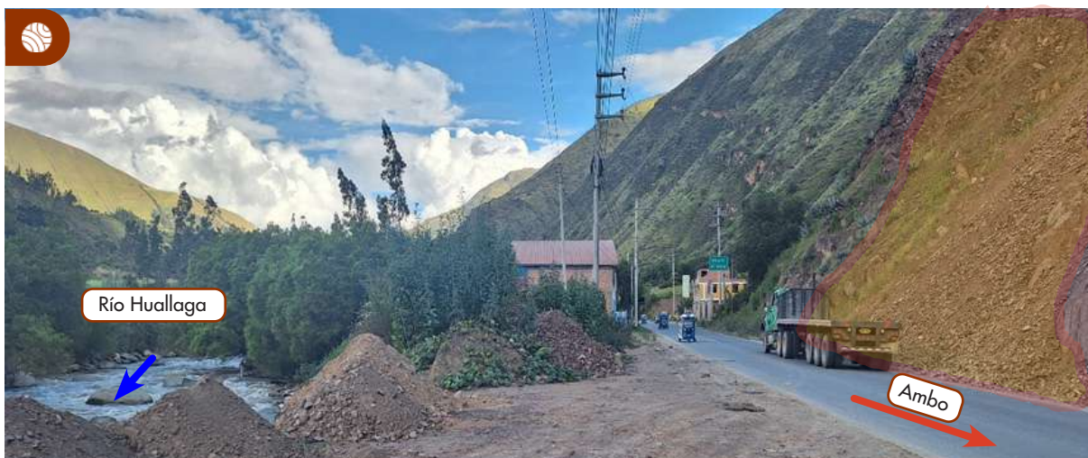
Figura 33. La activación de este evento geodinámico afecta la vía que une los distritos de San Rafael con Ambo. El material deslizado se acumula en el río Huallaga. La flecha azul indica la dirección del flujo del río Huallaga.
