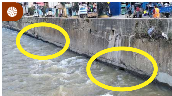
Figura 39. Parte de la estructura del río Huallaga se encuentra en proceso de erosión. Esto podría generar infiltración y socavamiento en la estructura, así como su posterior colapso.
