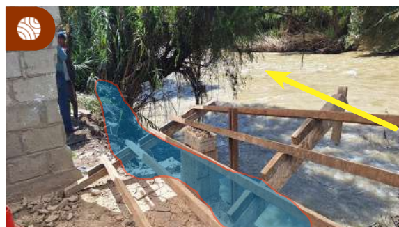
Figura 40. Proceso de erosión fluvial en la margen izquierda del río Huertas que afectó áreas agrícolas e infraestructura (colapso de la estructura). La flecha en amarillo indica la dirección de flujo del río en mención.
