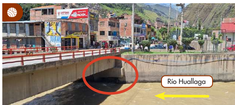
Figura 42. Proceso de erosión fluvial en la infraestructura del puente Ambo, margen derecha (círculo rojo). De acuerdo con la versión de los pobladores, cuando hay lluvias intensas se filtra agua, lo cual genera agrietamiento en el pavimento (indica flecha roja) que, posteriormente, es rellenado por la municipalidad.
