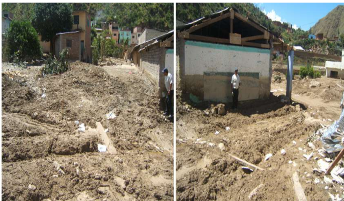
Figura 9. Altura de flujo (línea roja), tal como se observa en la huella en la pared lateral del colegio.
