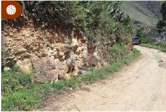
Figura 20. Depósitos aluviales antiguos conformados por clastos de roca de diferente origen. Sobre este depósito se asienta parte del área urbana de Ambo.
