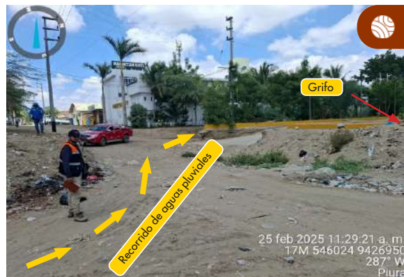
Figura 15. Las aguas pluviales recorren el desde pontón situado en Av. Guardia Civil hacia el A. H. Ricardo Palma, pudiendo afectar un grifo y un hotel contiguos durante periodo de máximas avenidas. Como medida preventiva, se elevó en aproximadamente un metro el nivel del piso terminado, con el fin de evitar inundaciones.
