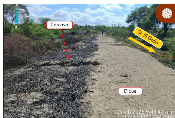
Figura 19. Obstrucción del cauce de la quebrada El Gallo desde el año 2024, aproximadamente, debido a la construcción de una vía de acceso ejecutada por la población. Esta intervención podría retener el flujo de agua en este sector y generar inundaciones aguas arriba.
