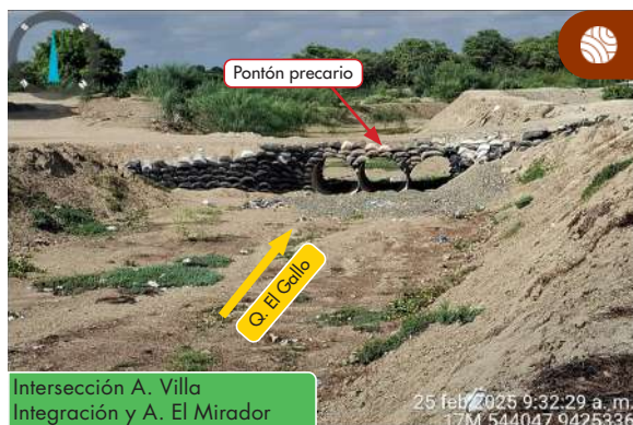
Figura 20. Se aprecia la quebrada El Gallo encauzada mediante diques conformados en ambos márgenes. En la parte superior de la figura se observa el cauce cubierto por vegetación, mientras que en la parte inferior se muestra un pontón precario, conformado con sacos de arena y alcantarillas TMC deformadas, que restringe el cauce.
