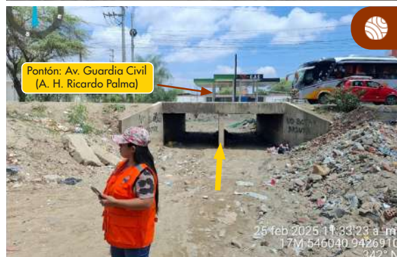
Figura 14. La imagen superior muestra el recorrido de aguas pluviales, desde los AA. HH. Alas Peruanas y Violeta Ruesta hacia pontón situado debajo de la Av. Guardia Civil (A. H. Ricardo Palma) de la imagen inferior.
