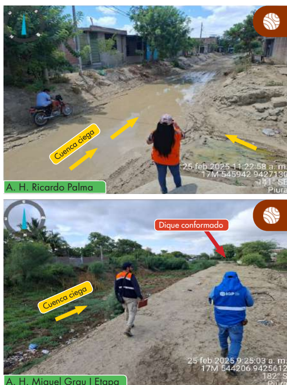
Figura 6. Unidad geomorfológica cuenca ciega que colecta las aguas de escorrentía pluvial del extremo noreste de Castilla, dando origen a la quebrada El Gallo durante las épocas de lluvias intensas (diciembre-mayo). La imagen superior corresponde a las nacientes de la quebrada en el A. H. Ricardo Palma, mientras que la inferior corresponde al A. H. Miguel Grau, donde se visualiza el dique de encauzamiento.
