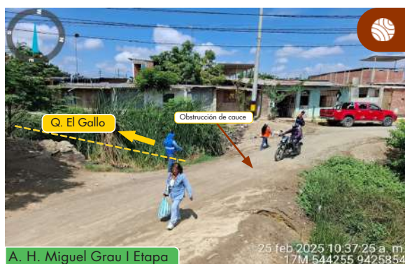
Figura 19. Obstrucción del cauce de la quebrada El Gallo desde el año 2024, aproximadamente, debido a la construcción de una vía de acceso ejecutada por la población. Esta intervención podría retener el flujo de agua en este sector y generar inundaciones aguas arriba.
