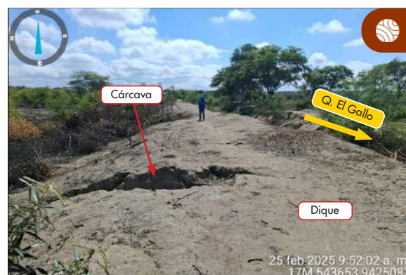
Figura 21. Cárcavas identificadas en el dique de protección situado en el margen derecho de la quebrada El Gallo (aguas debajo del sector asociación de vivienda Villa California) que evidencian ocurrencia del evento erosión en un tramo de aproximadamente 16 m de longitud, debido a las escorrentías superficiales durante los periodos de lluvias intensas.
